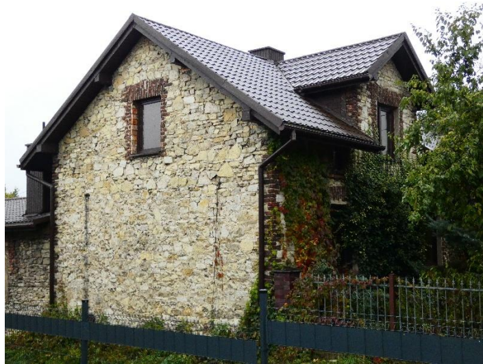
Fot. 1. Dom w Goląszy Dolnej wzniesiony z kamiennego wapienia
