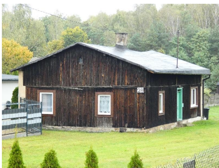
Fot. 9. Dom w Psarach – przykład architektury drewnianej
