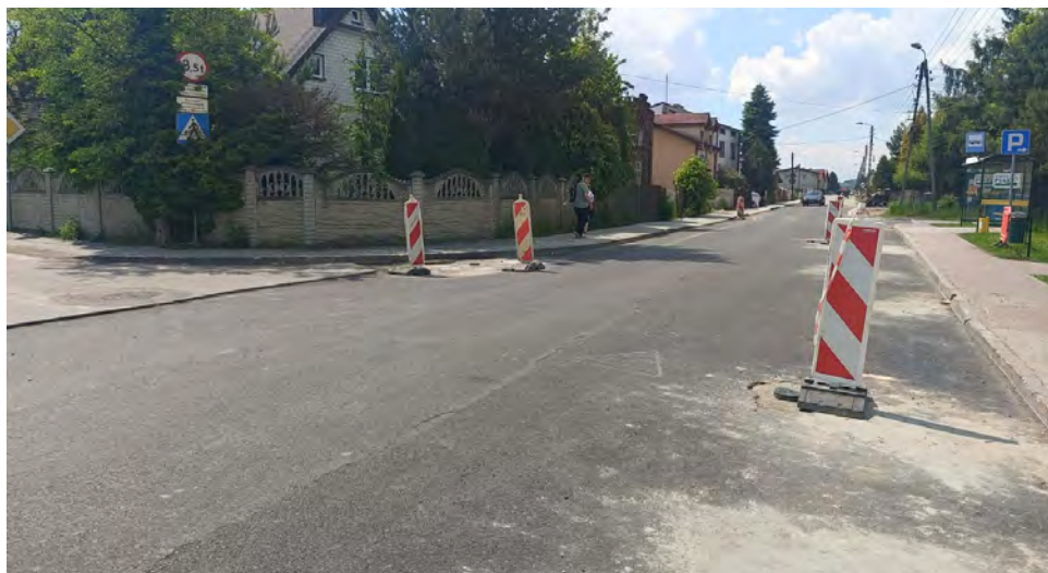
Trwają prace na ulicy Szkolnej w Psarach
