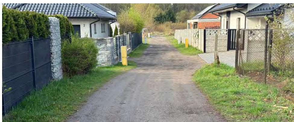
Wkrótce ruszy przebudowa drogi na cmentarz w Preczowie
