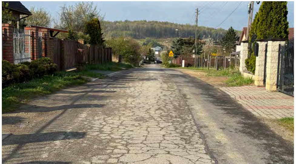
Już wkrótce ruszy przebudowa ulicy Kolejowej w Psarach
