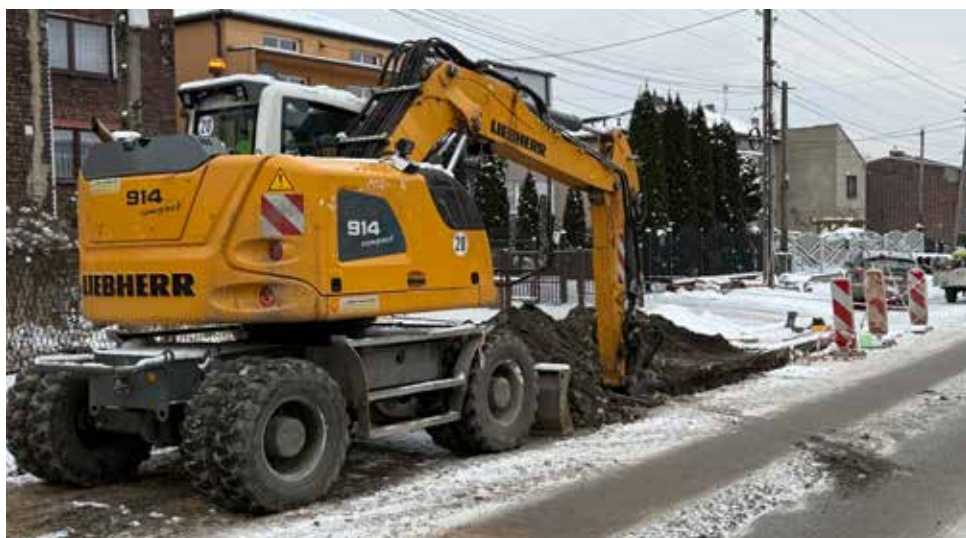
Prace prowadzone są od ulicy Górnej do Prodlą
