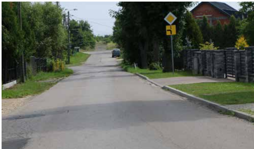
Inwestycja obejmie blisko kilometrowy odcinek drogi
