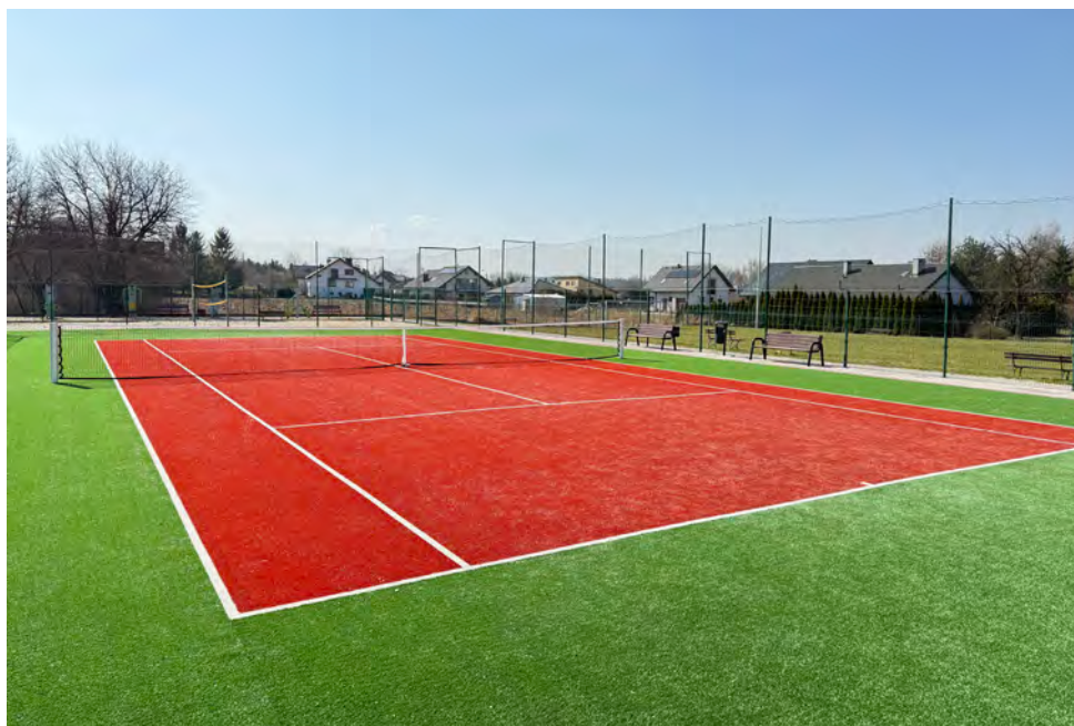
Stara, zużyta nawierzchnia została zastąpiona nową ze sztucznej trawy
