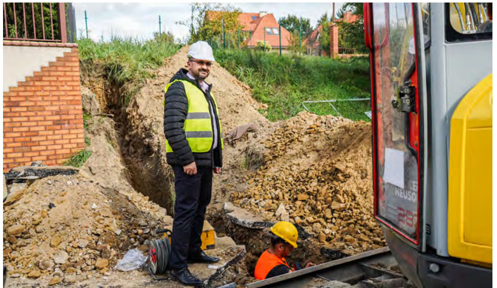
W tym roku planowane jest podłączenie ponad 220 posesji do sieci kanalizacyjnej
