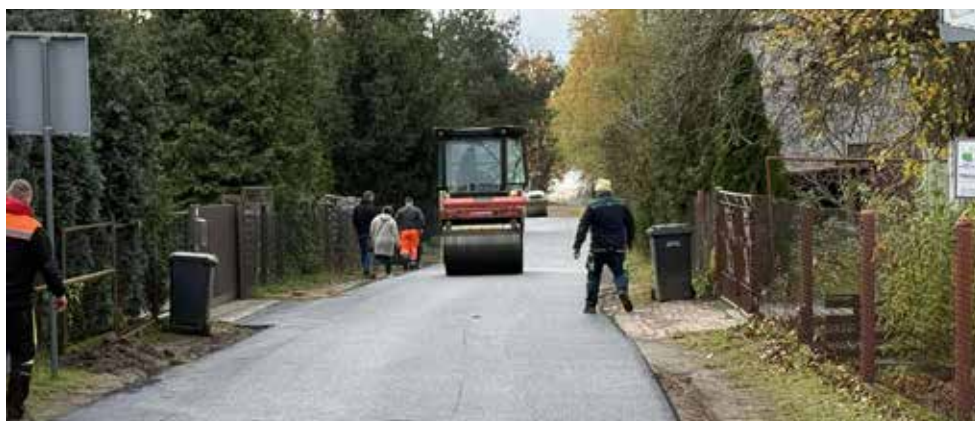
Na ulicy Akacjowej w Psarach położony został nowy asfalt
