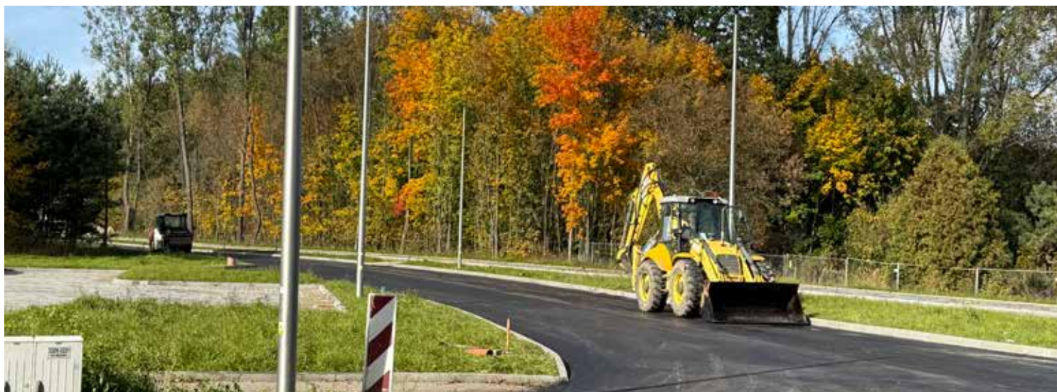
Przy centrum pojawiła się również nowa nawierzchnia asfaltowa prowadząca do osiedla SIM
