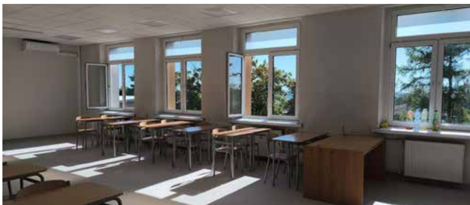
Szkoła w Dąbiu przeszła gruntowny remont II piętra
