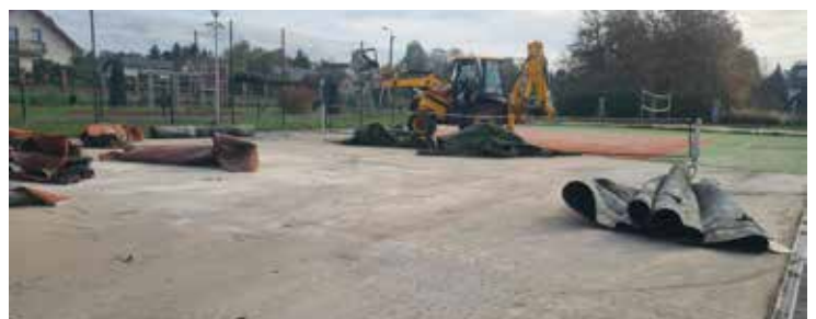
Inwestycja rozpoczęła się w październiku
