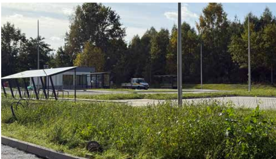
Na terenie centrum przesiadkowego zamontowano już wiaty przystankowe
