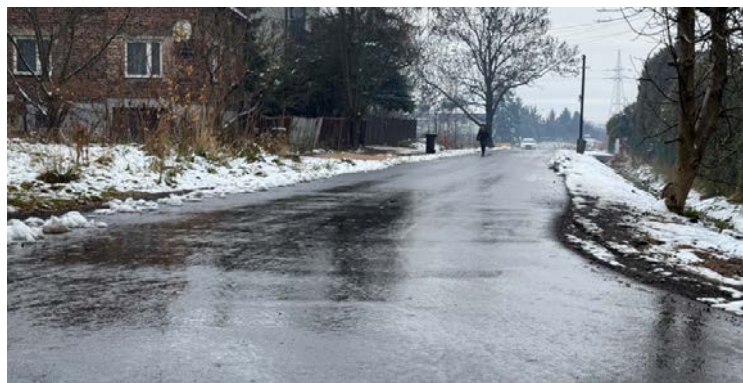
Ulice Jasna i Źródłana przeszły gruntowny remont
