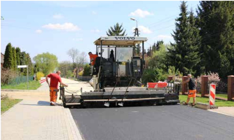
Na ulicy Głównej w Sarnowie trwają prace wykończeniowe
