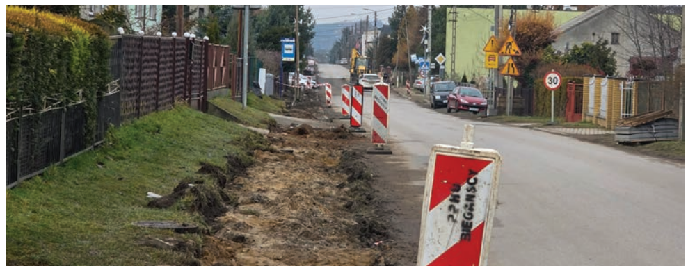
Obecnie trwają prace w okolicy szkoły w Psarach
