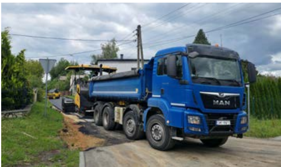
Kolejne odcinki gminnych dróg są modernizowane
