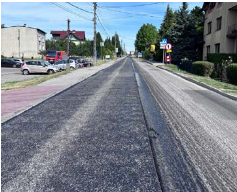
Nowa nakładka asfaltowa na ul. Belnej w Strzyżowicach
