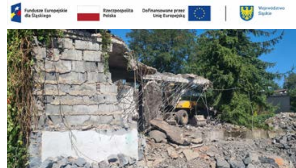
Na terenie byłej bazy Zakładu Gospodarki Komunalnej trwają prace rozbiórkowe
