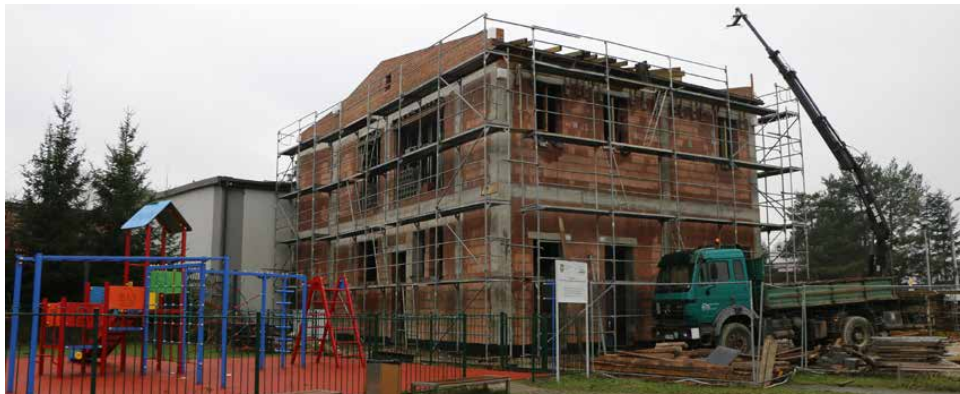
W ostatnim czasie wymurowano ściany pierwszego piętra
