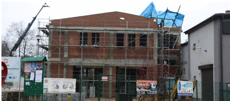
Obecnie trwają prace nad wykonaniem dachu
