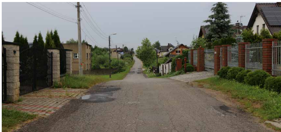
Na ulicy Kolejowej w Psarach powstanie kanalizacja sanitarna
