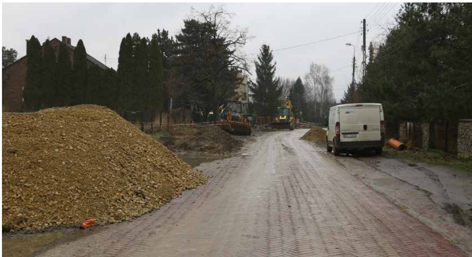
W styczniu rozpoczęły się prace na ulicy Głównej w Sarnowie
