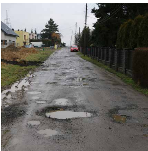
Wkrótce rozpoczną się prace na ulicy Kamiennej w Sarnowie
