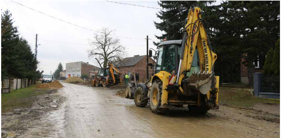
Na ulicy Głównej w Sarnowie wykonana zostanie nowa nakładka asfaltowa
