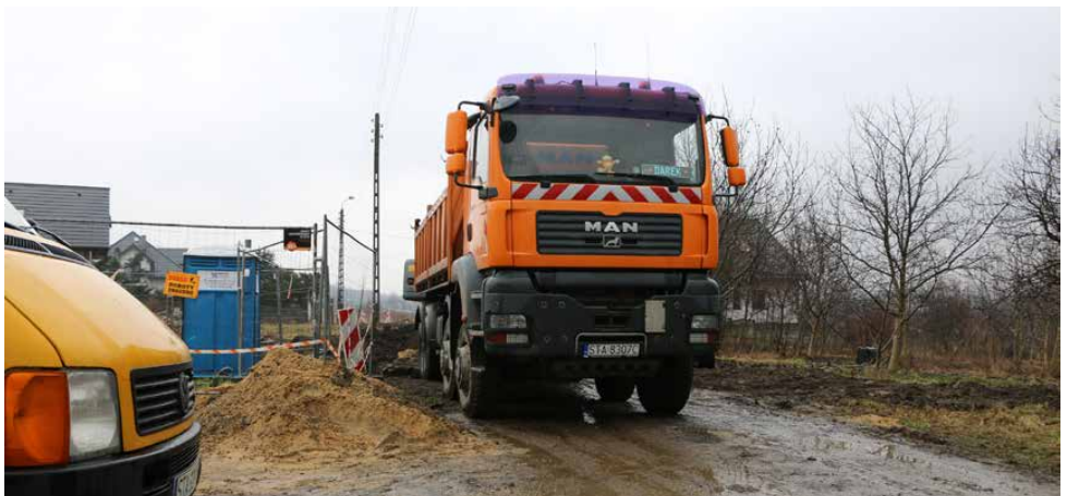
Na blisko 170 m ulicy Cichej pojawi się nowa nawierzchnia z kostki betonowej
