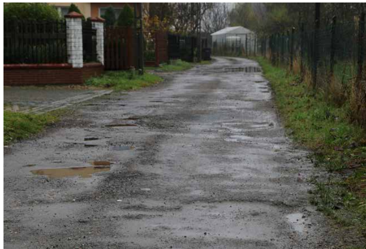
Nowa nawierzchnia pojawi się na około 170 m odcinku jezdni
