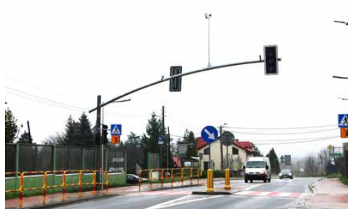
SYGNALIZACJA ŚWIETLNA PRZY SZKOLE PODSTAWOWEJ W GRÓDKOWIE
