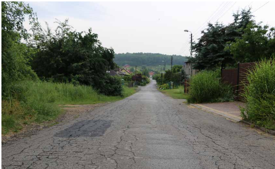
Ulica Kolejowa w Psarach zostanie przebudowana po wykonaniu w niej kanalizacji i wodociągu
