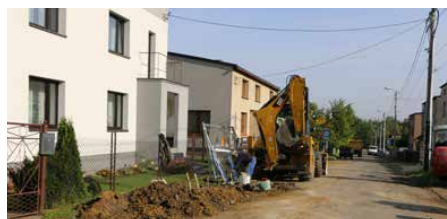
Prace prowadzone są metodą przewiertu sterowanego
