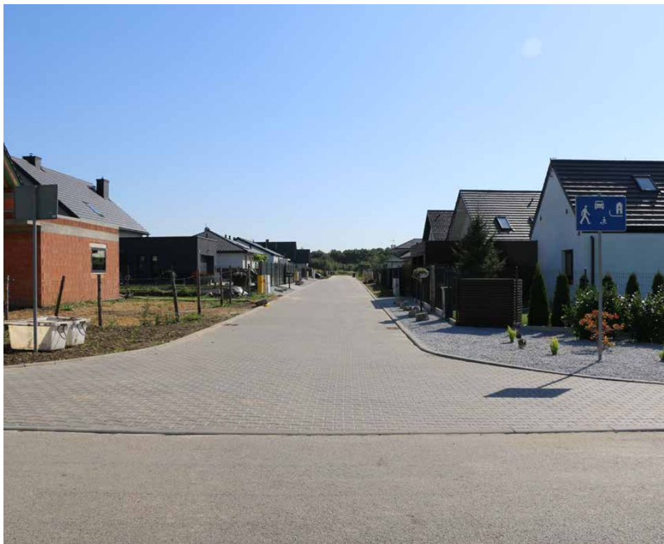
Na ulicy Kalcytowej w Górze Siewierskiej pojawiła się nowa nawierzchnia
