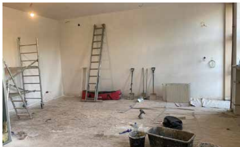
TRWA REMONT POMIESZCZEŃ W GOK-U
