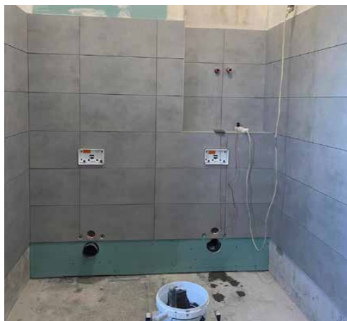
Na ścianach łazienki układane są płytki
