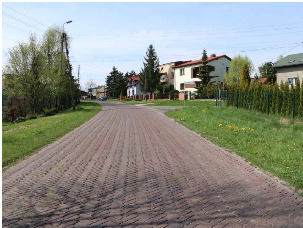
Przed nami przebudowa ulicy Głównej w Sarnowie
