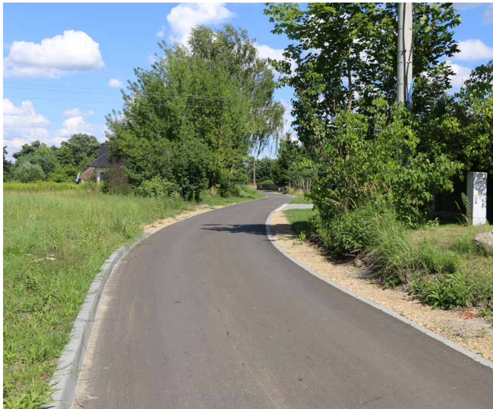
W tym roku przebudowaliśmy ulicę Brzeźną w Preczowie
