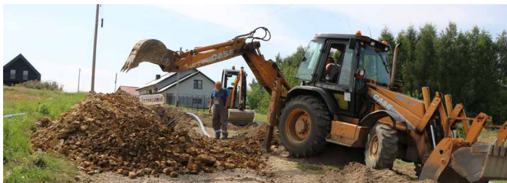
Pracownicy ZGK wykonują zadanie własnymi siłami
