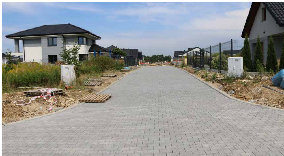
Na ulicy Kalcytowej w Górze Siewierskiej pojawiła się kostka betonowa
