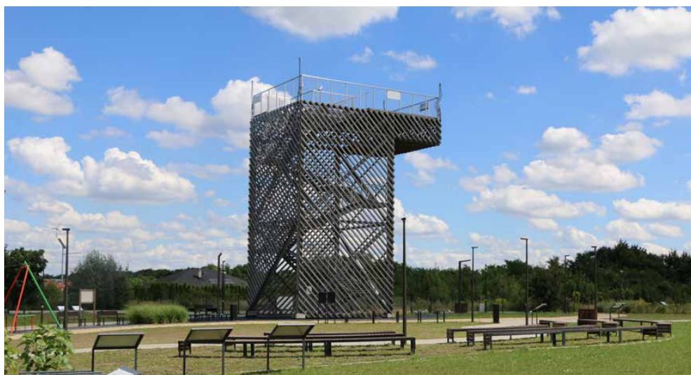
Na terenie Centrum Edukacji Ekologicznej w Górze Siewierskiej znajduje się 15 m wieża widokowa
