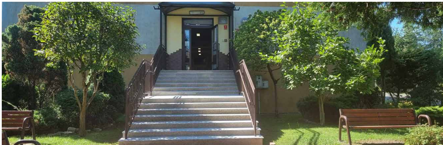
W Szkole Podstawowej w Psarach wymienione zostały schody wejściowe
