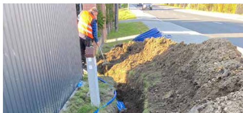
Wykonawca przebudował już 59 przyłączy
