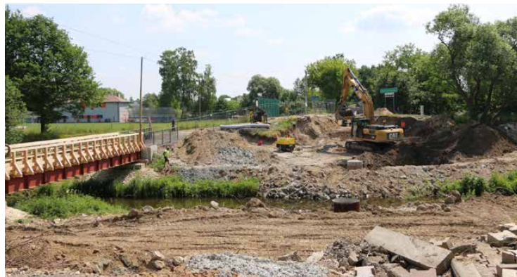
Trwa budowa konstrukcji nowego mostu
