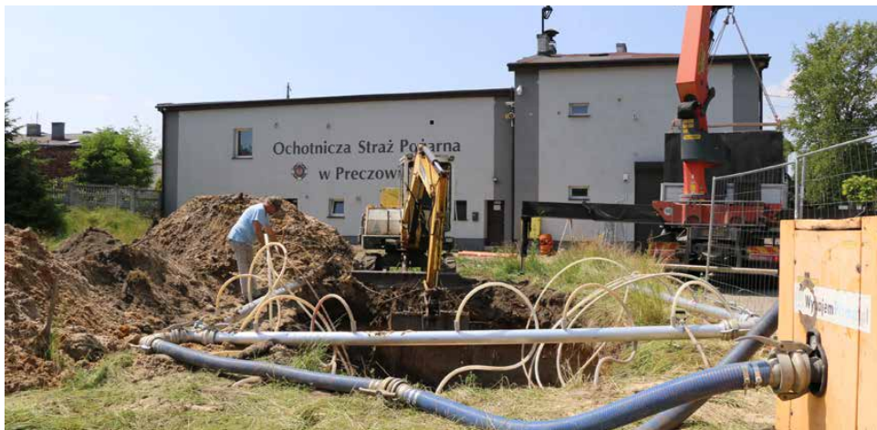
Obecnie trwają prace związane z budową instalacji kanalizacji sanitarnej
