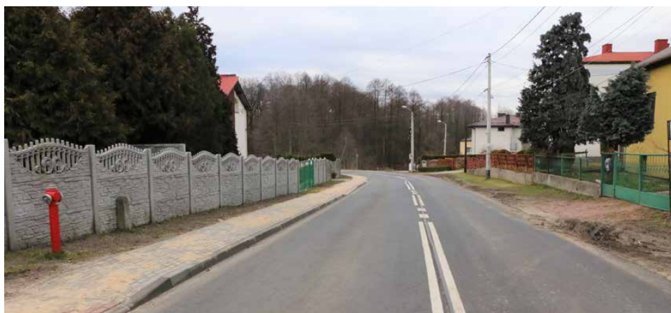
Wymieniono 755 m drogi oraz 307 m chodnika
