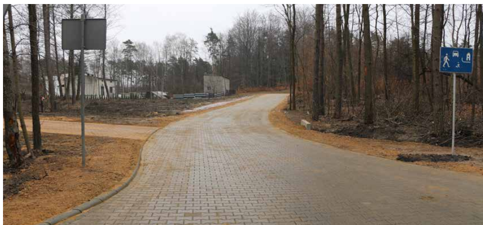
Na 355 m odcinku gminnej drogi pojawiła się nowa nawierzchnia z kostki brukowej
