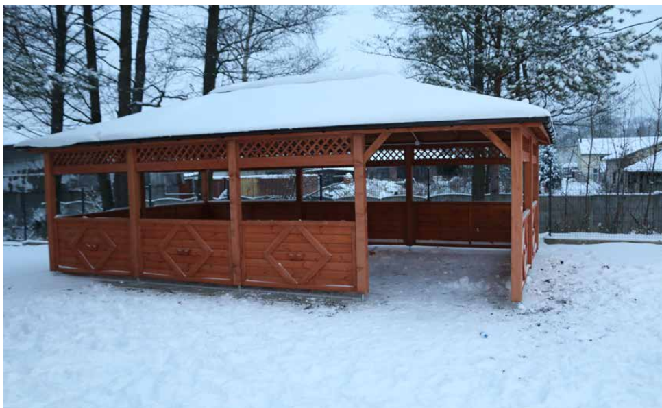
Przy OSP w Strzyżowicach zamontowano drewnianą altanę
