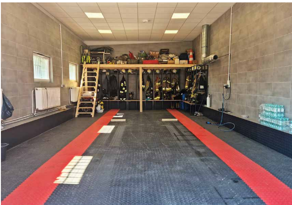
W garażu OSP na podłodze położono płytki speed floor
