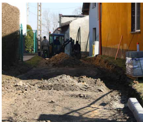
Łącznie zostanie wykonane 1625 mb nowych nakładek asfaltowych
