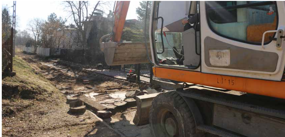
Roboty budowlane ruszyły na początku marca
