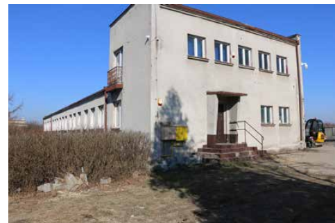
Już wkrótce budynek przejdzie modernizację
