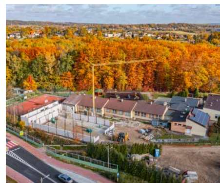
Budowa potrwa do czerwca przyszłego roku
