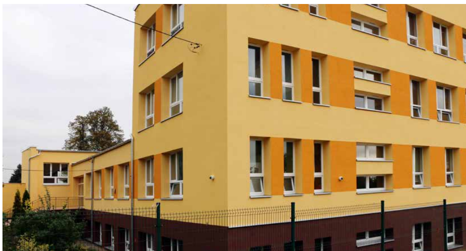
Szkoła w Strzyżowicach po termomodernizacji
