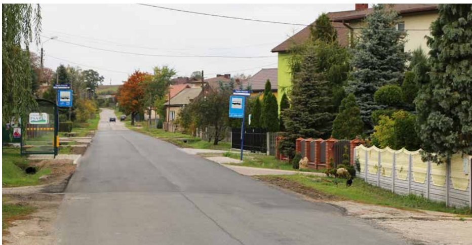
Nowa nawierzchnia na odcinku ul. Kościelnej w Dąbiu
