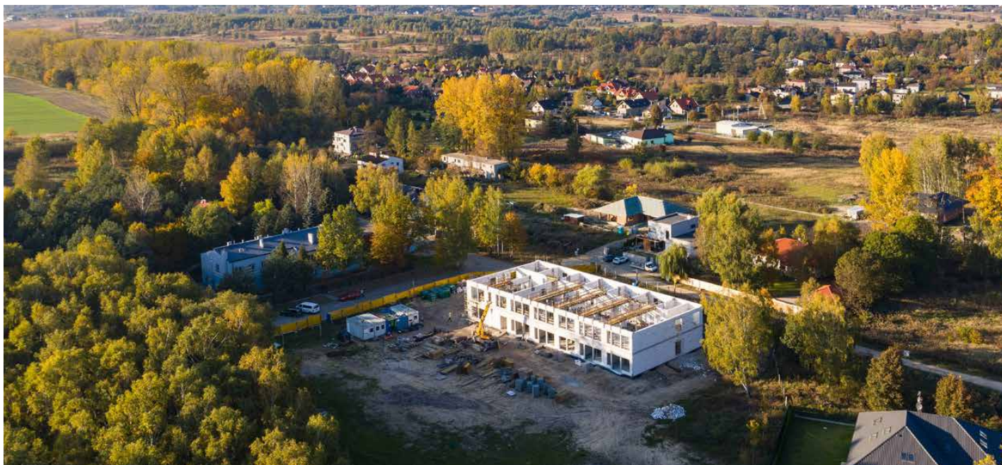
Budowa żłobka i przedszkola w Psarach
