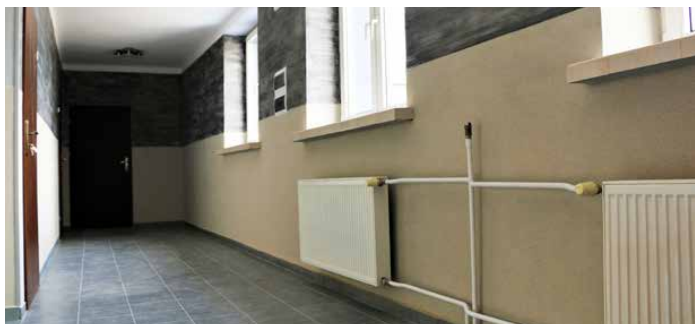
Remont objął korytarz na pierwszym piętrze
