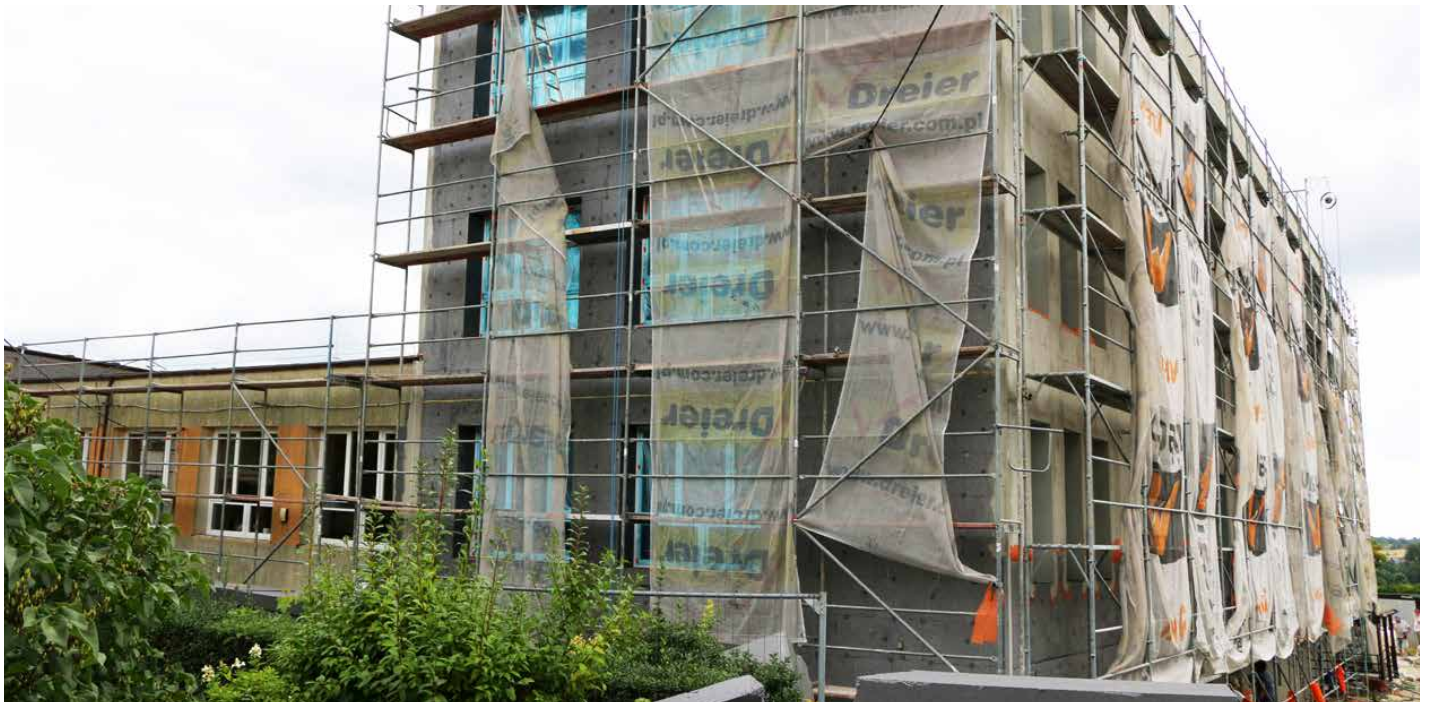
Trwają prace ociepleniowe na zewnątrz szkoły
