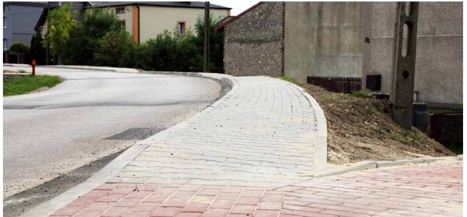
Na ul. Dolnej w Dąbiu chodnik jest już prawie gotowy
