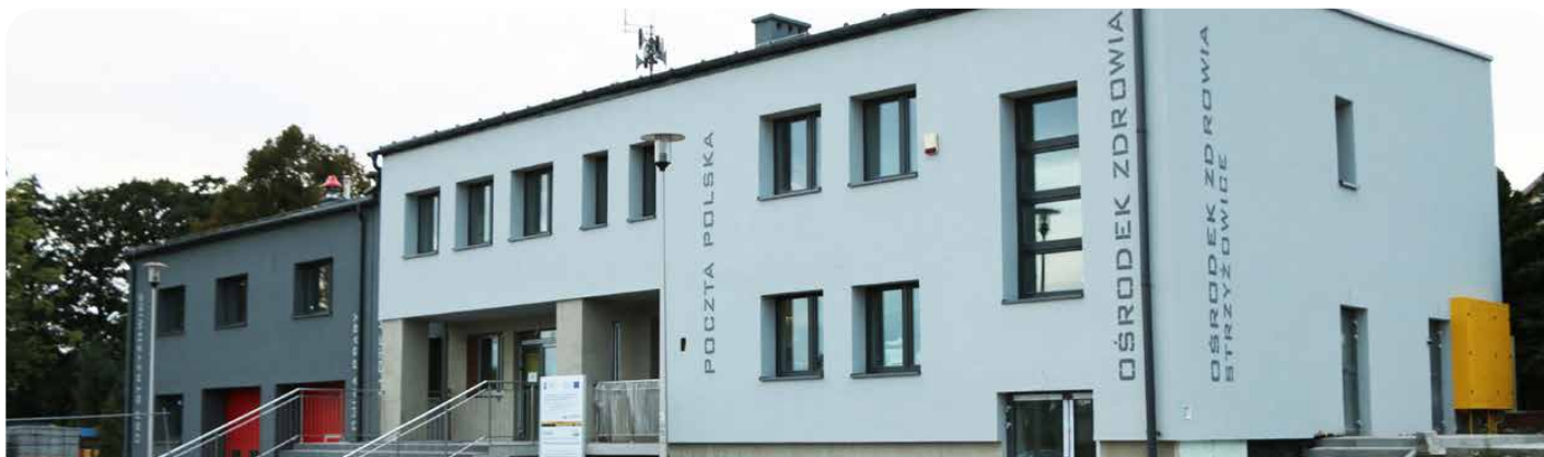
Trwa budowa Centrum Usług Społecznych w Strzyżowicach, które od listopada będzie służyć mieszkańcom gminy. Wartość inwestycji to 6 011 399,95 zł, z czego 1 951 625,1 zł stanowią pozyskane dofinansowania.
