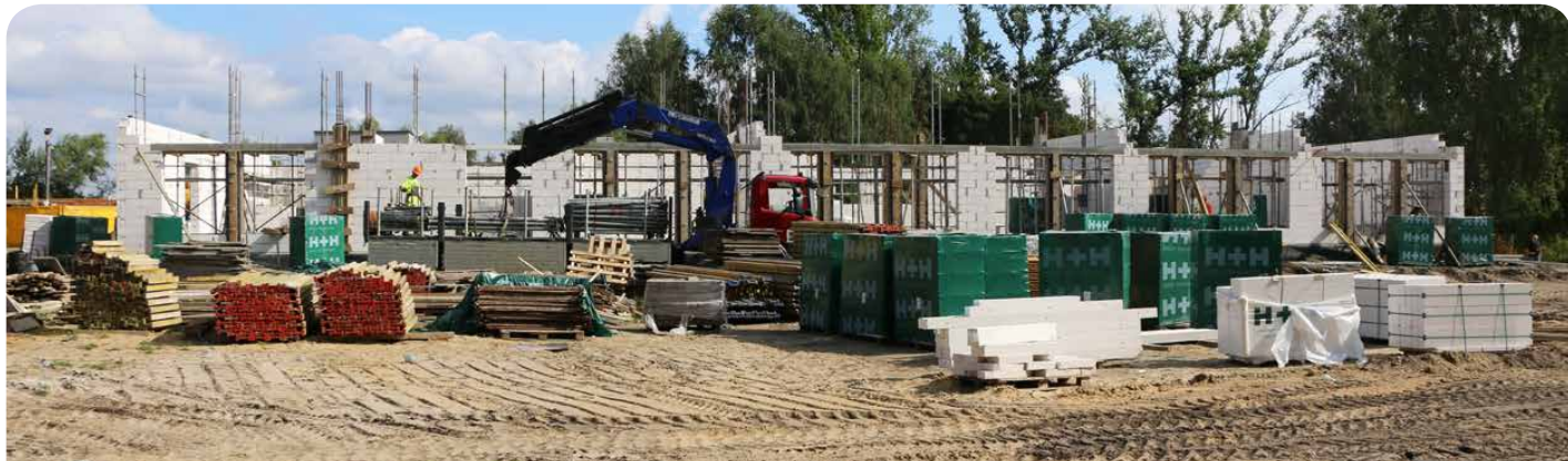
W maju ruszyła jedna z najważniejszych i największych inwestycji w gminie – budowa żłobka i przedszkola w Psarach. Koszt przedsięwzięcia to 6 696 158,04 zł.
