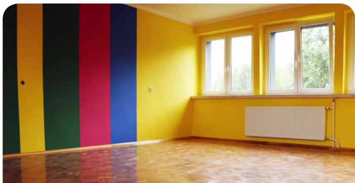
W Ośrodku Kultury w Dąbii wyremontowano piętro budynku, w tym korytarz, łazienki, pomieszczenia świetlicy i pokoje biurowe. Koszt inwestycji to 81 689,91 zł.
