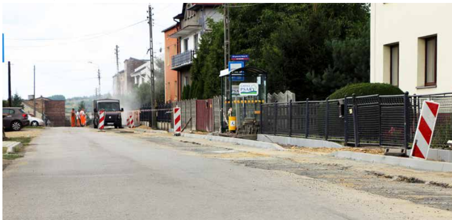
Trwają zaawansowane prace przy budowie chodnika na ul. Belnej w Strzyżowicach
