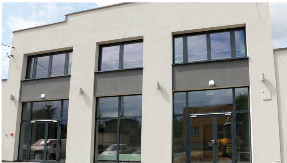
Budynek został ocieplony i ma nową elewację
