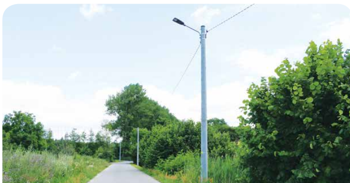
Nowe lampy LED oświetlają odcinki gminnych dróg w Psarach, Malinowicach, Dąbii Chrobakowym, Sarnowie i Strzyżowicach. Ich łączny koszt to 162 068,42 zł.
