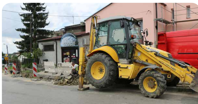
Urząd Gminy Psary wspólnie z powiatem będzińskim rozpoczął prace remontowo-budowlane przy drogach powiatowych w gminie Psary o łącznej wartości ok. 1,9 mln zł.
