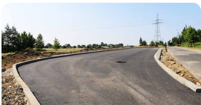
Wymiana asfaltu i budowa zatoki z miejscami parkingowymi dla ciężarówek na ul. Jasnej w Sarnowie. Przedsięwzięcie finansuje Gospodarstwo Ogrodnicze T. Mularski.
