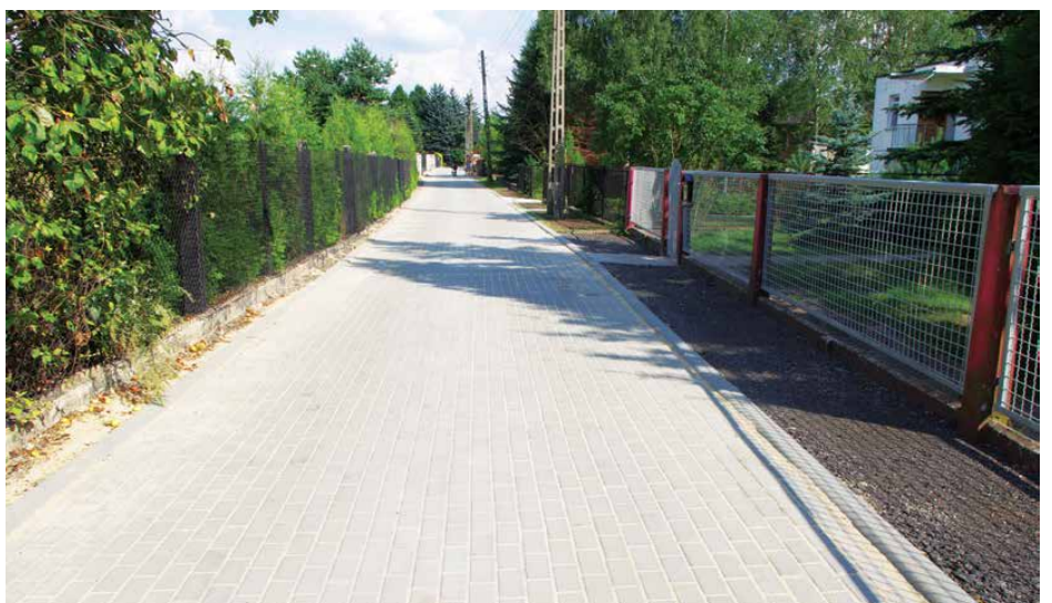
Nowa nawierzchnia została wykonana z kostki brukowej
