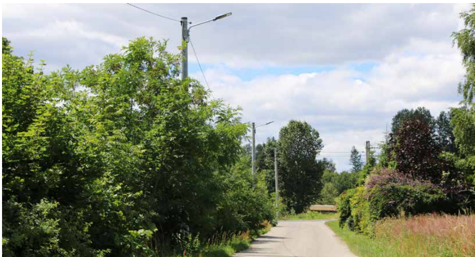
Oświetlenie uliczne LED w Strzyżowicach
