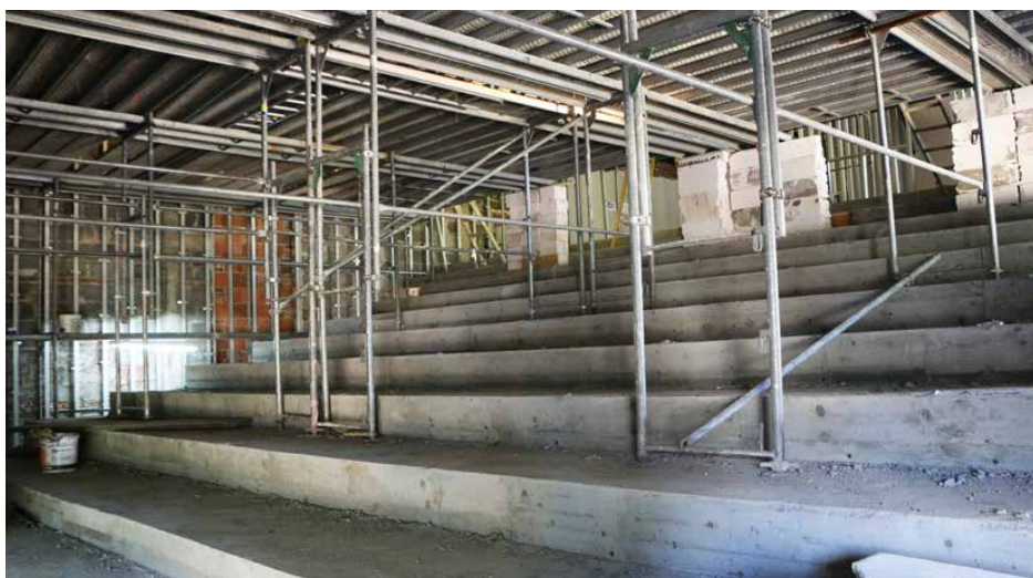
W sali wielofunkcyjnej powstaje pochyła widownia
