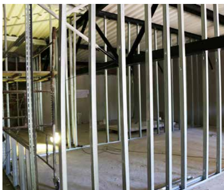
Prace wewnątrz budynku
