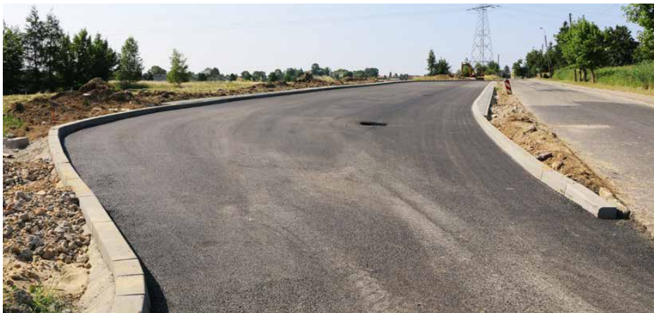
Prace na ul. Jasnej - nowa nawierzchnia asfaltowa
