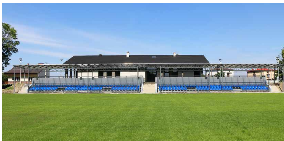
Na stadionie znajdują się nowe zadaszone trybuny dla 192 widzów
