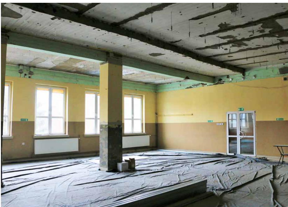
W sali bankietowej zdemontowano stary sufit
