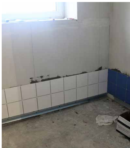
W pomieszczeniach na parterze rozpoczęto układanie płytek
