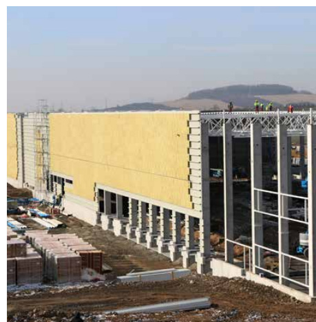
Trwa budowa pierwszej hali
