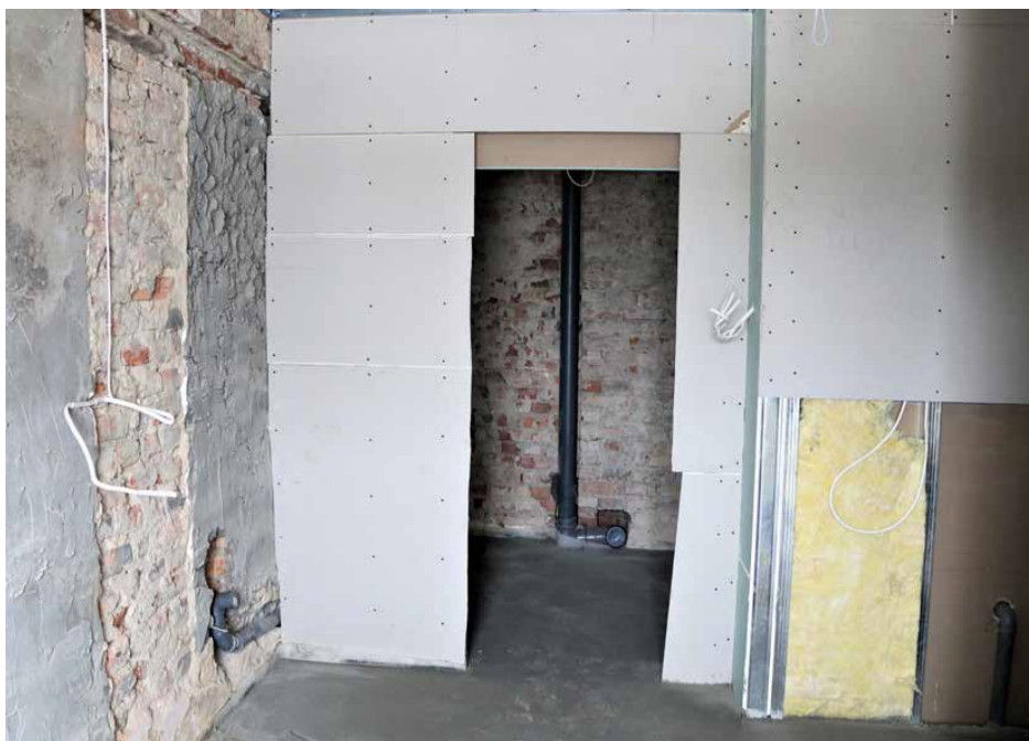
Na ścianach ułożono instalację elektryczną
