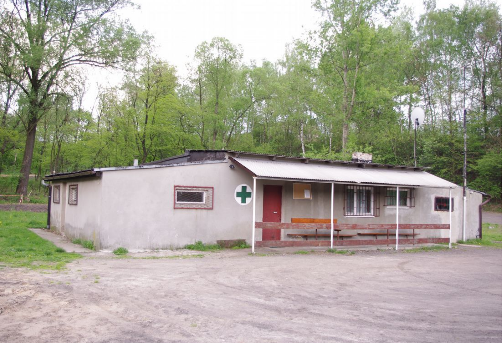
Budynek szatni KS Góra Siewierska – stan obecny.
