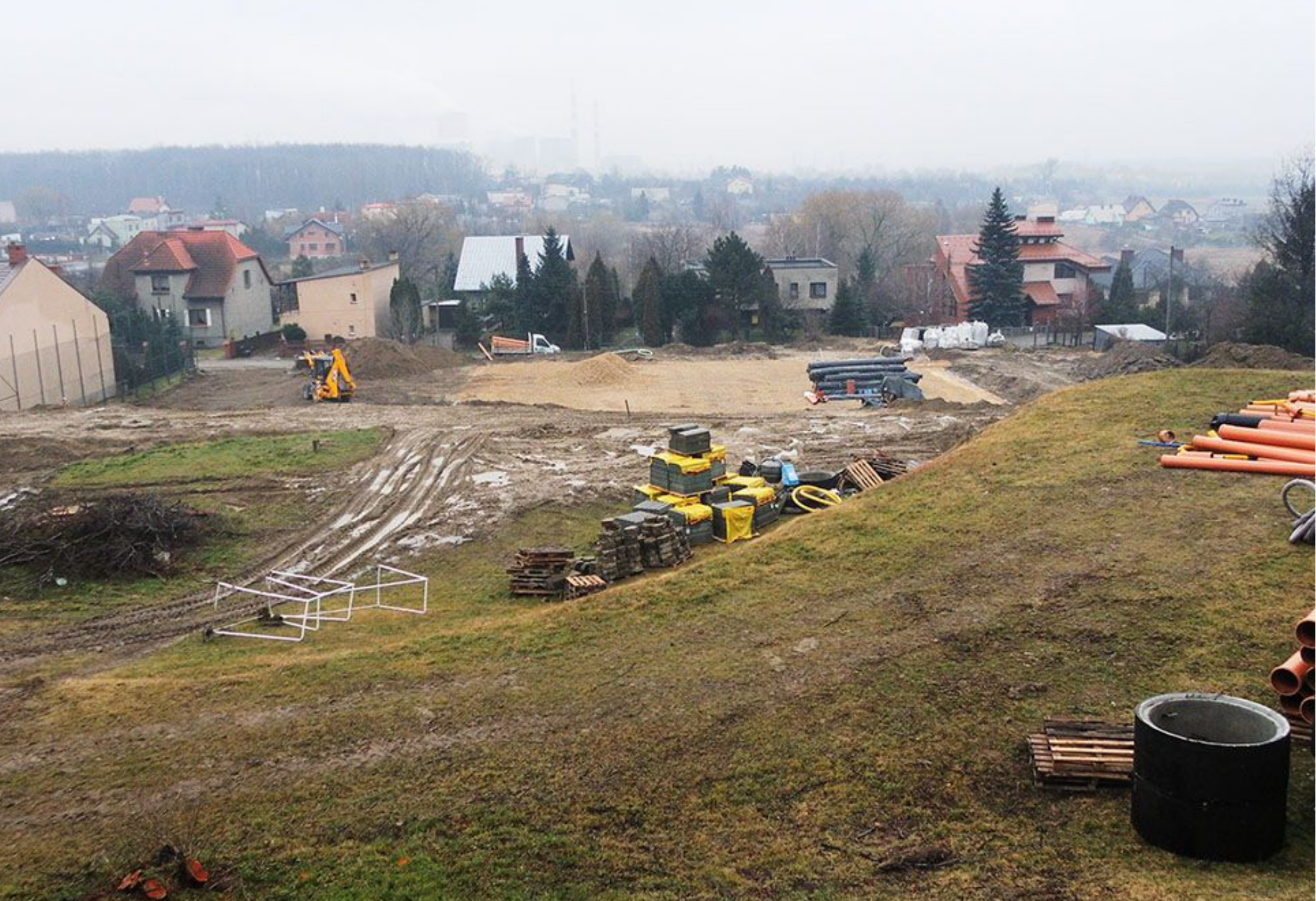
W trakcie prac przy szkole w Sarnowie.
