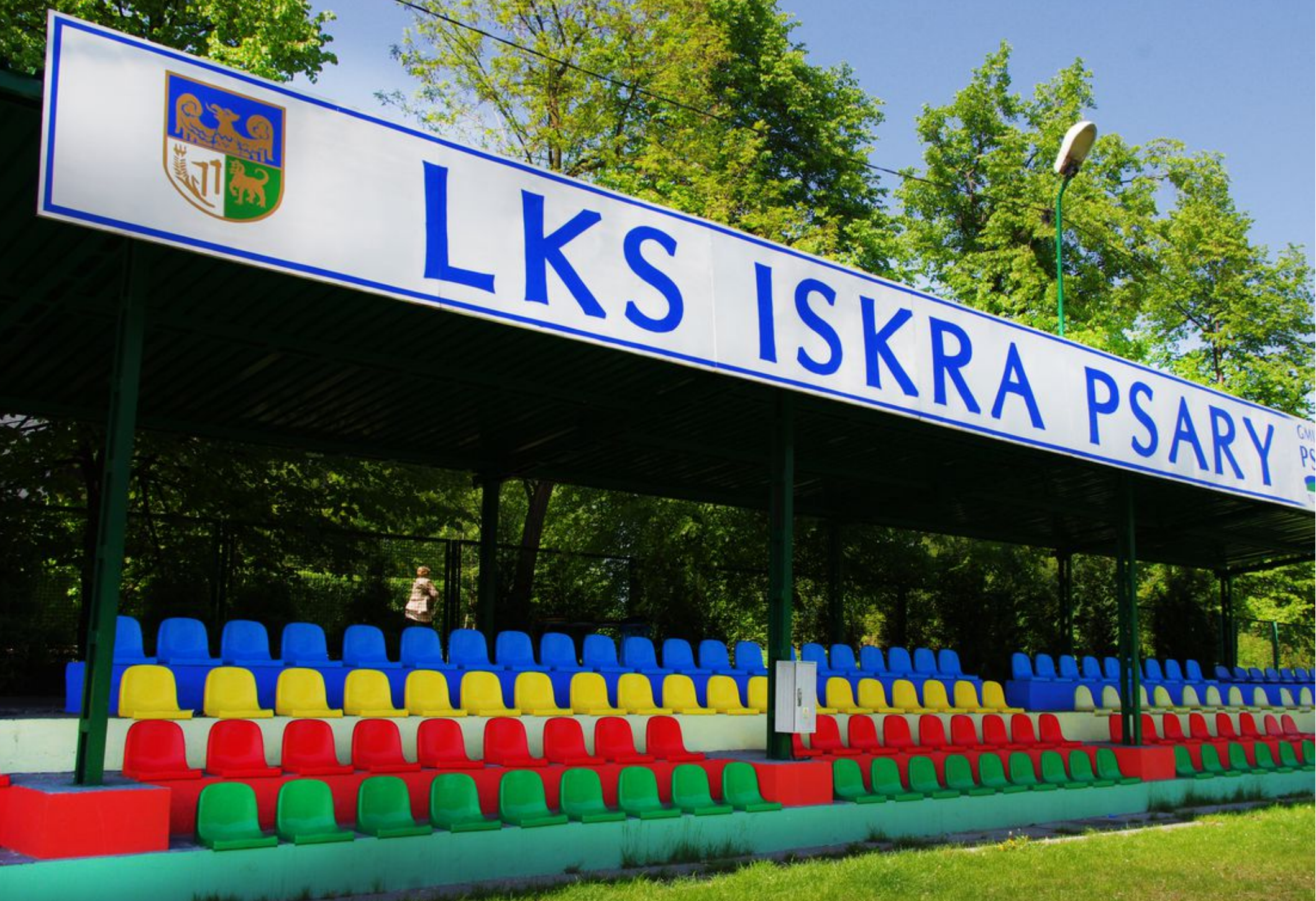
Trybuna stadionu w Psarach po remoncie.
