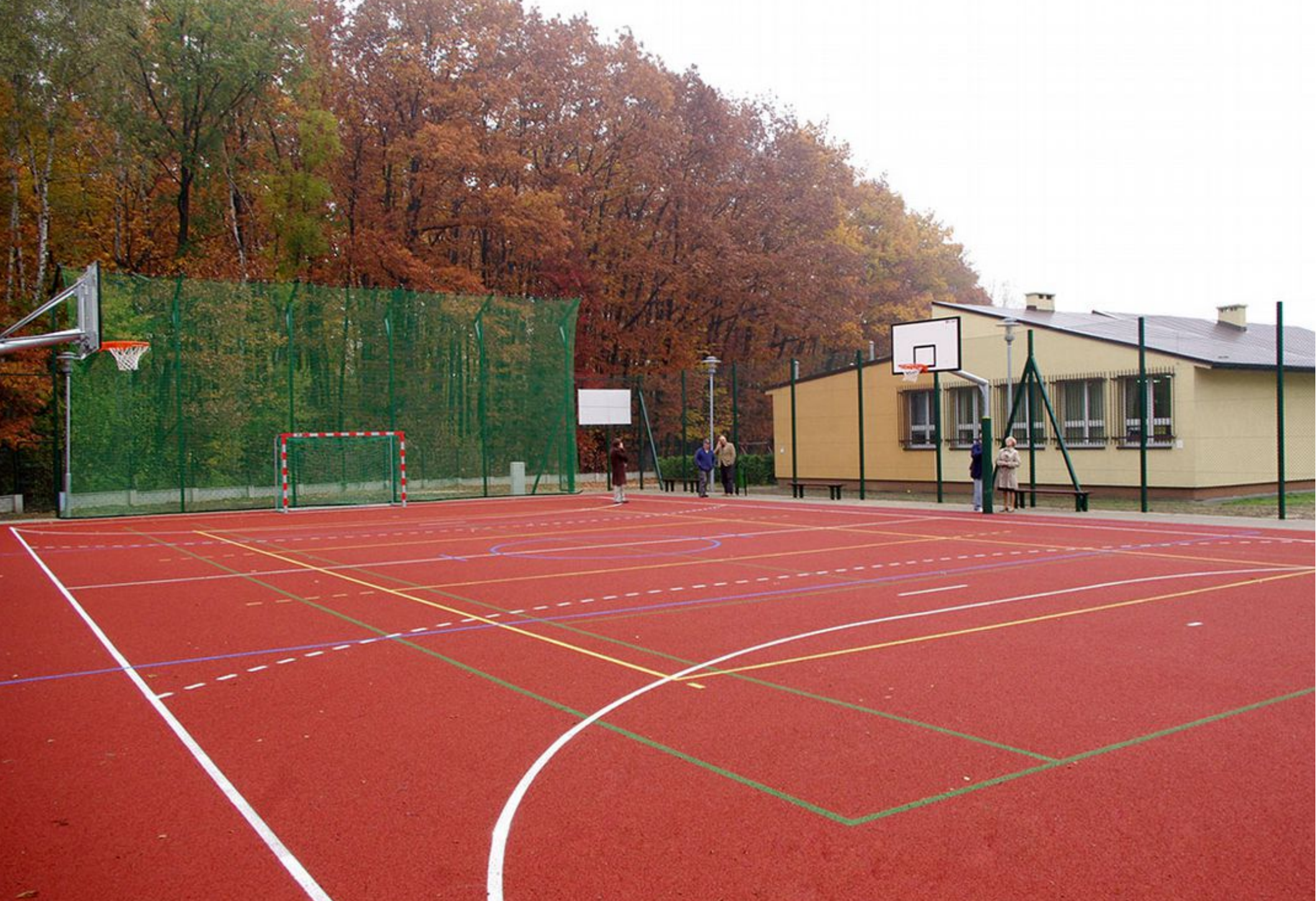
Gotowe boisko wielofunkcyjne w Gródkowie.
