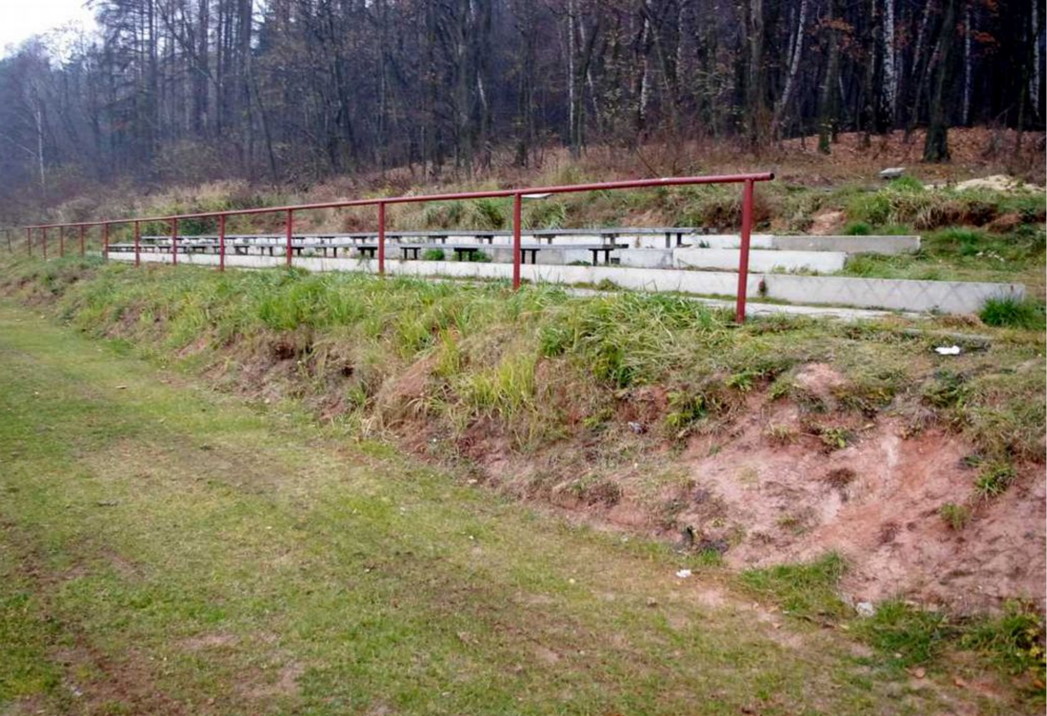
Stan przed przystąpieniem do prac budowlanych.
