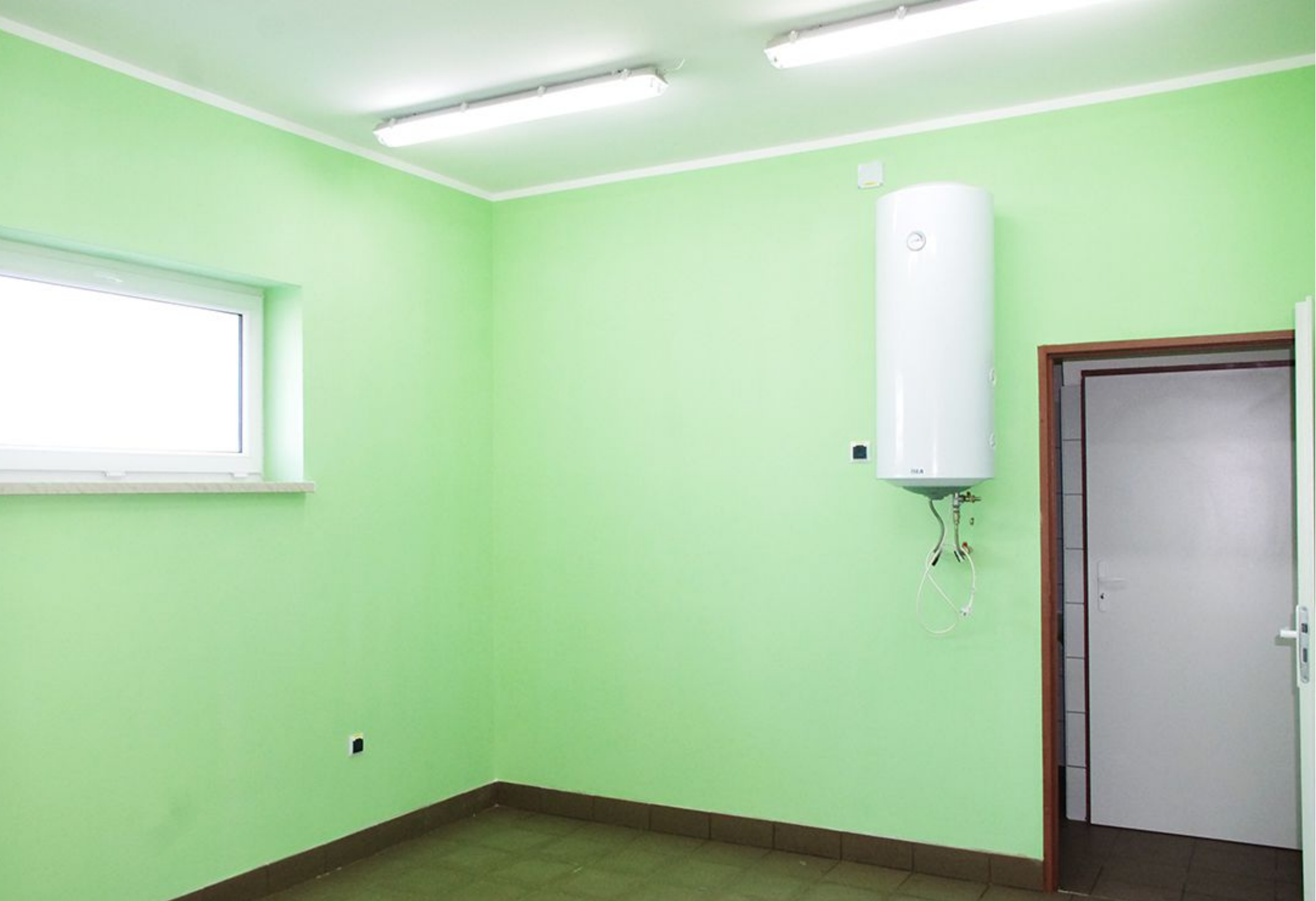
Wykończone wnętrze szatni piłkarskiej.
