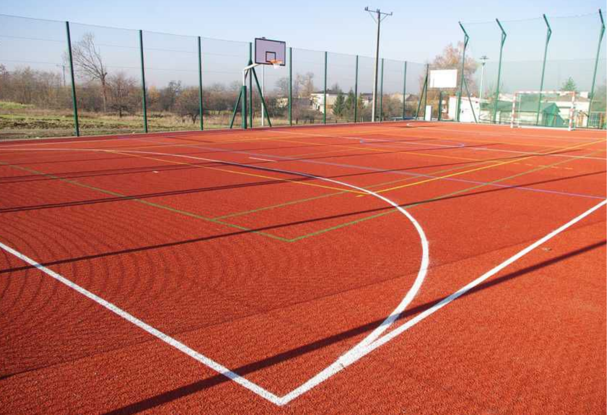
Gotowe boisko wielofunkcyjne w Goląszy Górnej.
