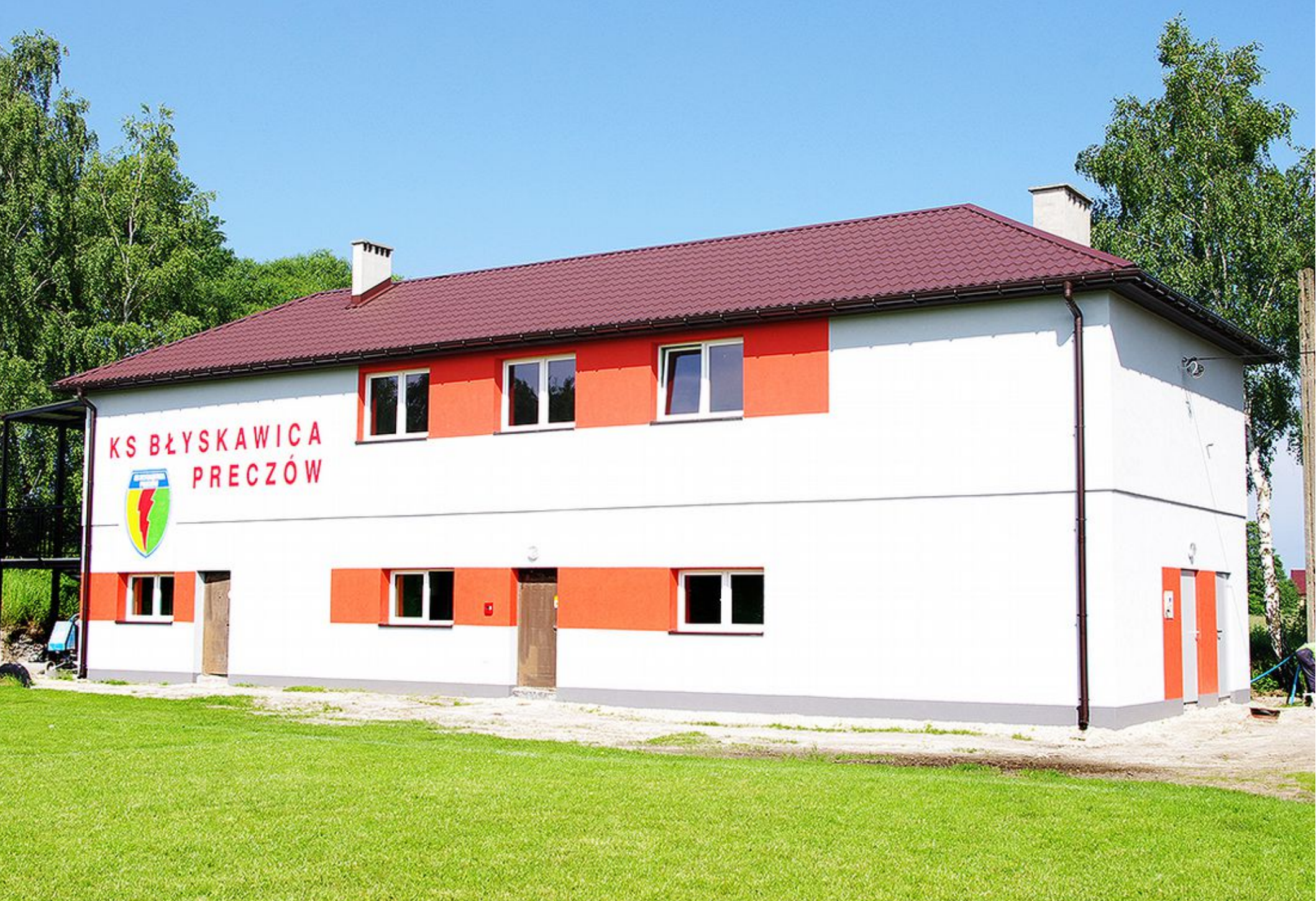
Budynek w Preczowie po zakończeniu prac.
