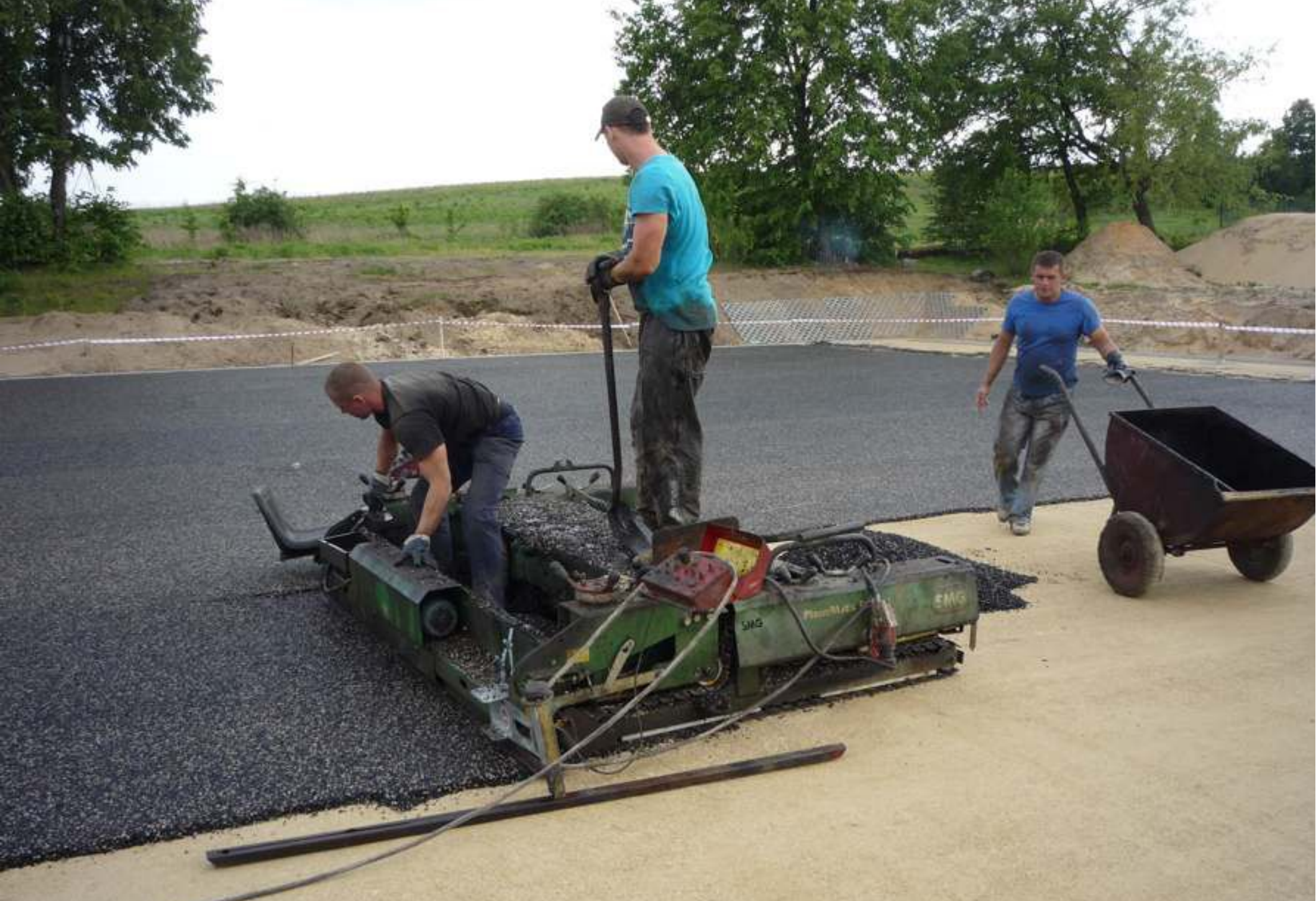
Prace przy budowie boiska wielofunkcyjnego w Malinowicach.
