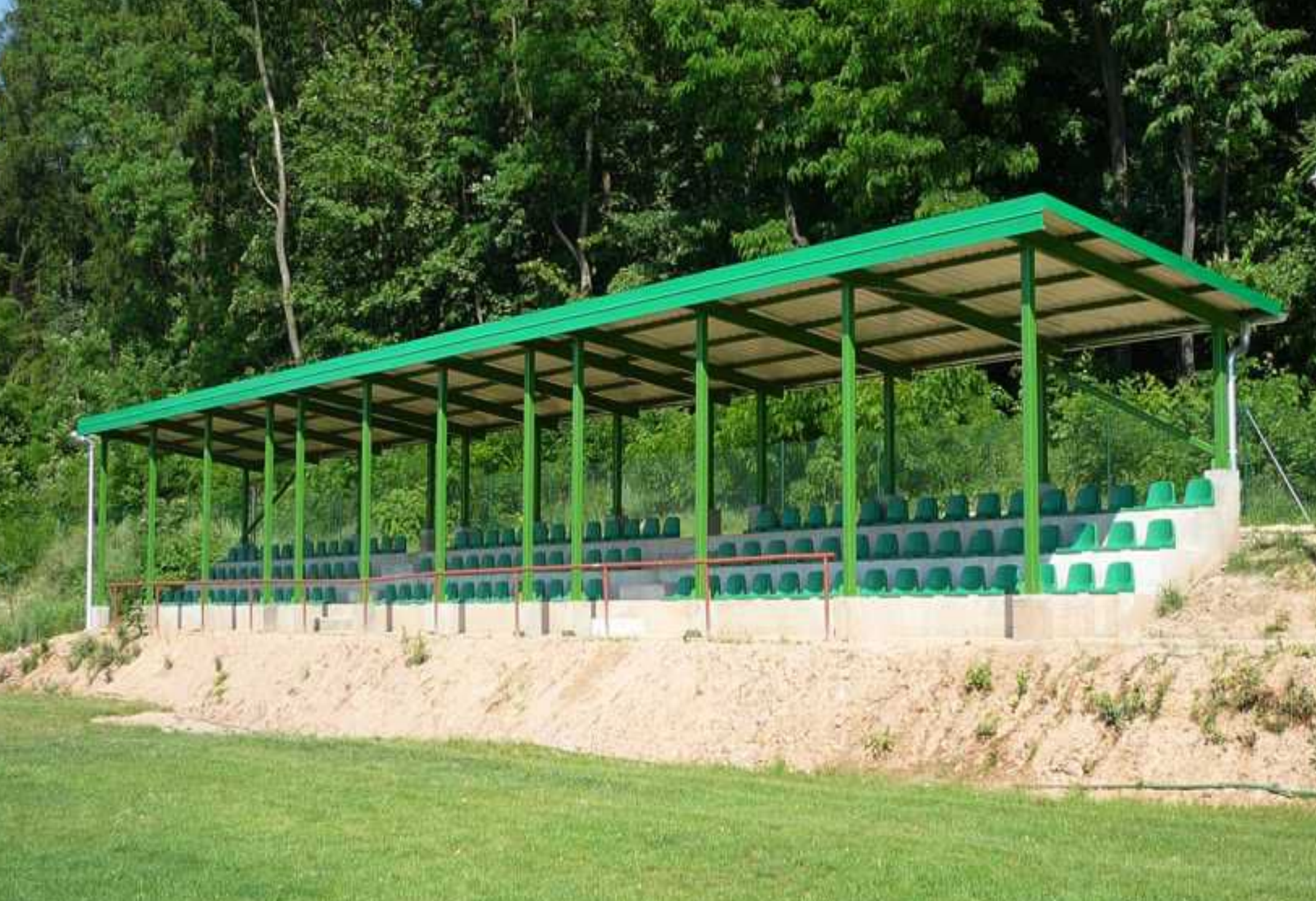
Wykonana zadaszona trybuna w Brzękowicach Dolnych.
