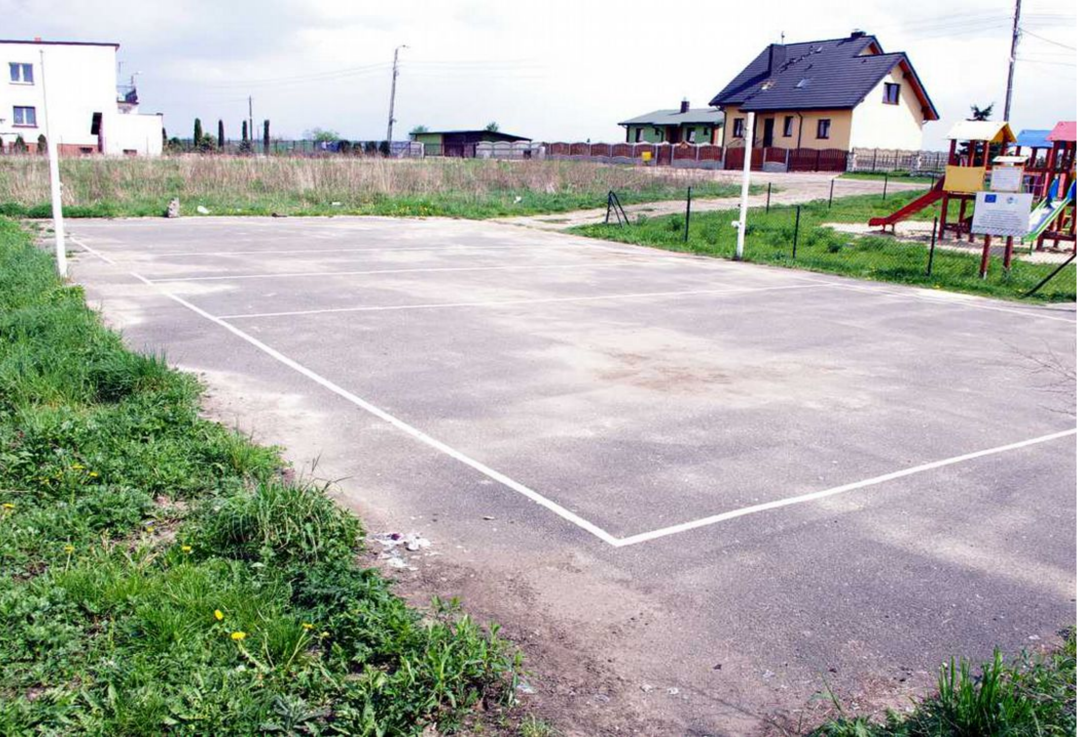
Przed budową obiektów sportowych w Górze Siewierskiej.
