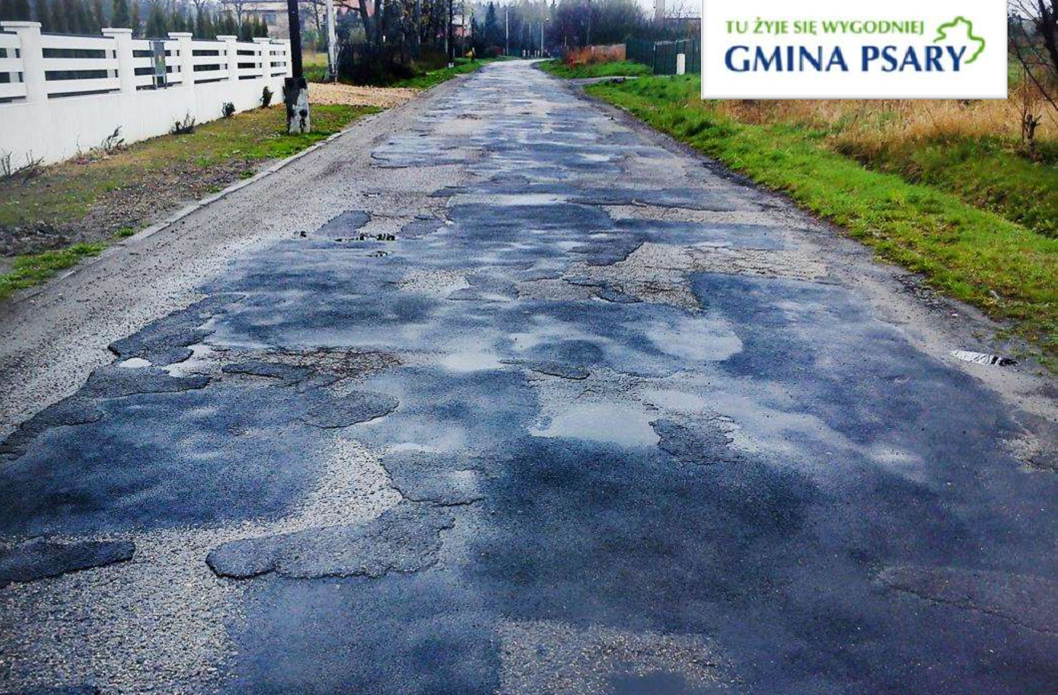
Ulica Szkolna w Preczowie przed przebudową
