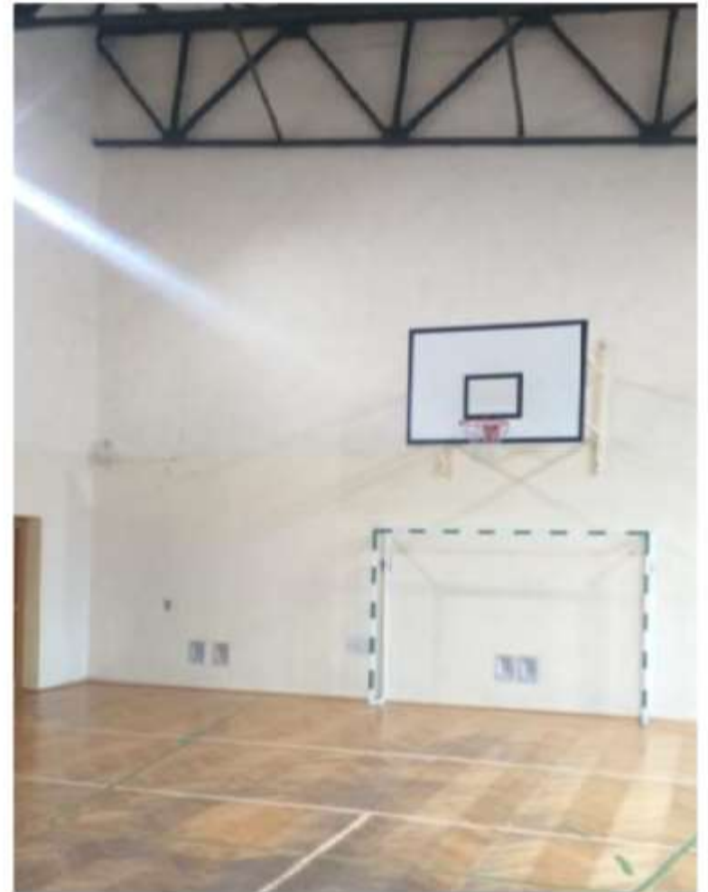
Sala gimnastyczna w Psarach przed remontem
