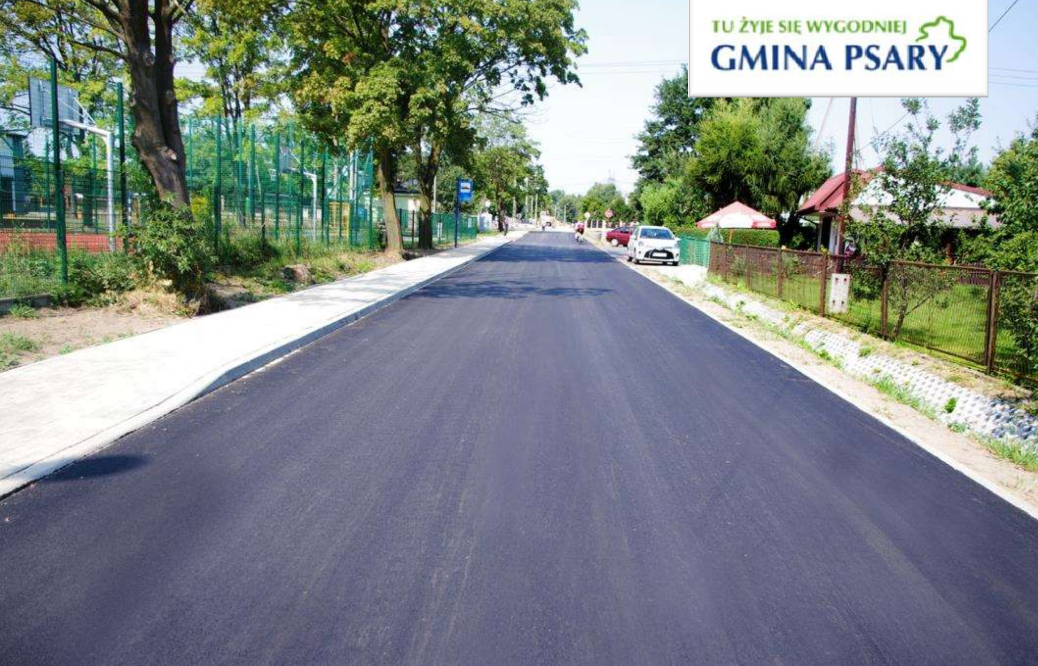
Ulica Szkolna w Preczowie po remoncie Koszt budowy: ponad 2 mln zł brutto
