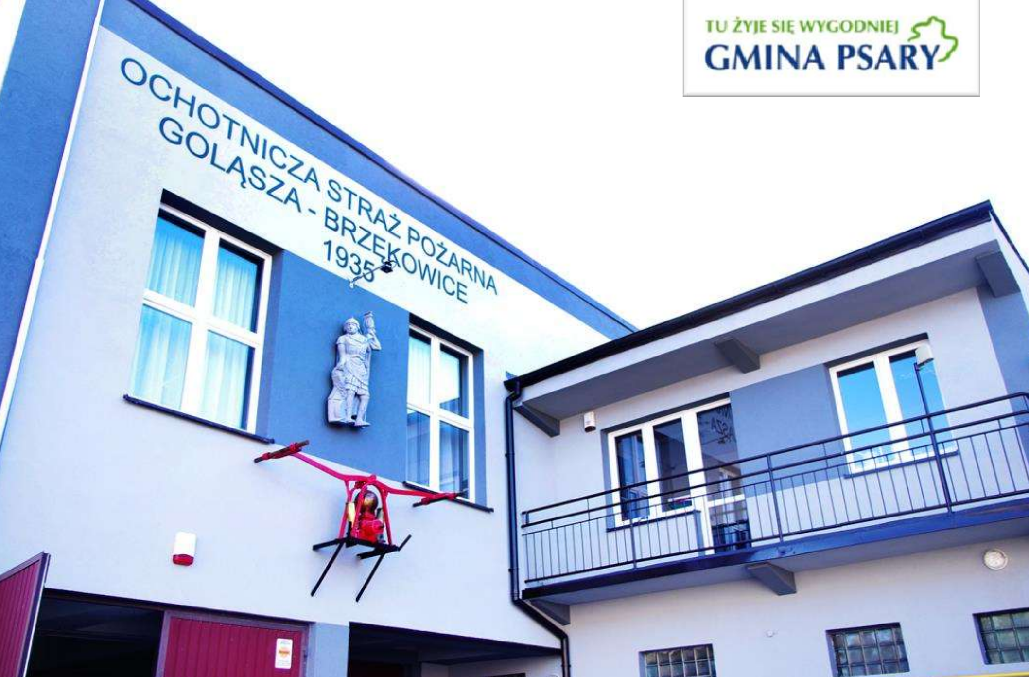
Nowa elewacja budynku OSP Goląsza - Brzekowice
