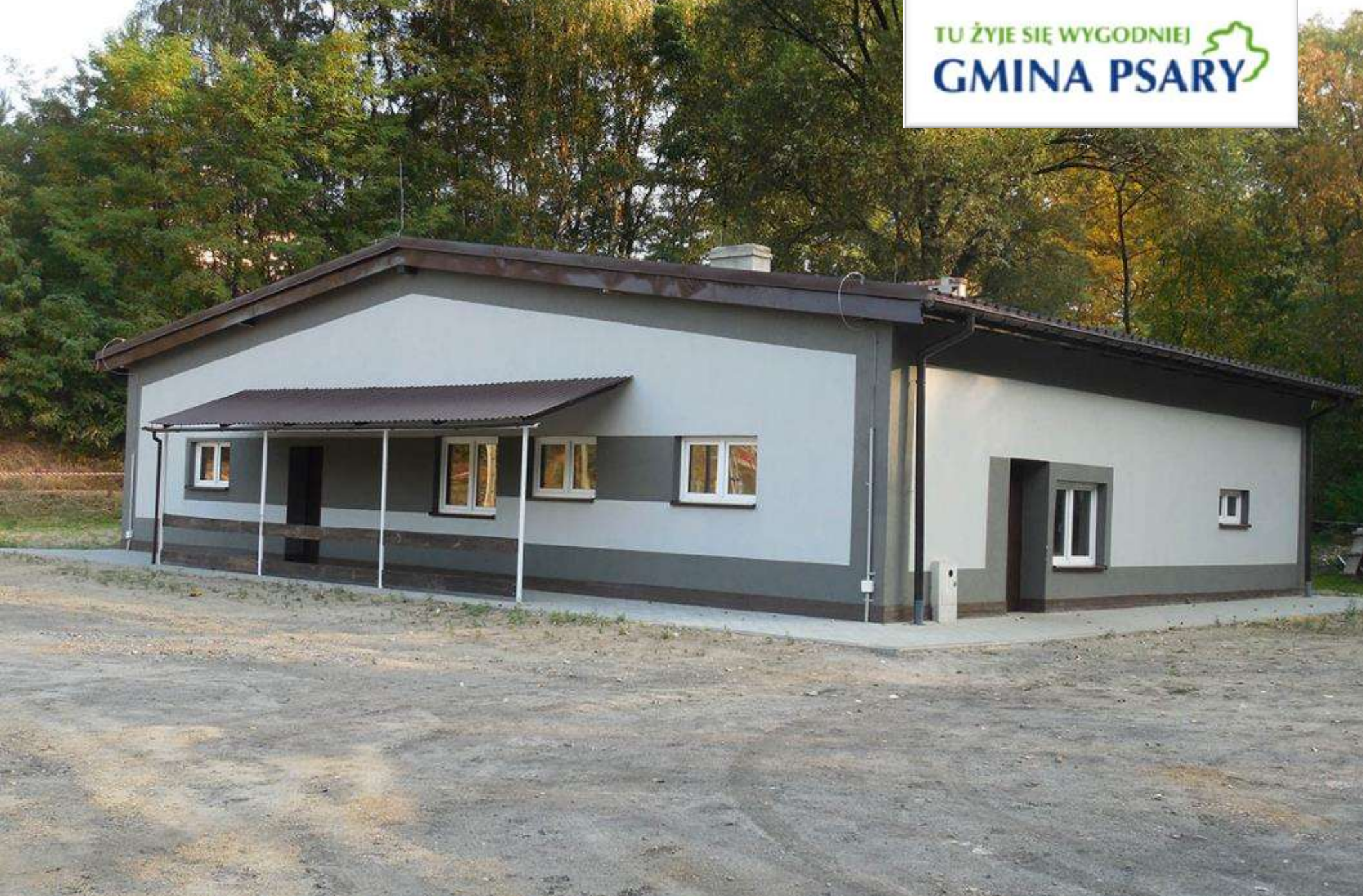
Szatnia piłkarska w Górze Siewierskiej po remoncie
