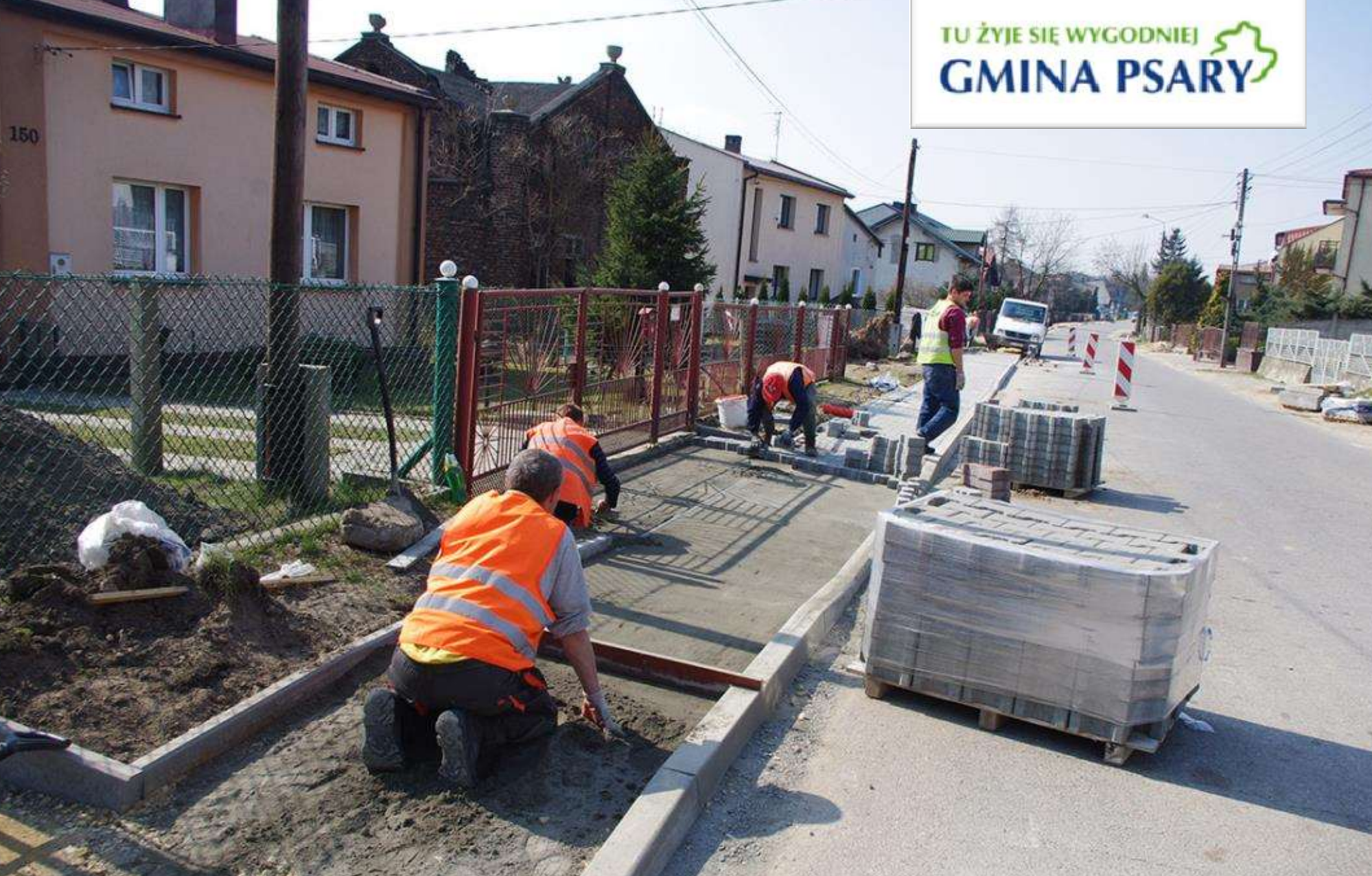
Prace przy odbudowie chodnika na ul. Wiejskiej w Psarach po wybudowaniu nowego wodociągu
