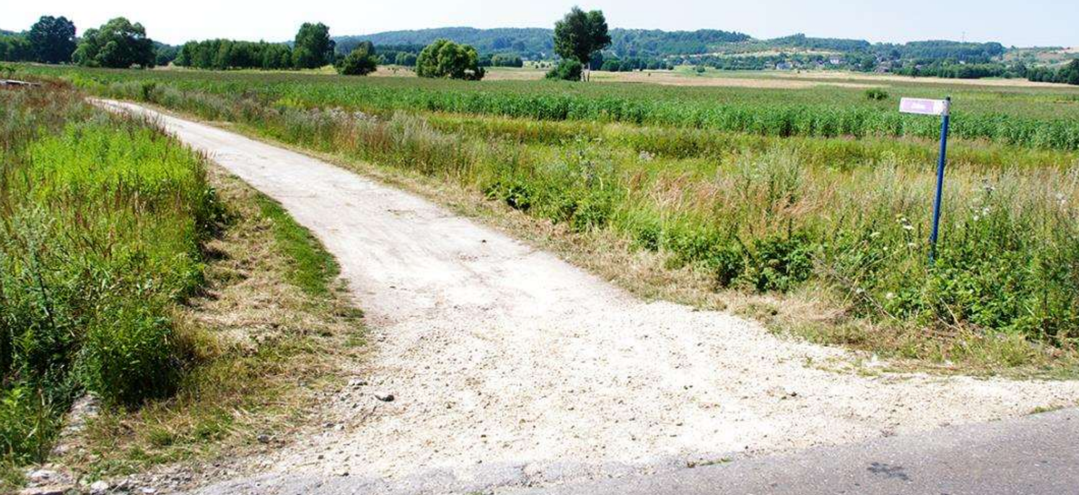
Ulica Zielona w Malinowicach przed remontem
