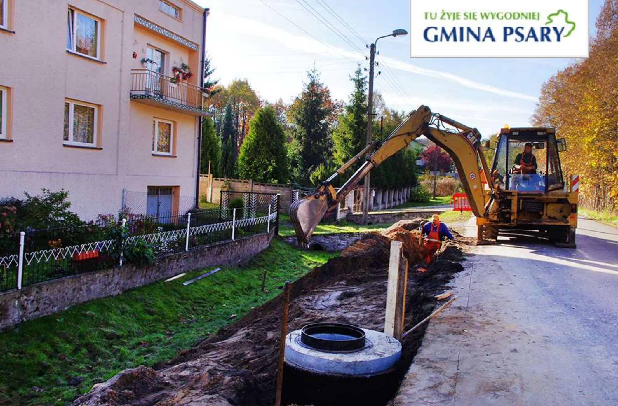
Prace budowlane na ul. Kościuszki w Górze Siewierskiej
