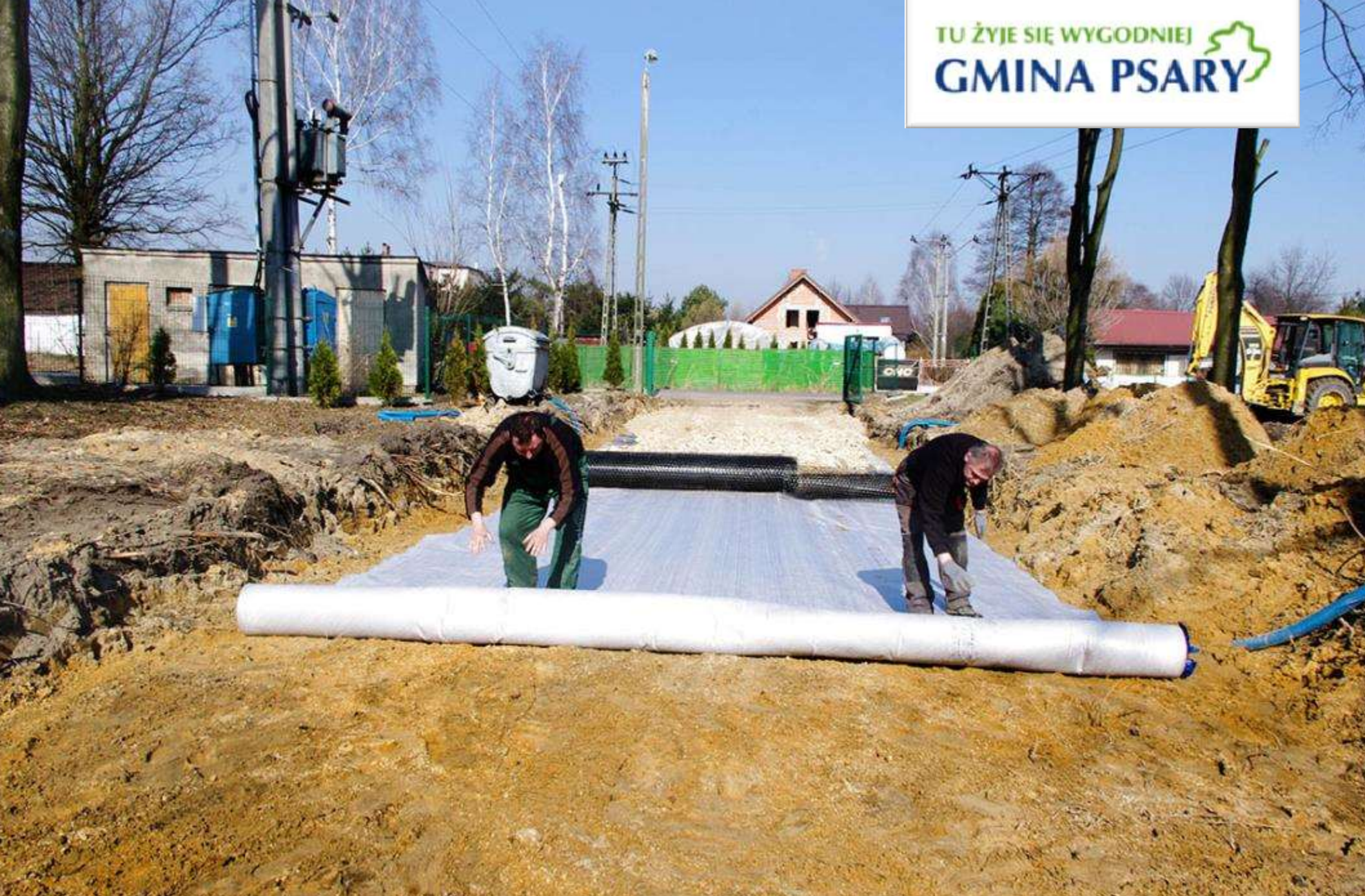
Prace nad budową kompleksu sportowo-rekreacyjnego w Preczowie
