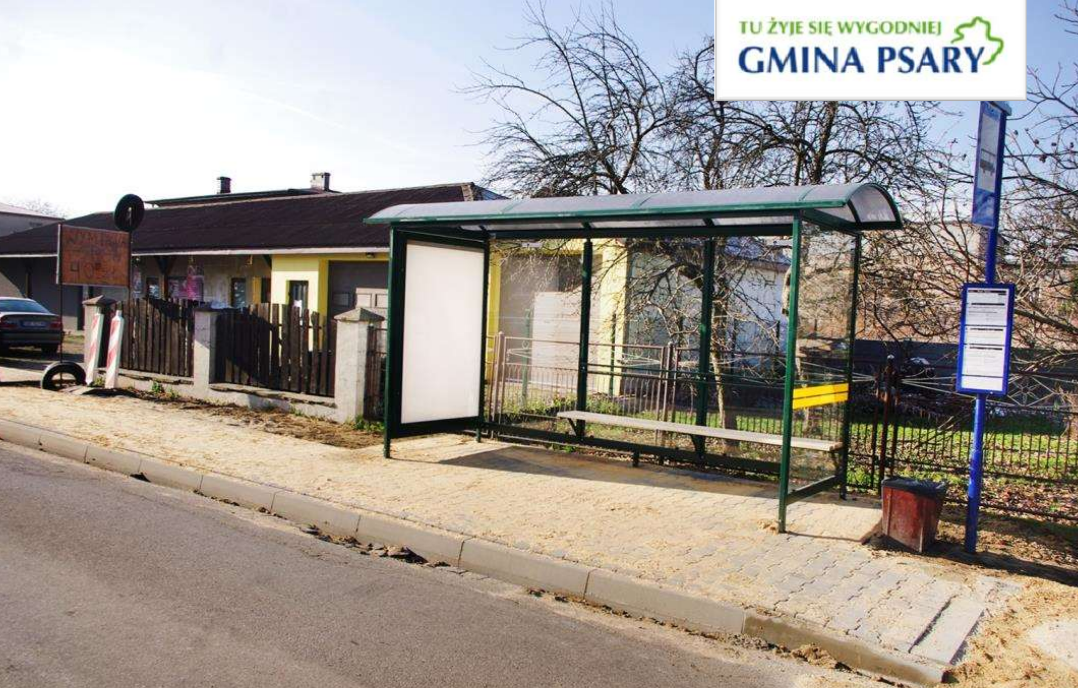
Nowy chodnik z wiatą przystankową przy ul. Malinowskiej w Psarach
