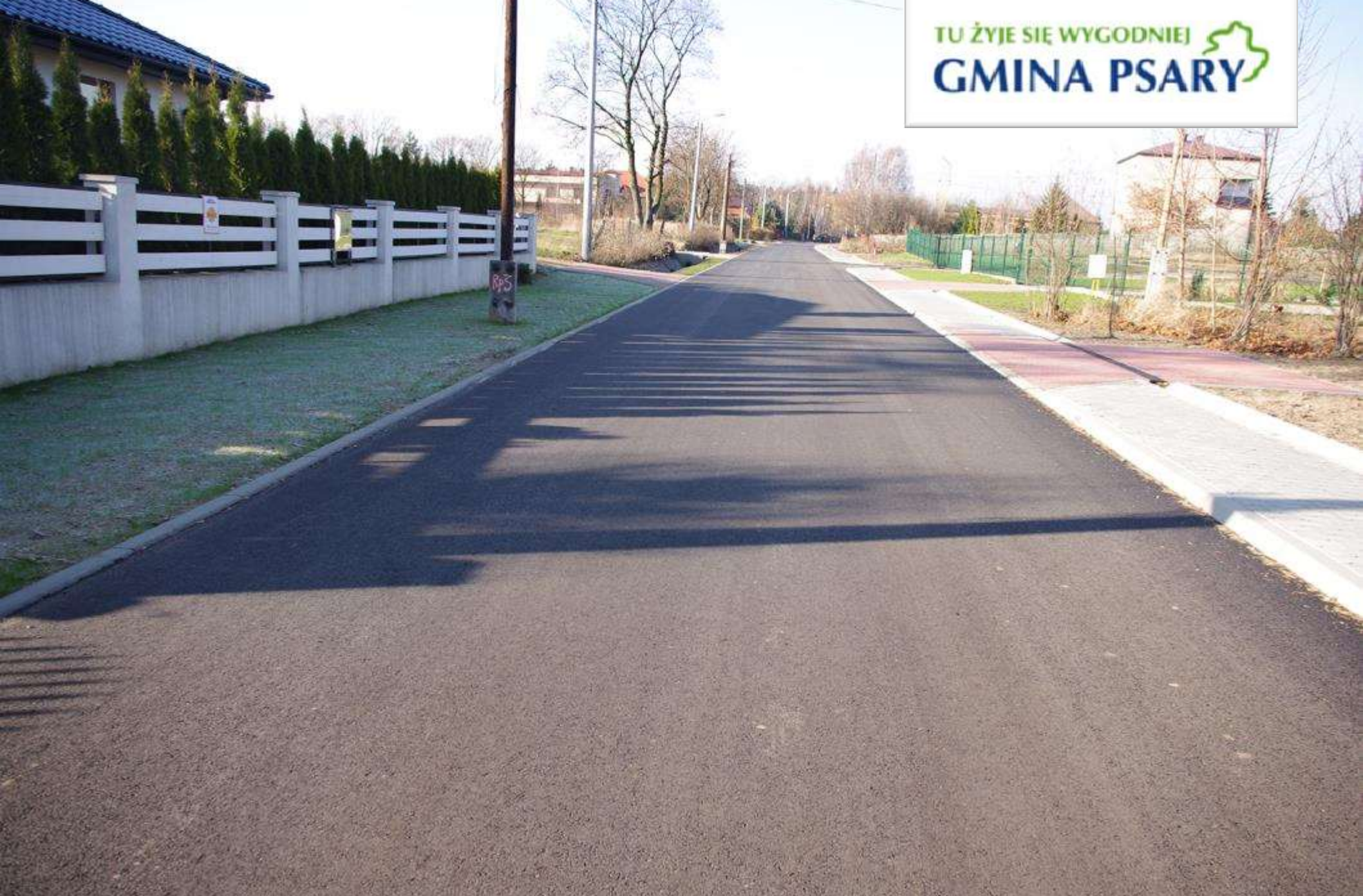
Ulica Szkolna w Preczowie po zakończeniu prac
