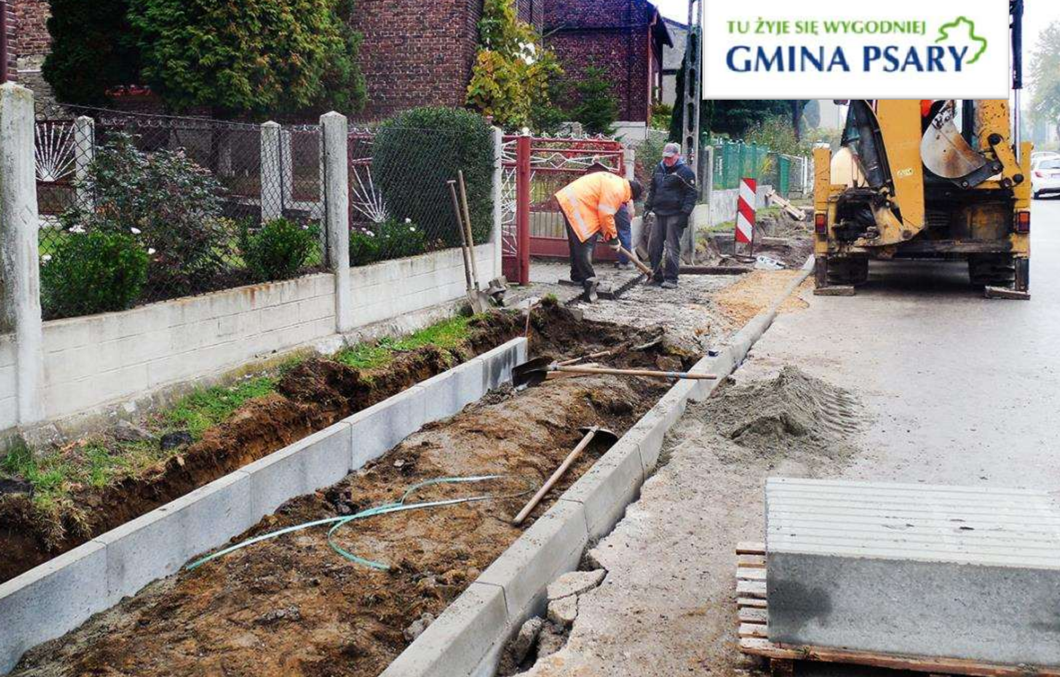
Budowa nowego odcinka chodnika przy ulicy Belnej w Strzyżowicach
