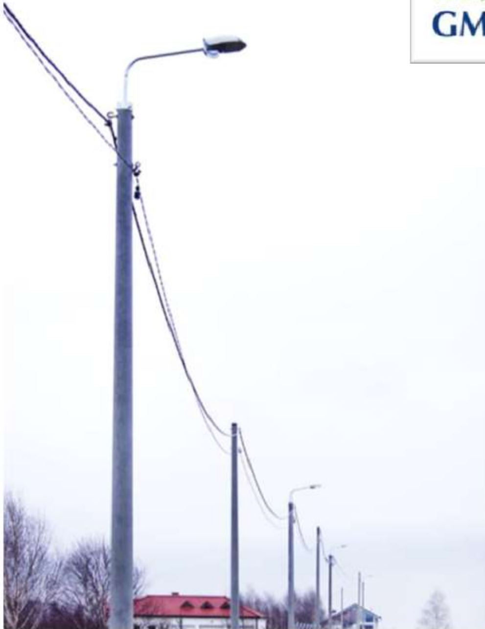
Nowe oświetlenie uliczne na ul. Bukowej w Malinowicach
