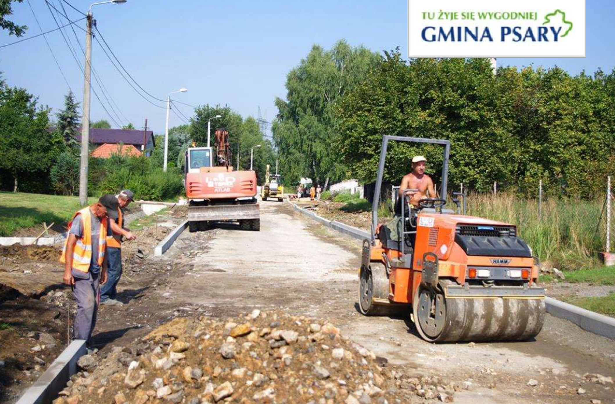
Ulica Szkolna w Preczowie w trakcie remontu
