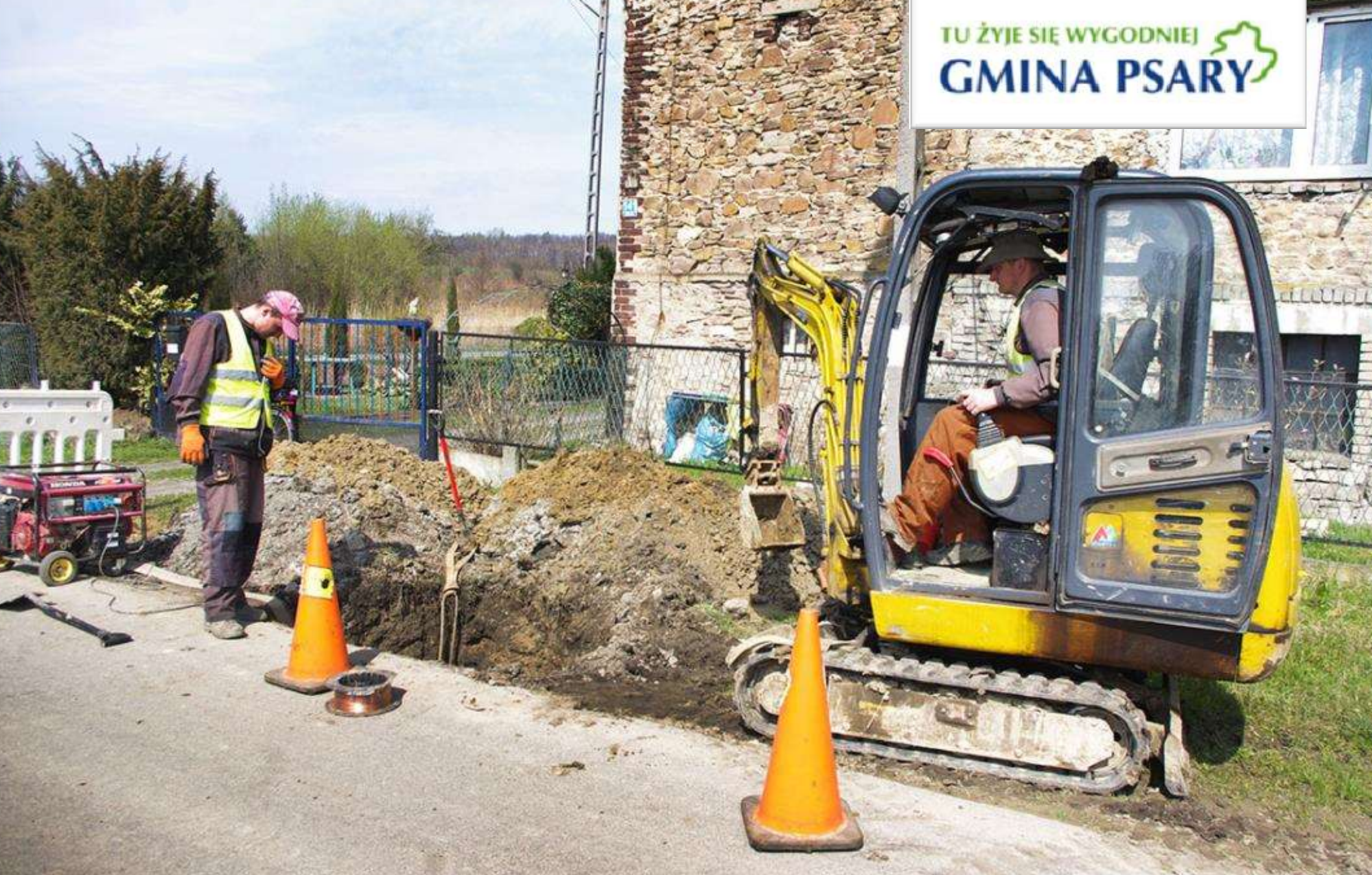
Prace przy wymianie wodociągu na ulicy Kasztanowej w Psarach
