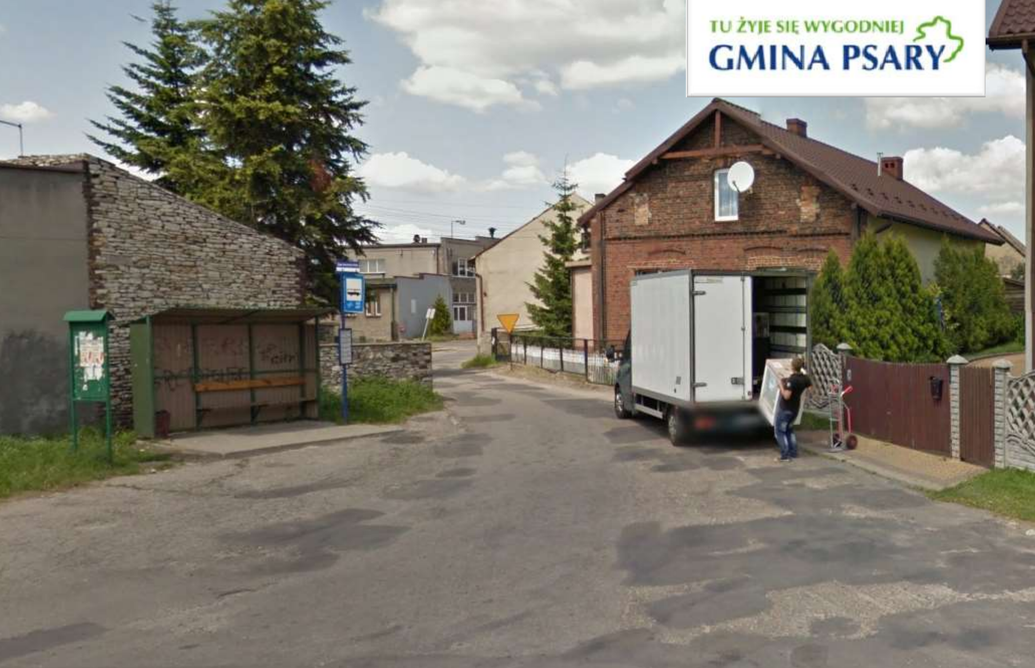
Łącznik pomiędzy ul. Kościuszki i Szopena w Górze Siewierskiej przed remontem
