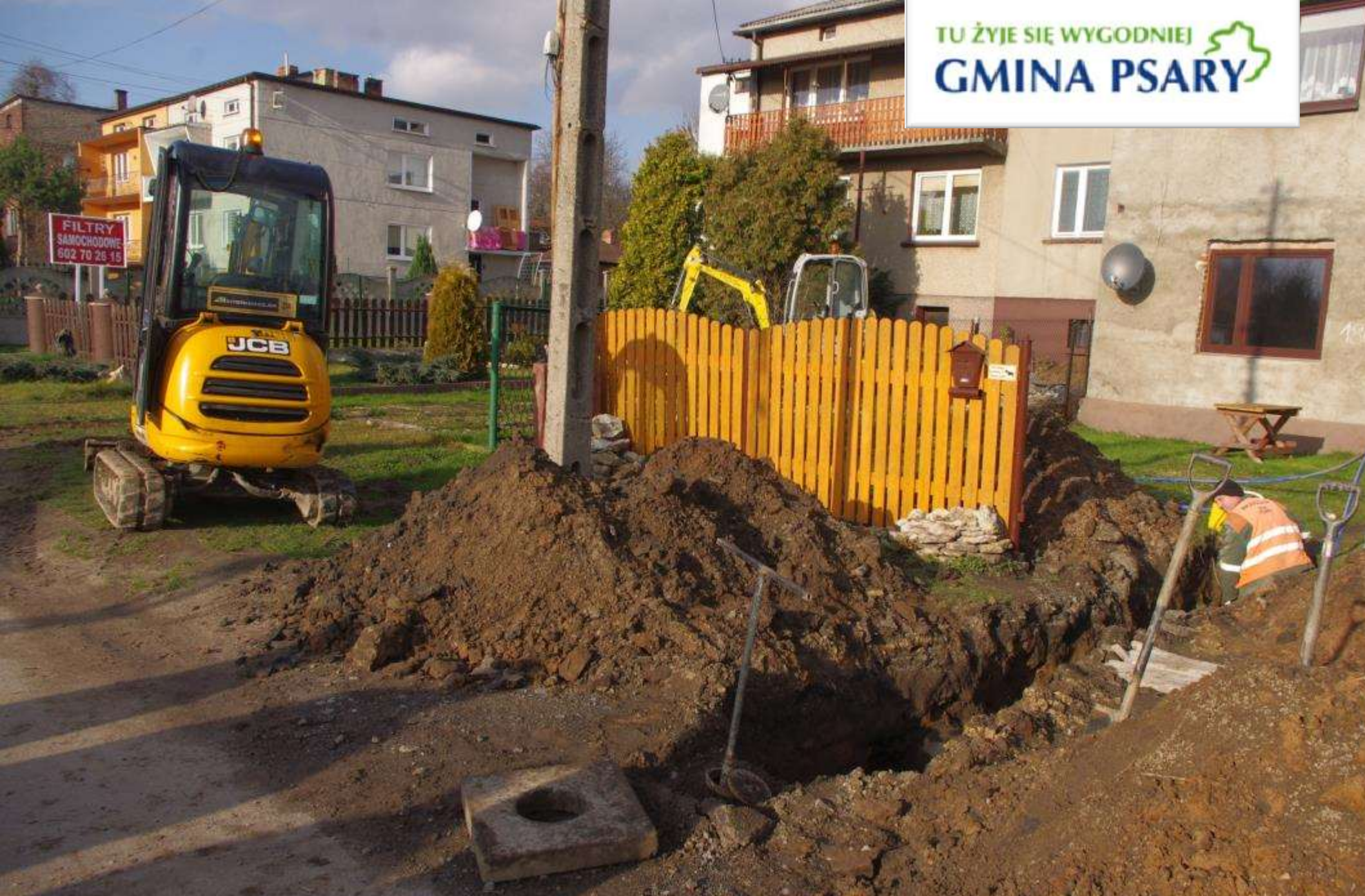
Przyłączanie budynku mieszkalnego do nowego wodociągu
