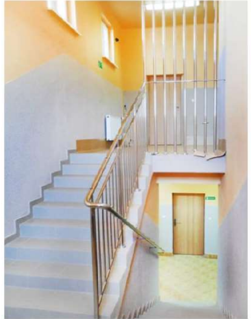
Klatka schodowa po remoncie
