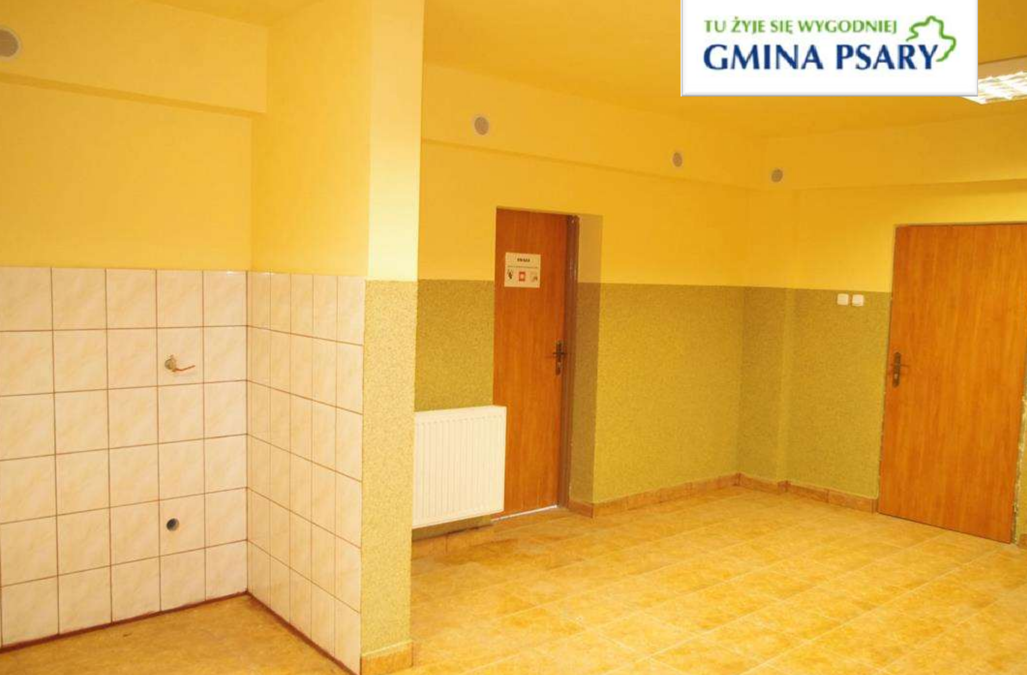
Jedno z wyremontowanych pomieszczeń w OSP Gołąsza Górna
