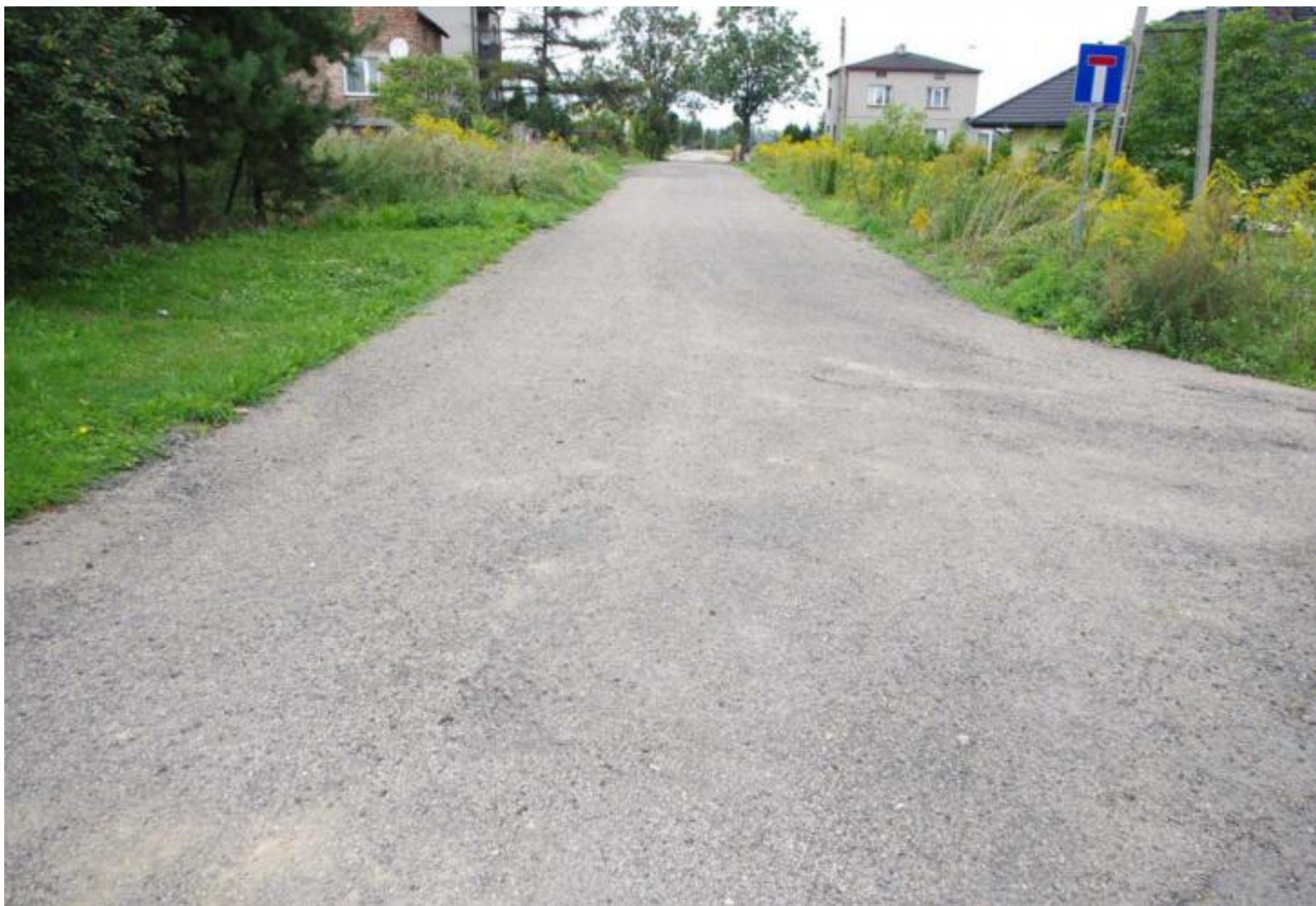
Ulica Jasna w Sarnowie po remoncie
