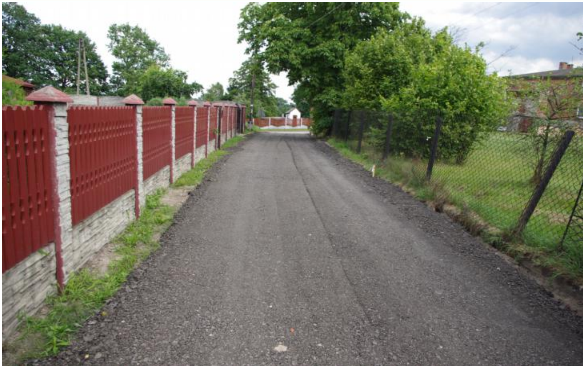
Ulica Brzeźna w Preczowie po remoncie
