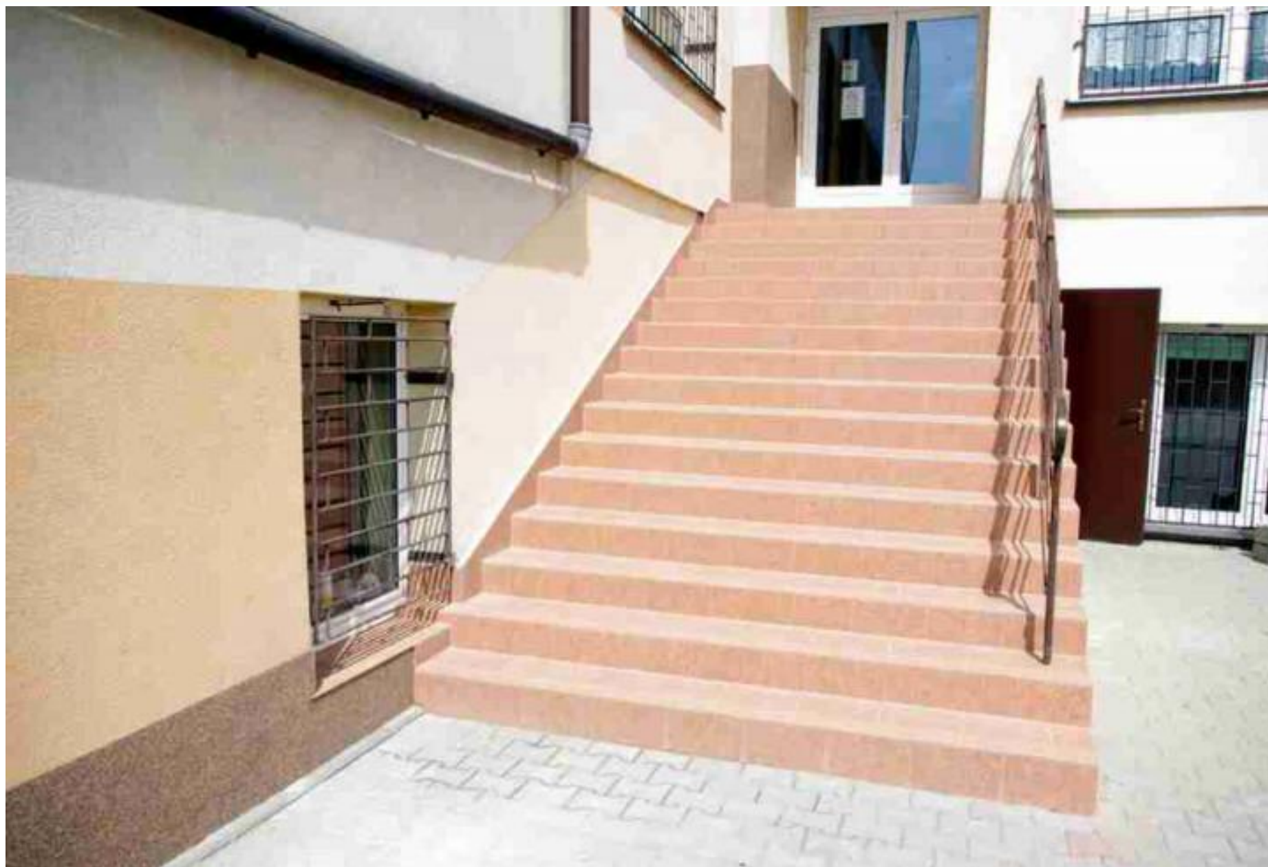
Budowa i wyłożenie płytek na schodach za szkołą w Strzyżowicach
