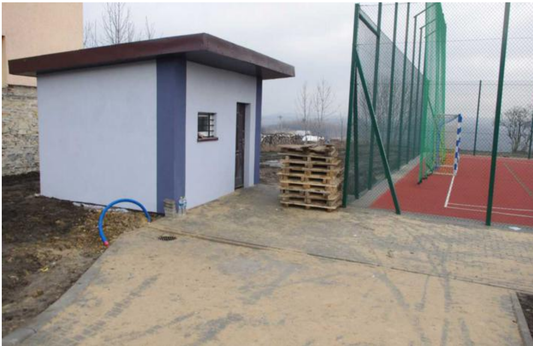
Budowa budynku na sprzęt sportowy przy boisku wielofunkcyjnym w Górze Siewierskiej.
