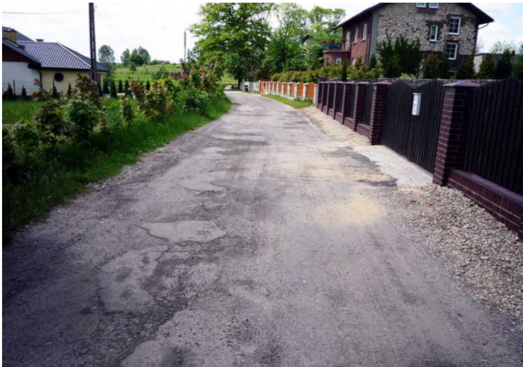
Ulica Podwale w Strzyżowicach przed remontem
