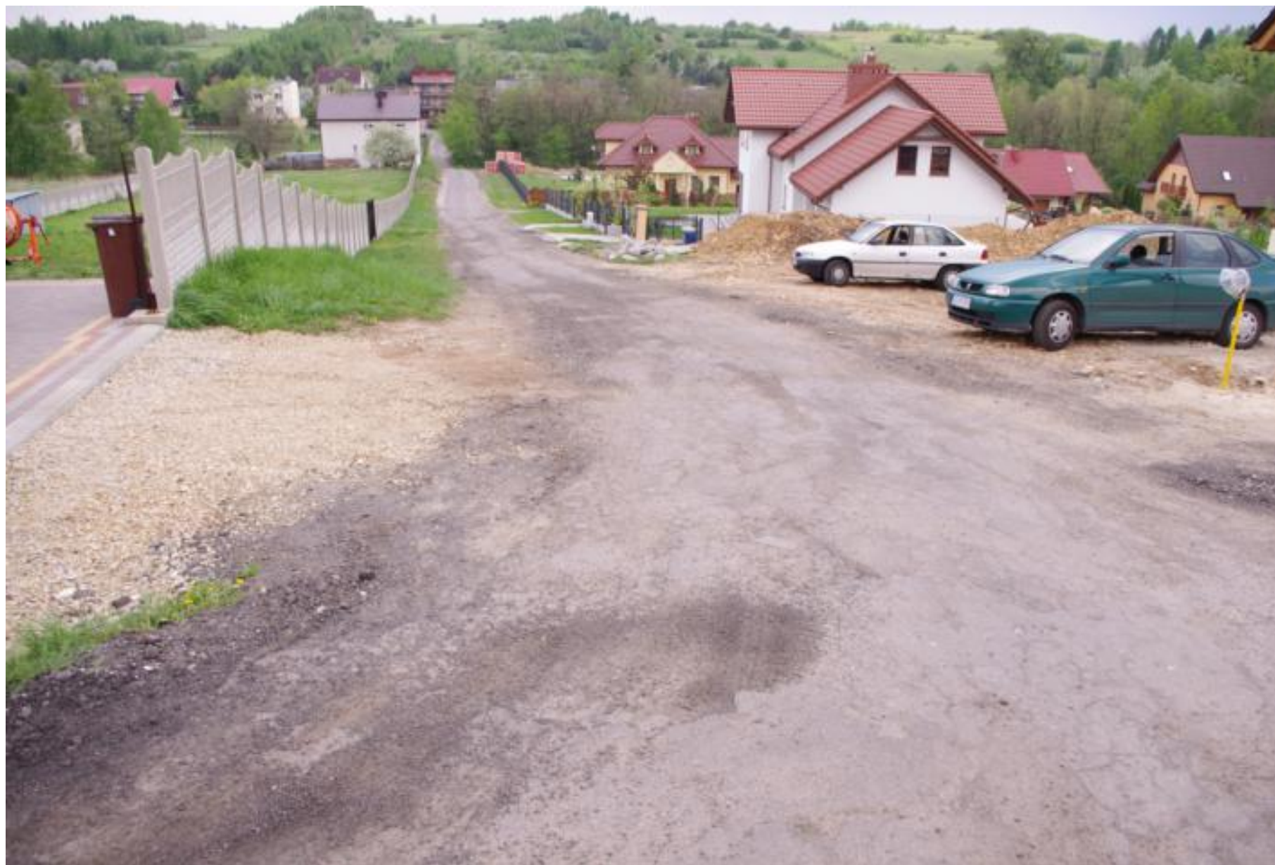
Ulica Górna w Górze Siewierskiej przed remontem
