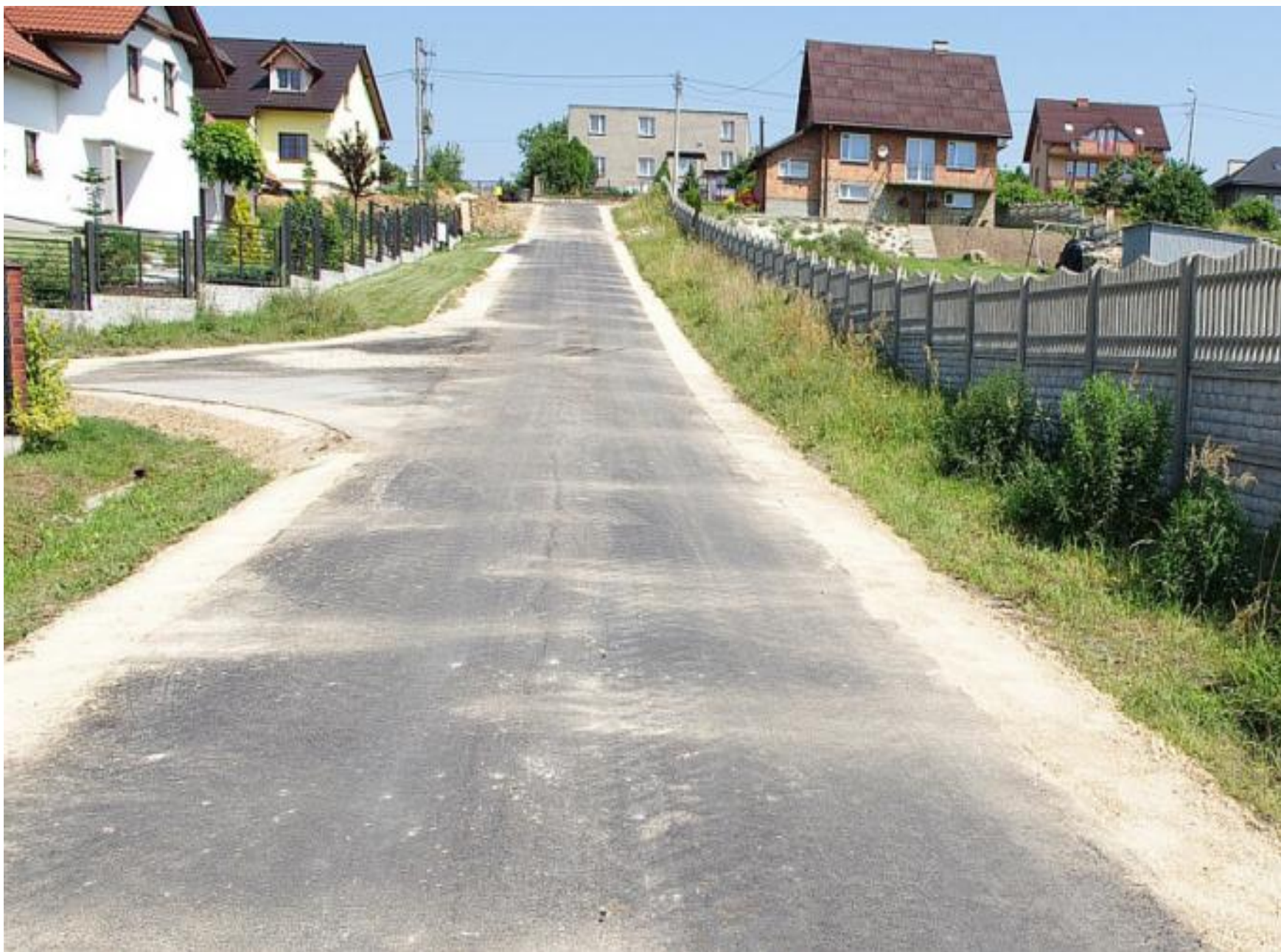
Ulica Górna w Górze Siewierskiej po remoncie
