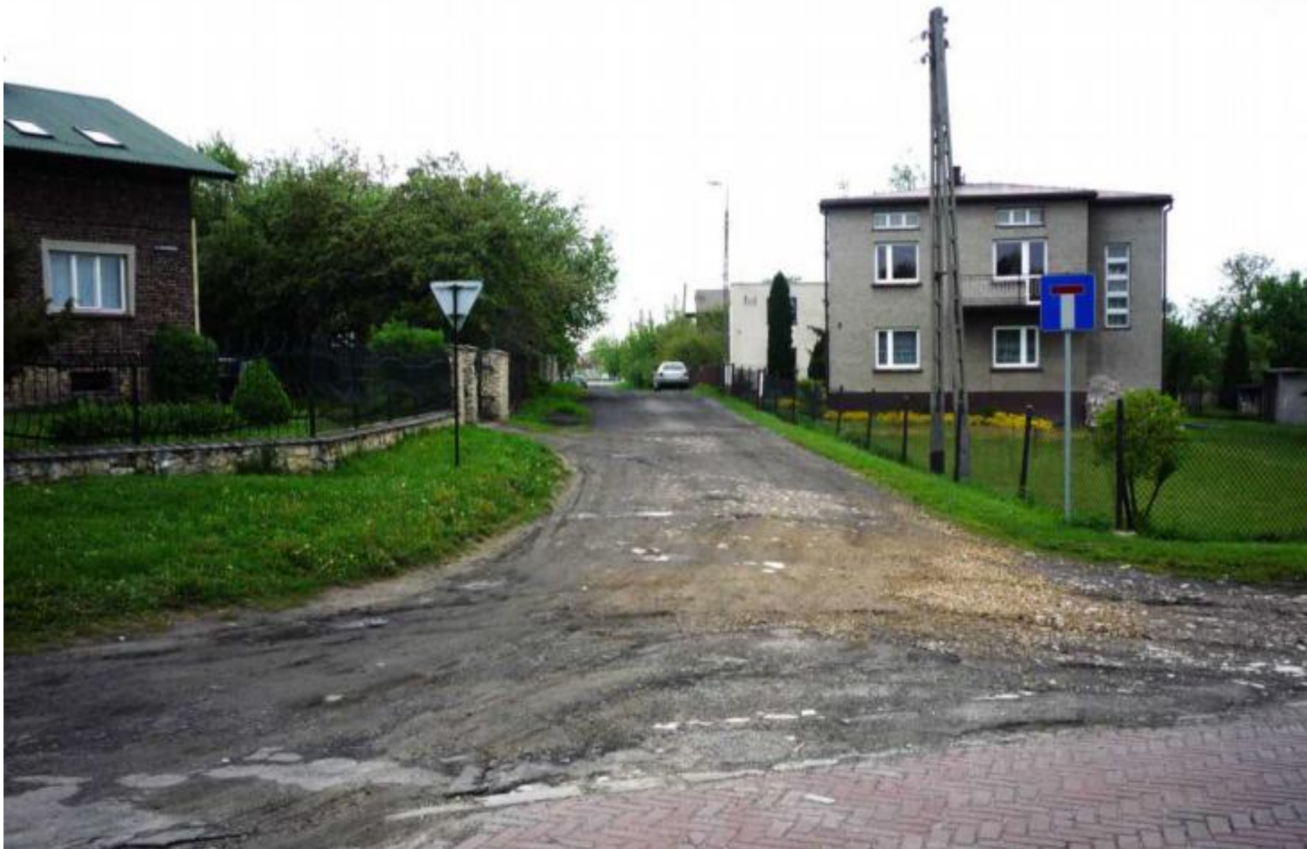
Ulica Źródlana w Sarnowie przed remontem
