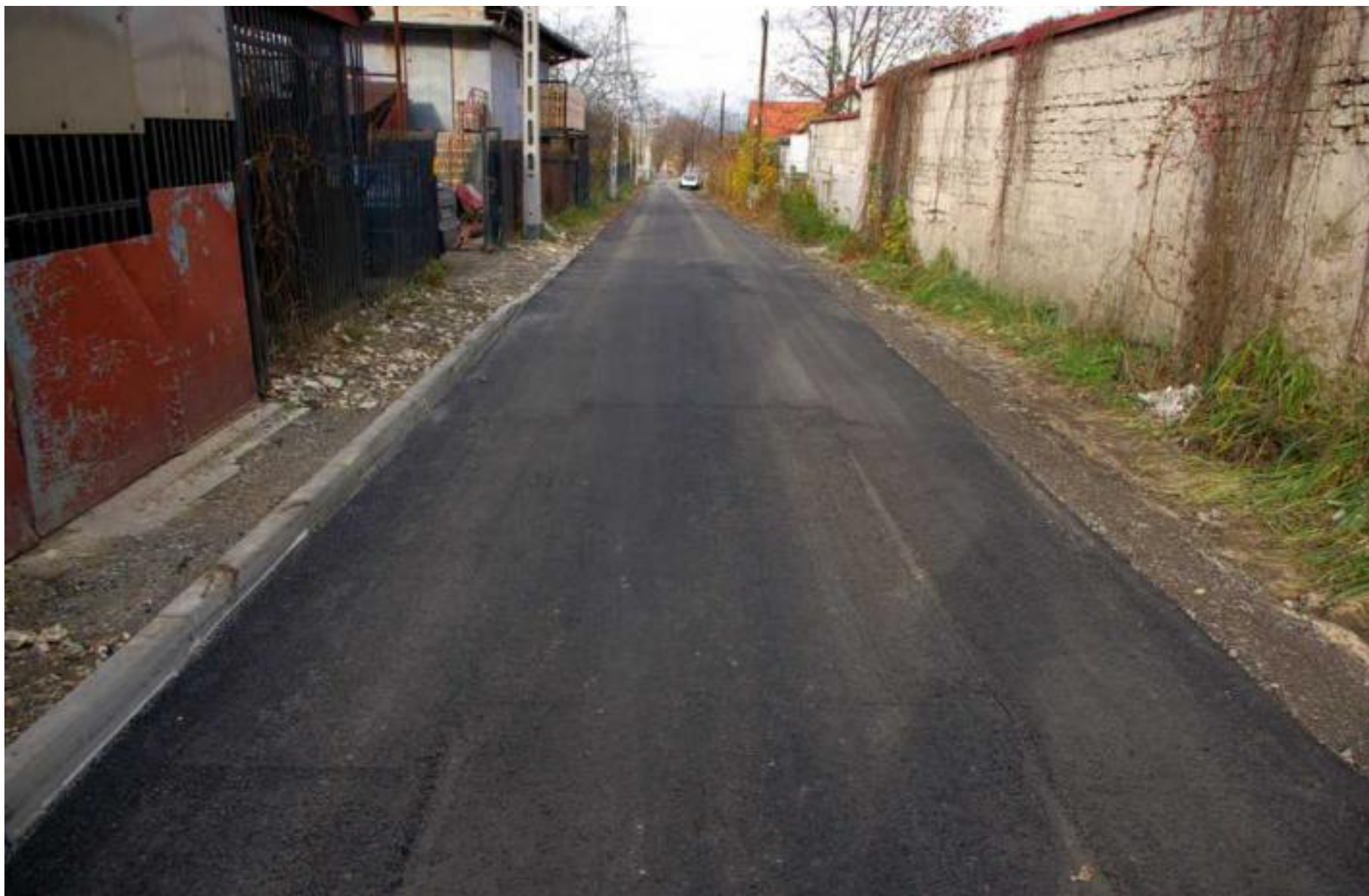
Ulica Spacerowa w Sarnowie po remoncie
