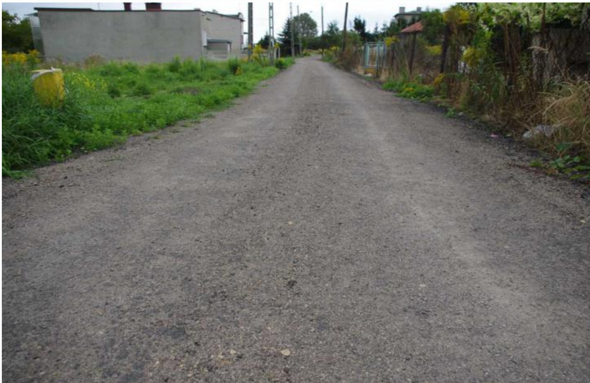
Ulica Polna w Psarach po remoncie
