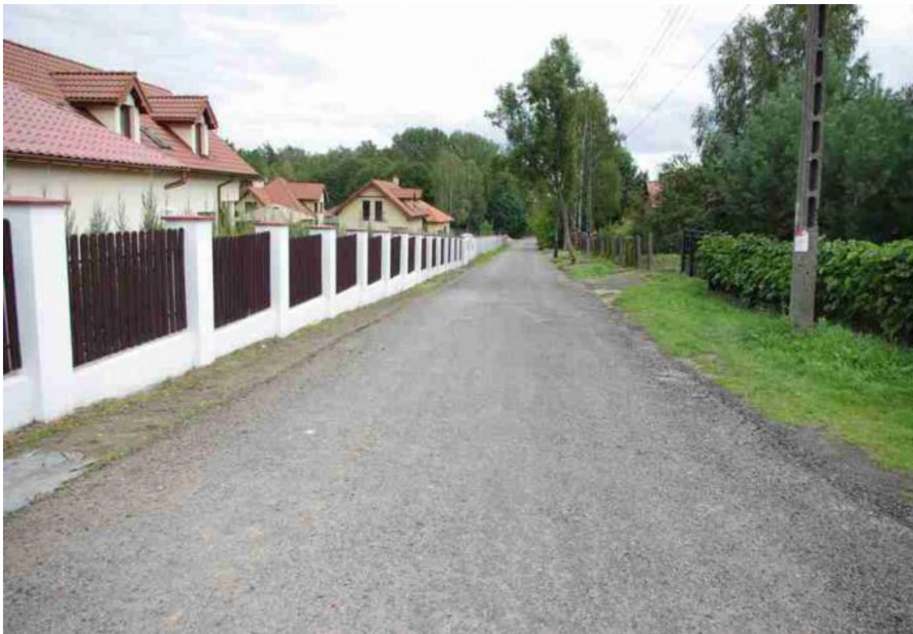
Ulica Wschodnia w Gródkowie po remoncie
