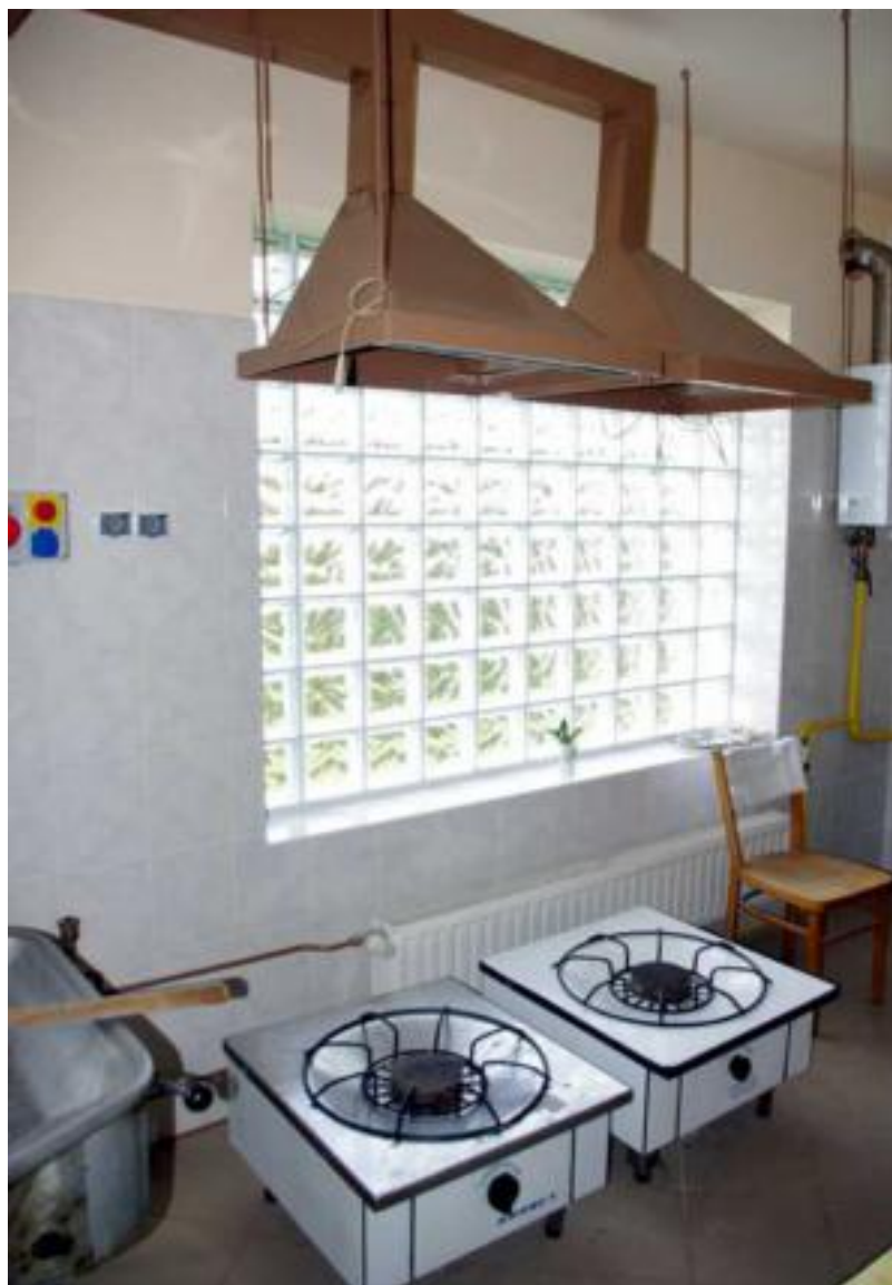
Remont kuchni i pomieszczeń w OSP w Goląszy Górnej
