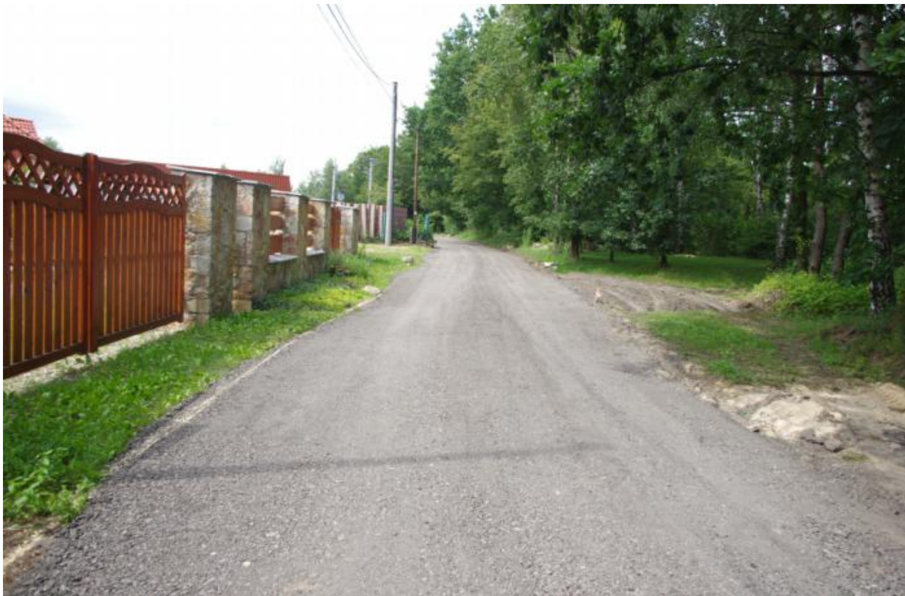
Ulica Jaworowa w Preczowie po remoncie
