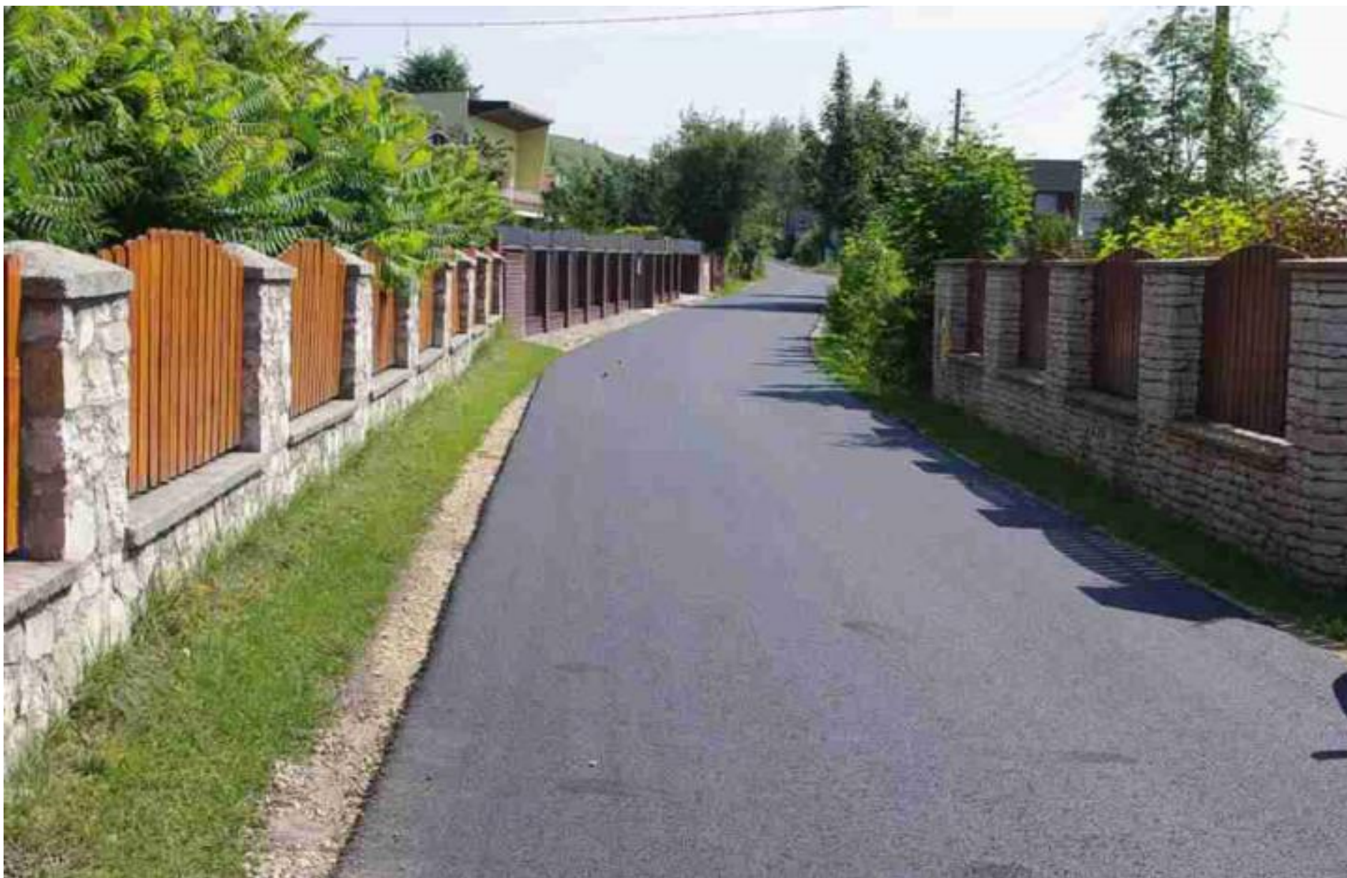
Ulica Podwale w Strzyżowicach po remoncie
