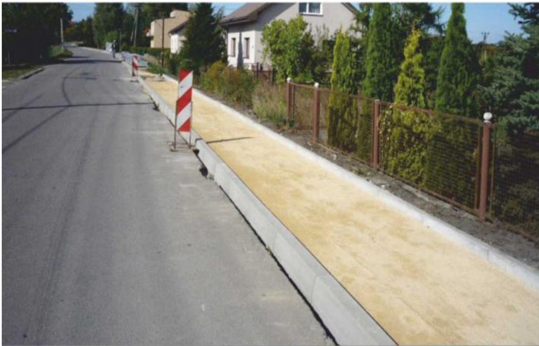
Budowa chodników na ulicy Wiejskiej w Sarnowie i 1 Maja w Strzyżowicach
