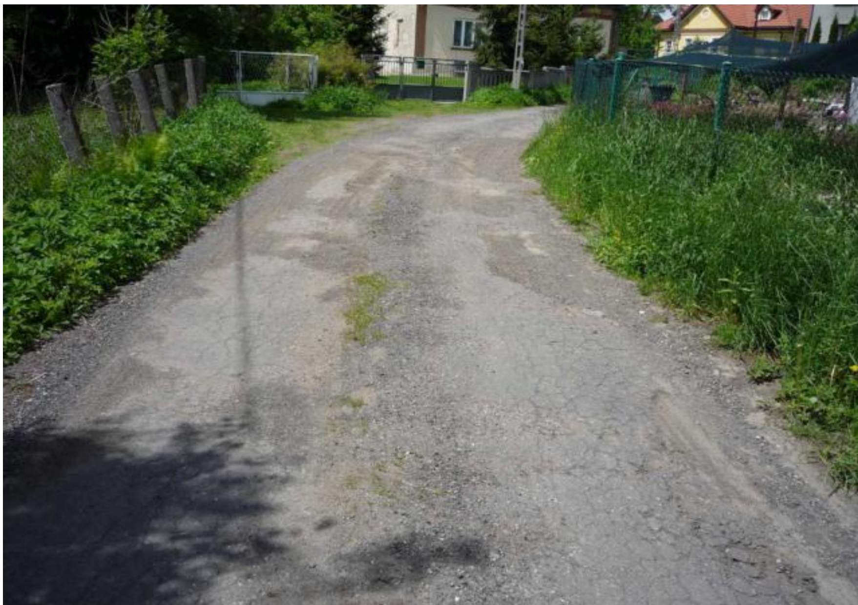
Ulica Ogrodowa w Strzyżowicach przed remontem
