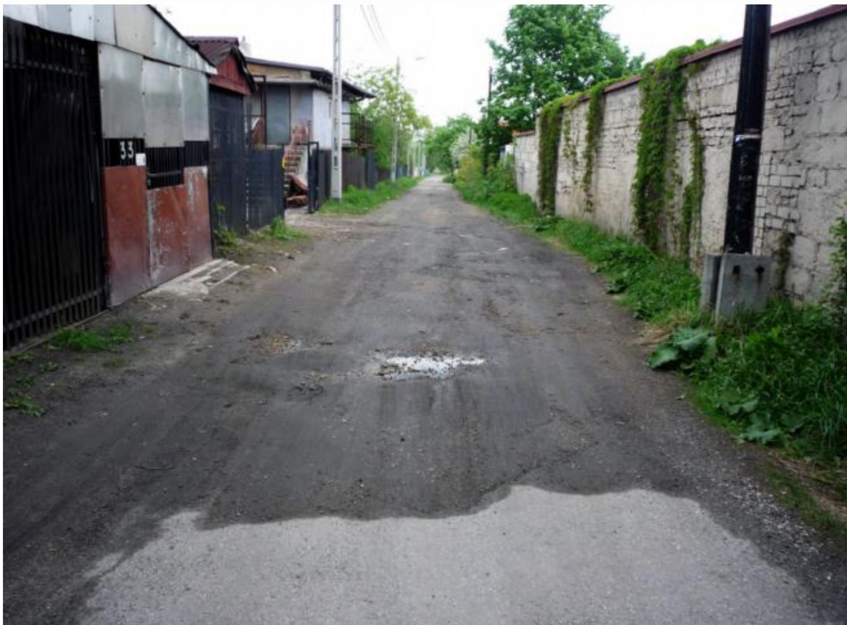
Ulica Spacerowa przed remontem
