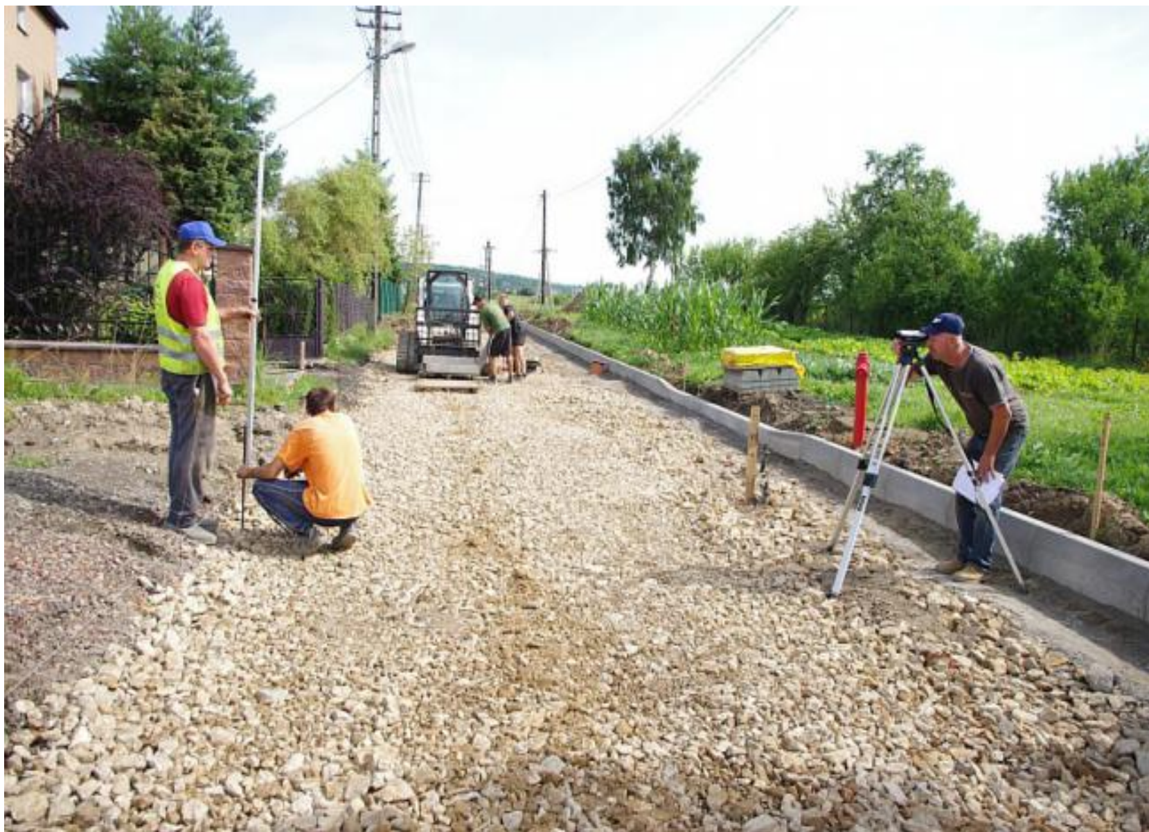
Budowa ul. Kasztanowej w Psarach – 224 tys. zł.
