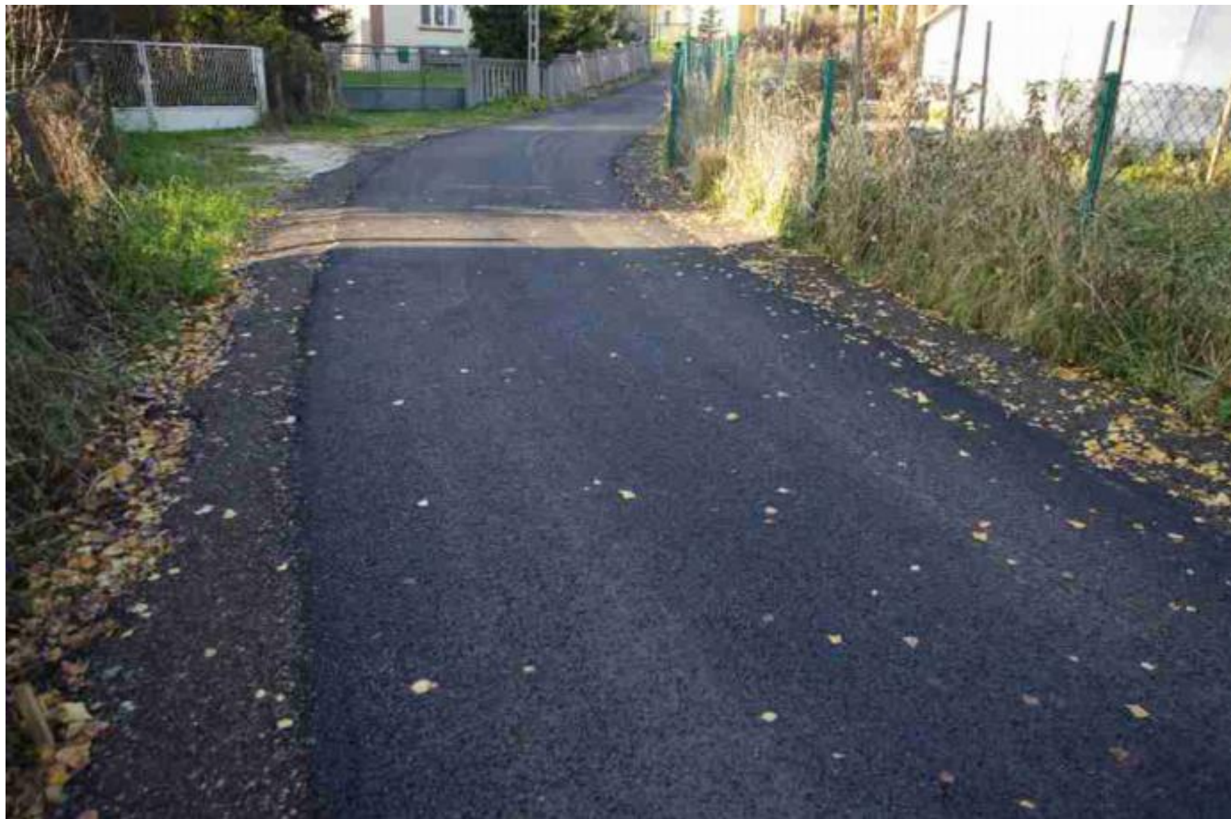
Ulica Ogrodowa w Strzyżowicach po remoncie
