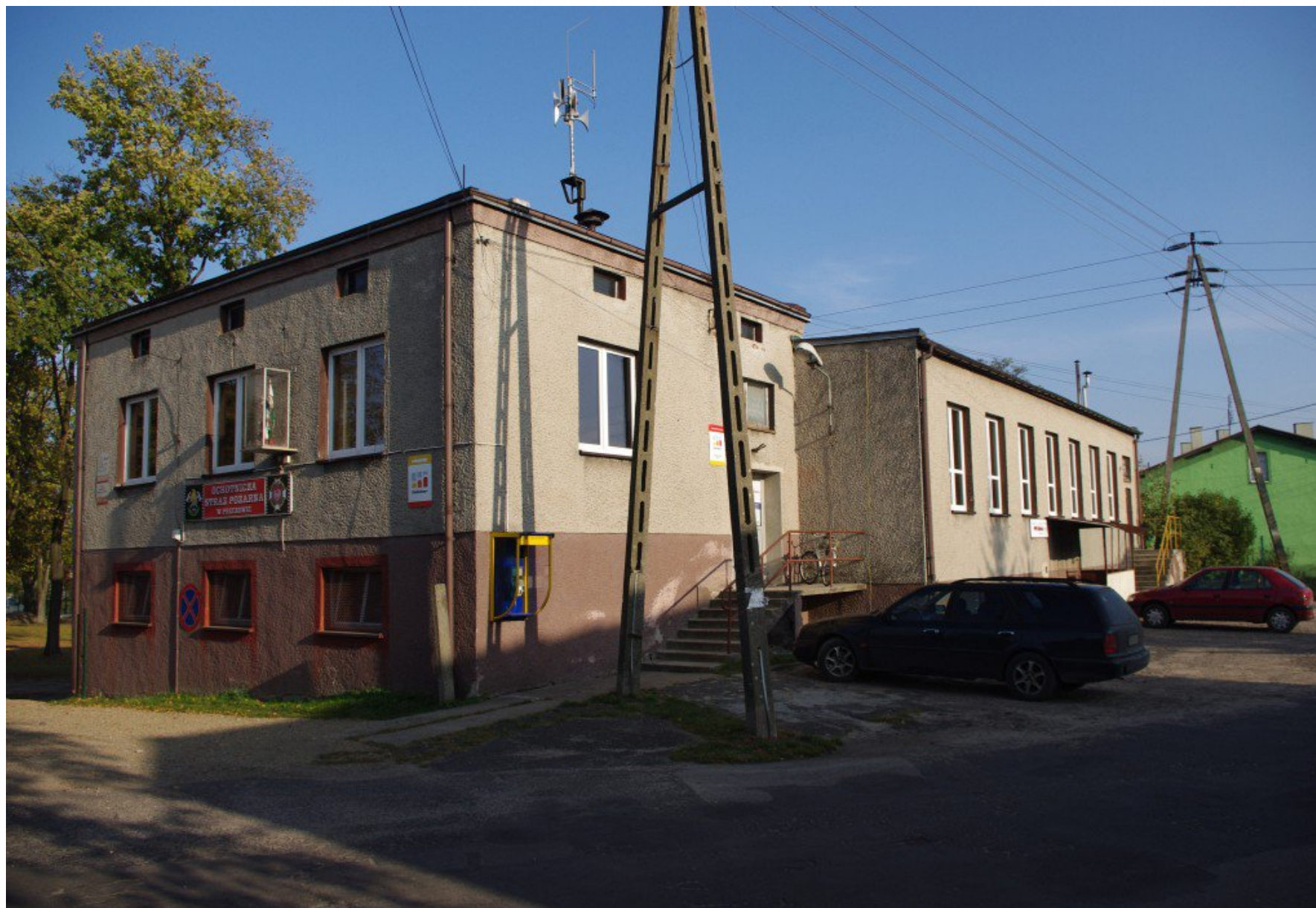
Obiekt przed remontem
