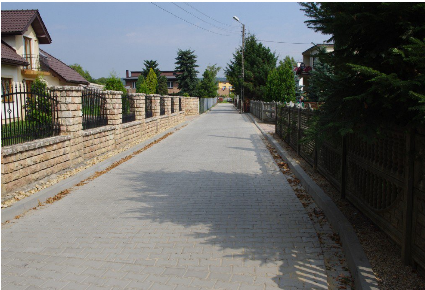
ul. Reymonta po zakończeniu prac
