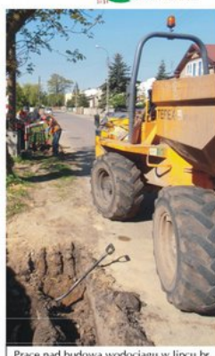
Prace nad budową wodociągu w lipcu br.
