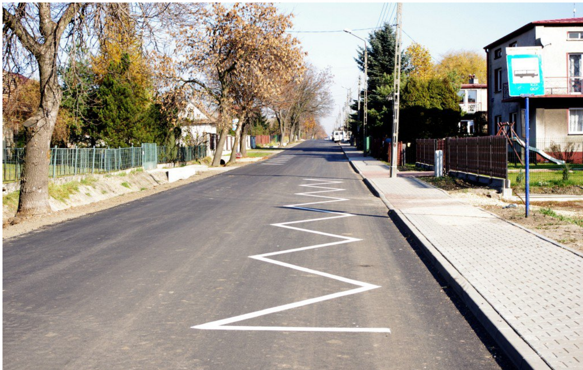
ul. Graniczna po przebudowie
