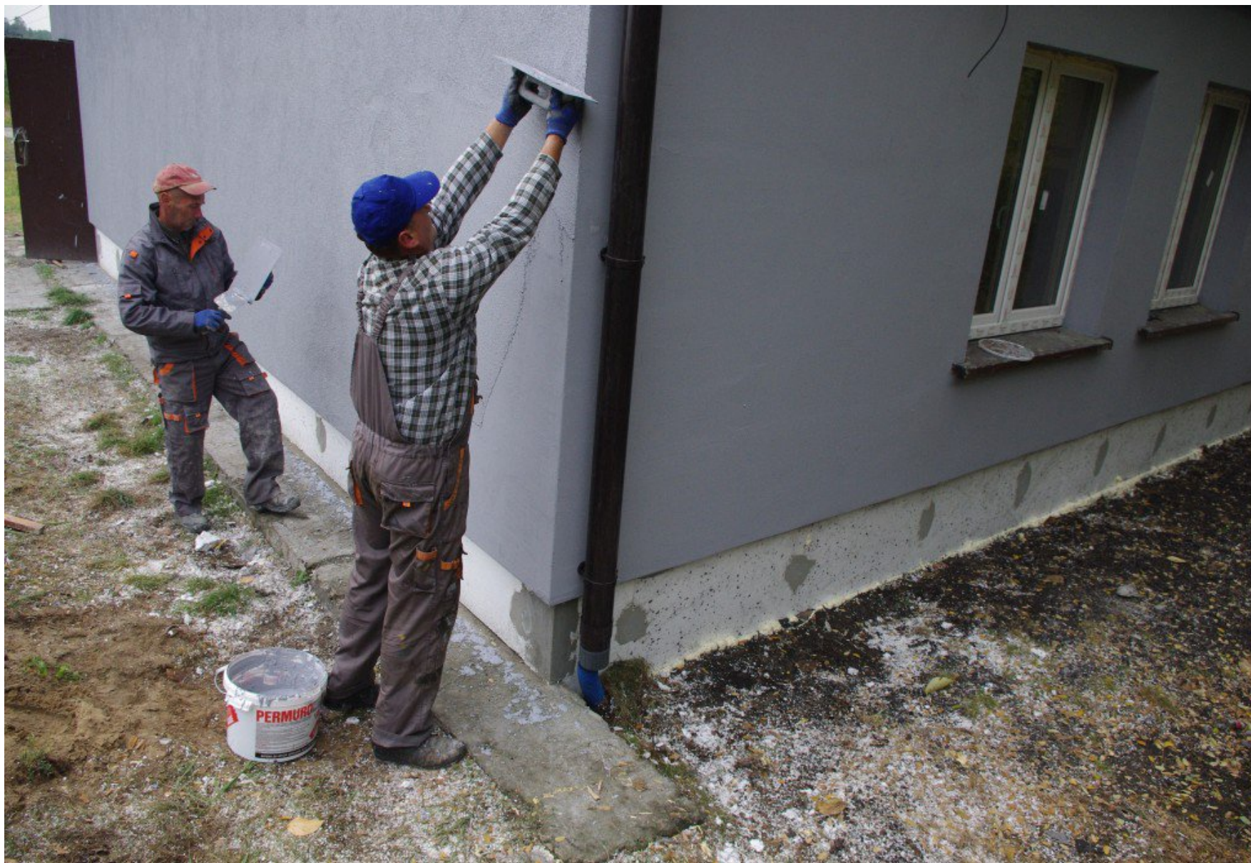
Remont budynku szatni na stadionie Orła Dąbie
