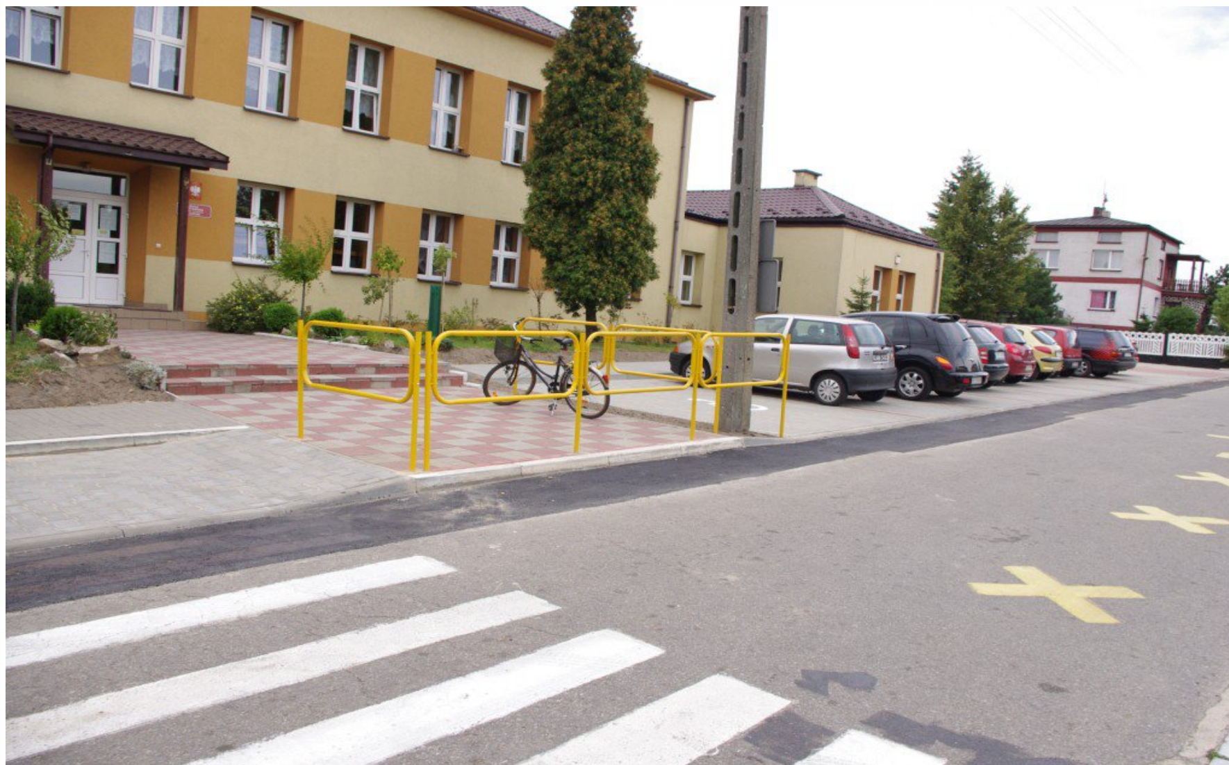
Budowa parkingu przy szkole i przedszkolu w Sarnowie
