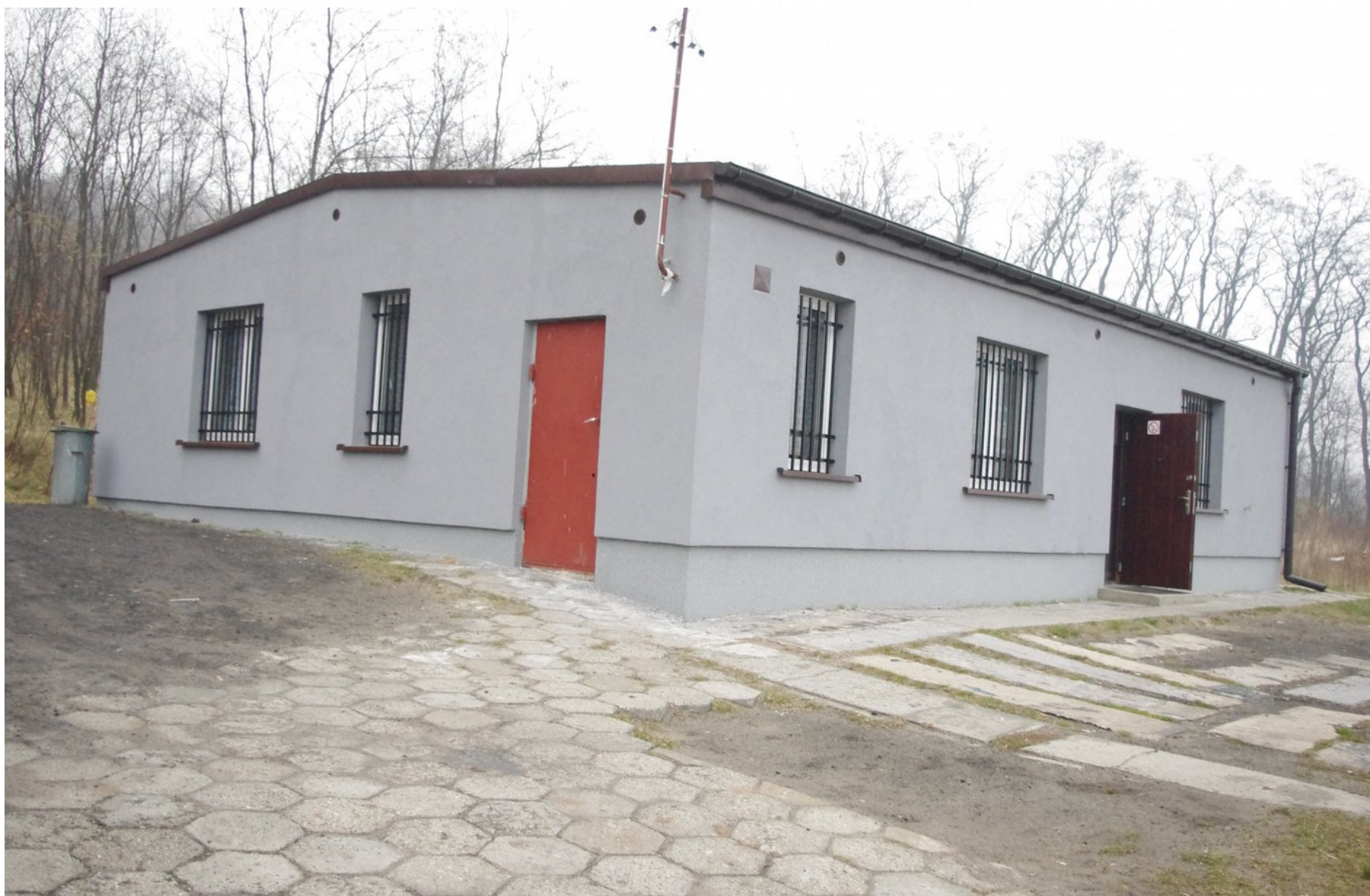
Budynek szatni po remoncie
