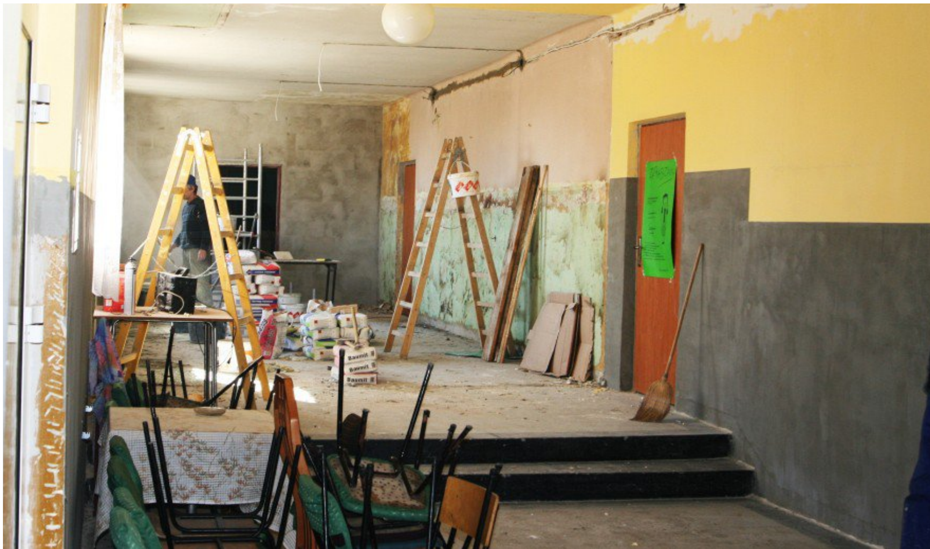
Remont pomieszczeń w budynku byłej szkoły w Malinowicach
