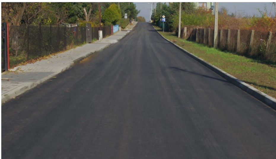
Fragment 766-metrowego odcinka przebudowanej ul. Łącznej w Psarach
