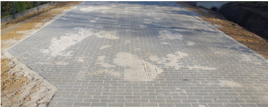
Nowa droga w Brzękowicach Górnych świeżo po oddaniu do użytku
