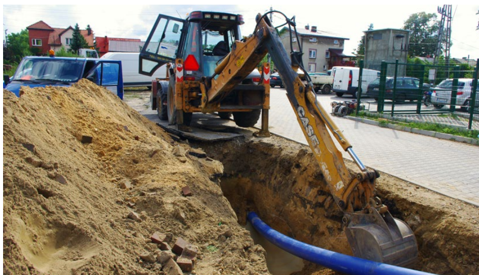
Przykład robót ziemnych wykonywanych przez ZGK
