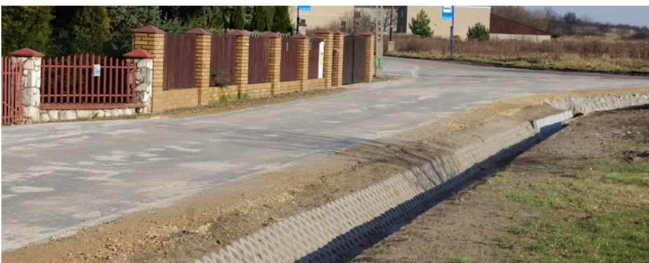
Fragment nowej drogi z widocznym odwodnieniem
