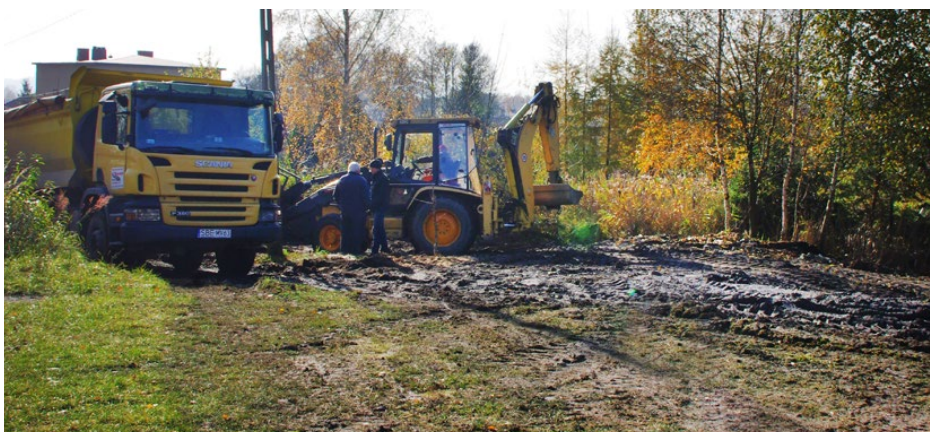
Pierwsze maszyny na modernizowanym stadionie w Strzyżowicach
