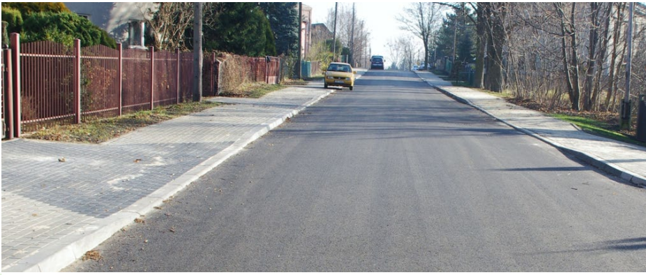
Ulica Boczna w Psarach z chodnikami i ponad 900 m infrastruktury kanalizacyjnej
