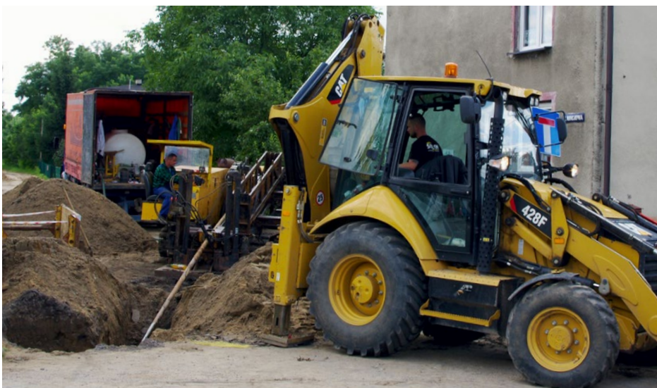
Wykonywanie przewiertu sterowanego pod drogą
