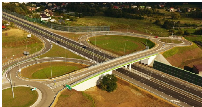
W ramach inwestycji zamontowano też nowe ekrany akustyczne
