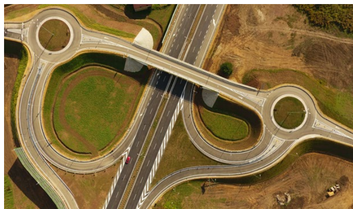
Widok na nowy węzeł komunikacyjny na DK86 z lotu ptaka
