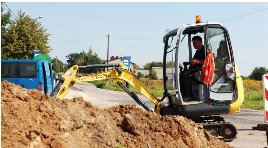
Przy okazji budowy drogi modernizowany jest również wodociąg
