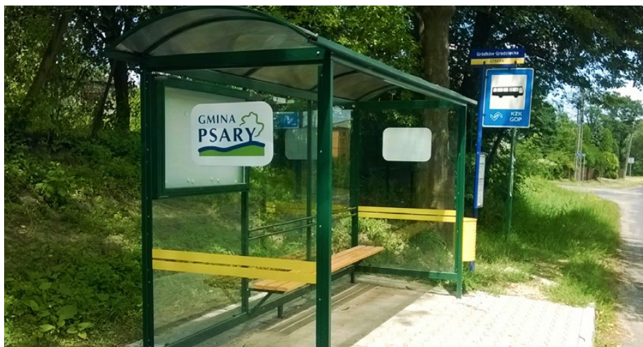
Wymieniona w tym roku wiata przystankowa w Gródkowie
