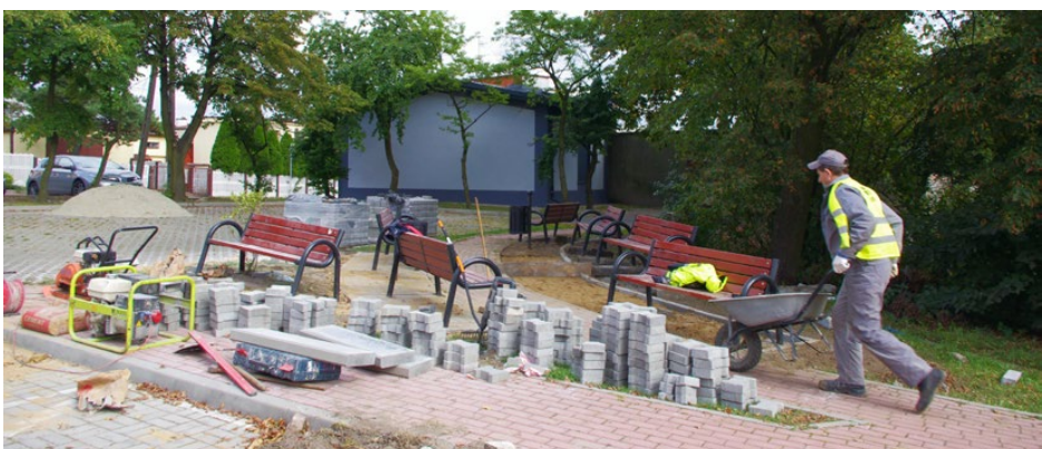
Początek remontu na placu przy remizie w Sarnowie
