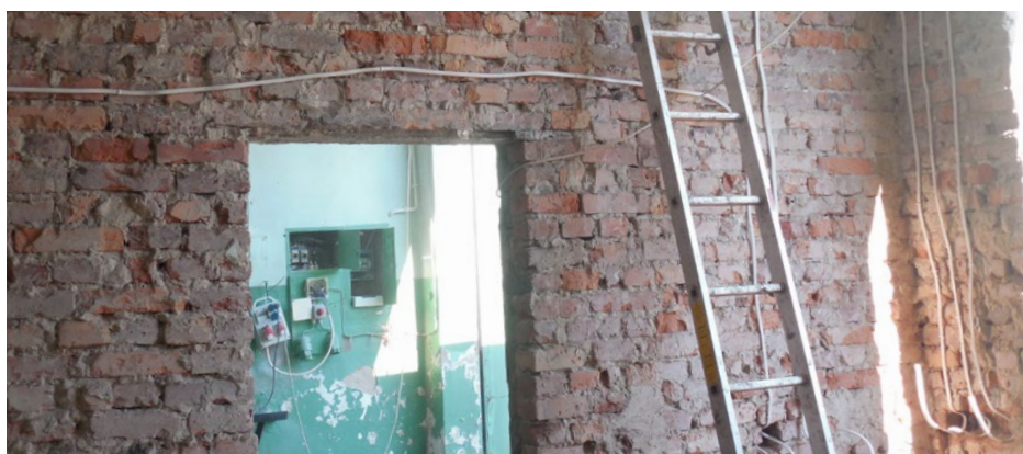
Prace remontowe w garażach w Dąbiu
