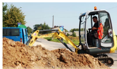
s. 3 INWESTYCJE Budowa drogi w Brzękowicach G.
