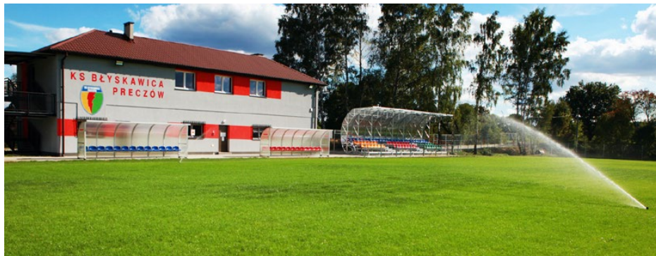
Stadion w Preczowie po ostatnich pracach budowlanych
