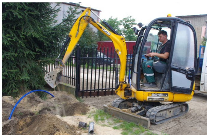
Budowa przyłączy za pomocą miniparki
