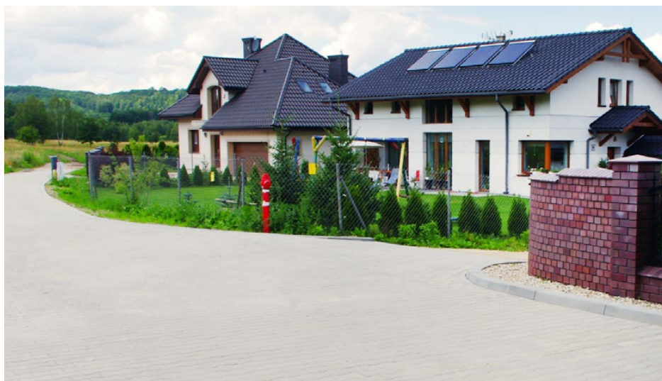
Ulica Strumyczna w Malinowicach po remoncie
