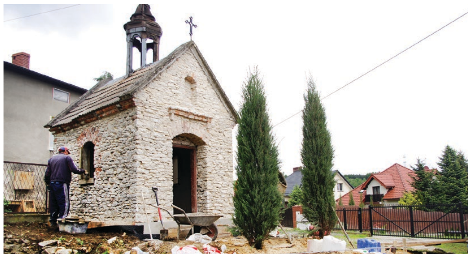
Prace remontowe kapliczki na Poddzwonku
