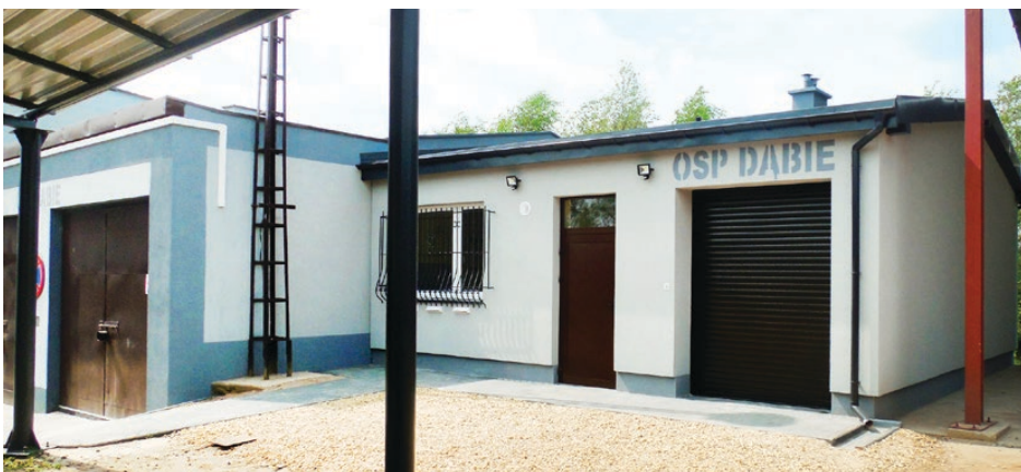
Dobudowana część budynku OSP Dąbie
