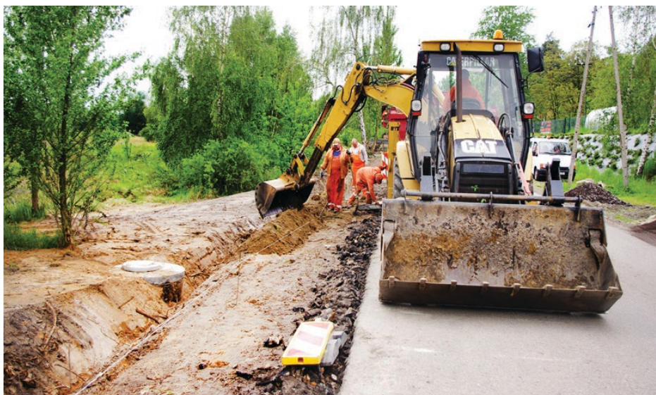
Prace przy budowie chodnika w Gołąszy Dolnej
