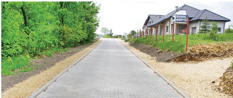
Ukończona droga na ulicy Brzękowie - Wał
