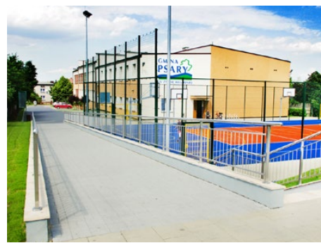
Widok od strony kompleksu boisk
