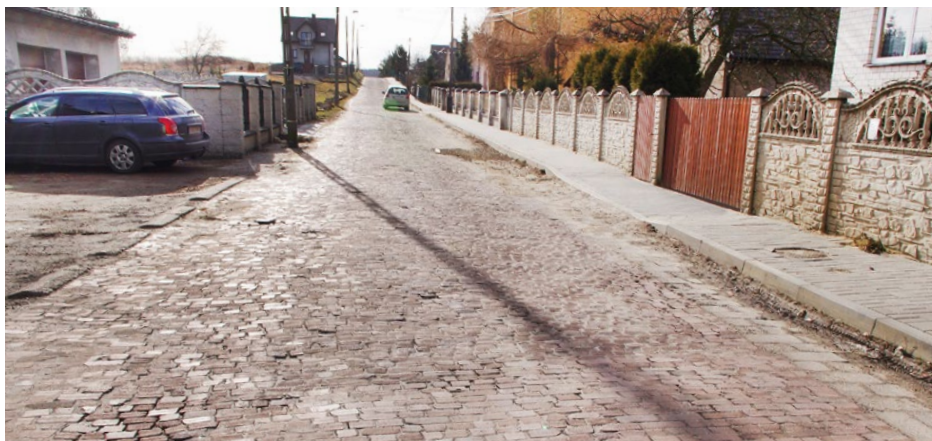
Ulica Łączna w Psarach przed gruntownym remontem
