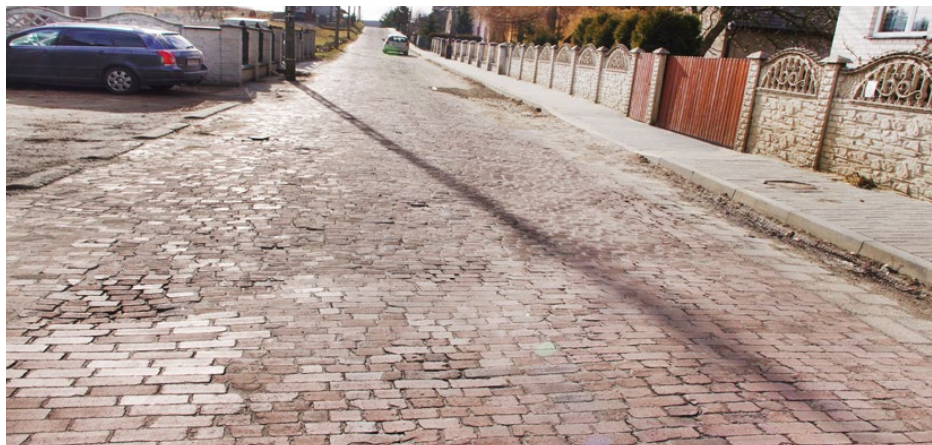
Ulica Łączna w Psarach przed planowaną w 2016 roku przebudową
