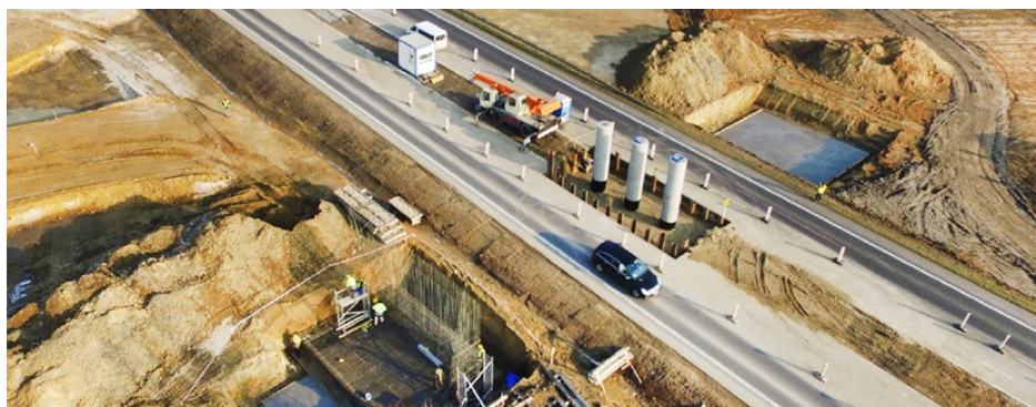
Budowa węzła komunikacyjnego. Foto: materiały prasowe DL Invest
