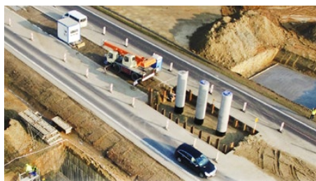
s. 3 INWESTYCJE Postępy w budowie węzła na DK86
