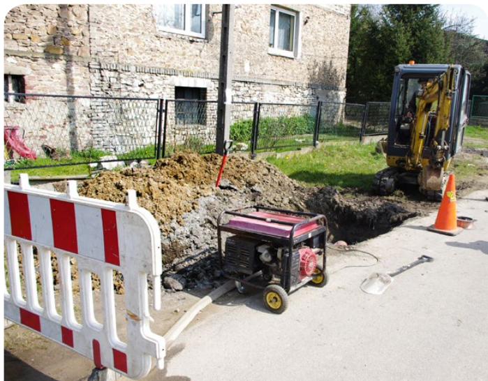
Intensywne prace przy wymianie sieci wodociągowej trwają m.in. w Psarach, Strzyżowicach, Samowie (ul. Nowa) i Gródkowie (ul. Wspólna). Największe zadania zrealizowano z unijną dotacją 3,2 mln zł.
