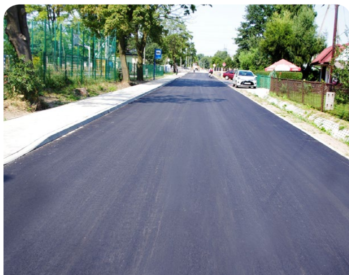
Zakończono przebudowę ulicy Szkolnej w Preczowie. Wykonano 1012 mb. drogi z asfaltobetonu. Koszt: 1 924 641,41 zł, dofinansowanie z NPPDL: 963 721 zł.
