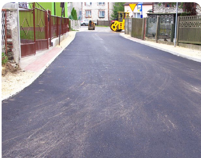
Wyremontowano ulicę Zieloną w Malinowicach oraz odcinek łączący ul. Kościuszki z ul. Szopena w Górze Siewierskiej. Roboty te kosztowały 81 999,99 zł brutto.
