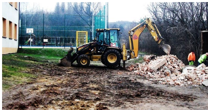
Rozbiórka budynku gospodarczego przy szkole
