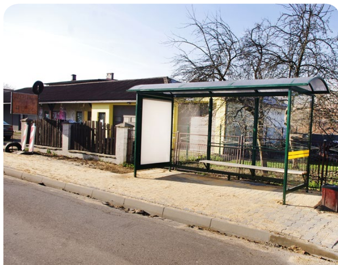
Dzięki gminnej dotacji blisko 920 tys. zł. budowane są chodniki przy drogach powiatowych w Psarach, Strzyżowicach, Górze Siewierskiej i Preczowie. W Psarach na ul. Malinowickiej zabudowano też wiatę przystankową.
