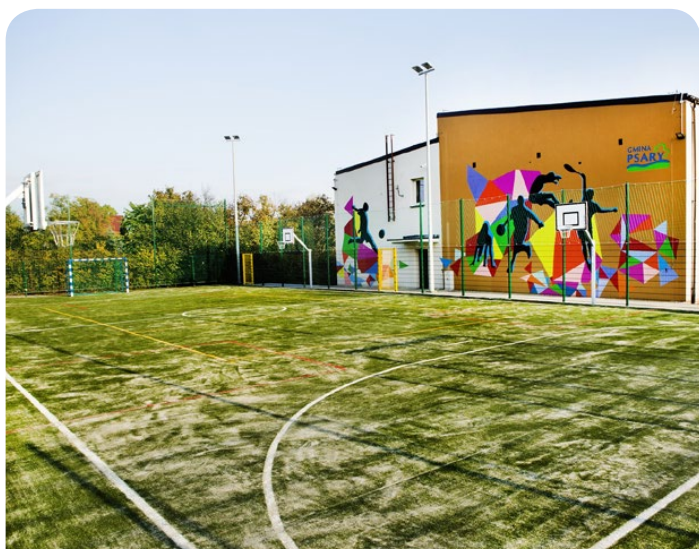
Zakończono budowę boiska wielofunkcyjnego wraz ze skocznią w dal przy szkole w Dąbiu. Koszt inwestycji: 440 000 zł, dotacja krajowa: 133 333 zł.
