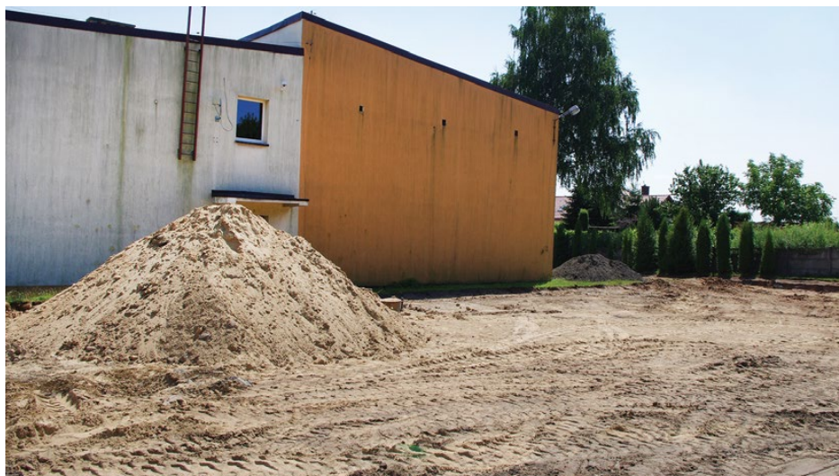
Prace nad budową boiska wielofunkcyjnego już się rozpoczęły
