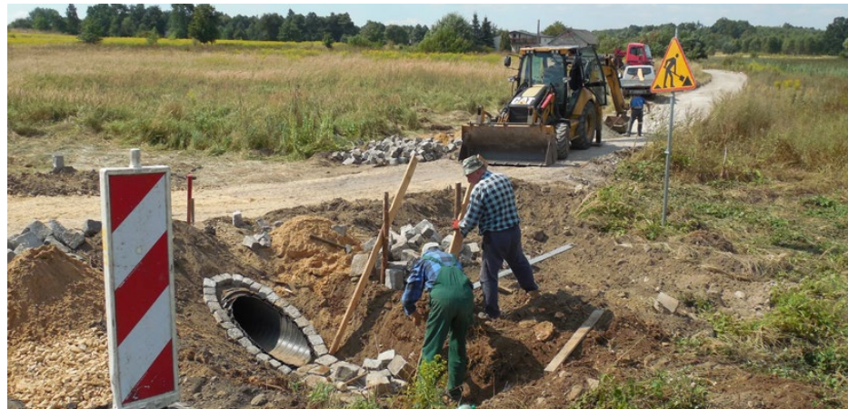
Niedawno rozpoczęte prace remontowe na ul. Zielonej
