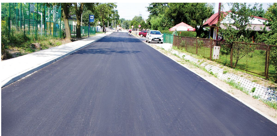
Widoczne postępy w budowie ul. Szkolnej w Preczowie
