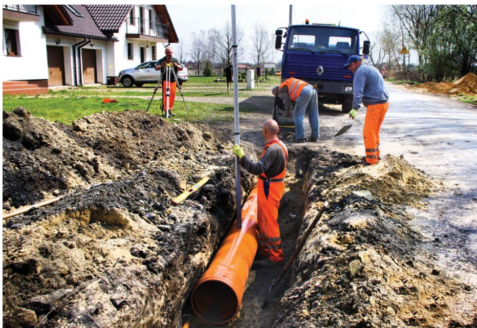
Prace nad budową kanalizacji deszczowej przy ul. Szkolnej w Preczowie
