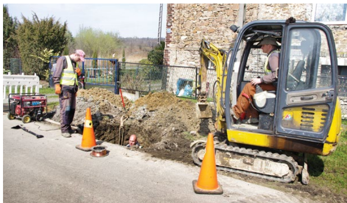
Prace na ul. Kasztanowej w Psarach od strony ul. Belnej
