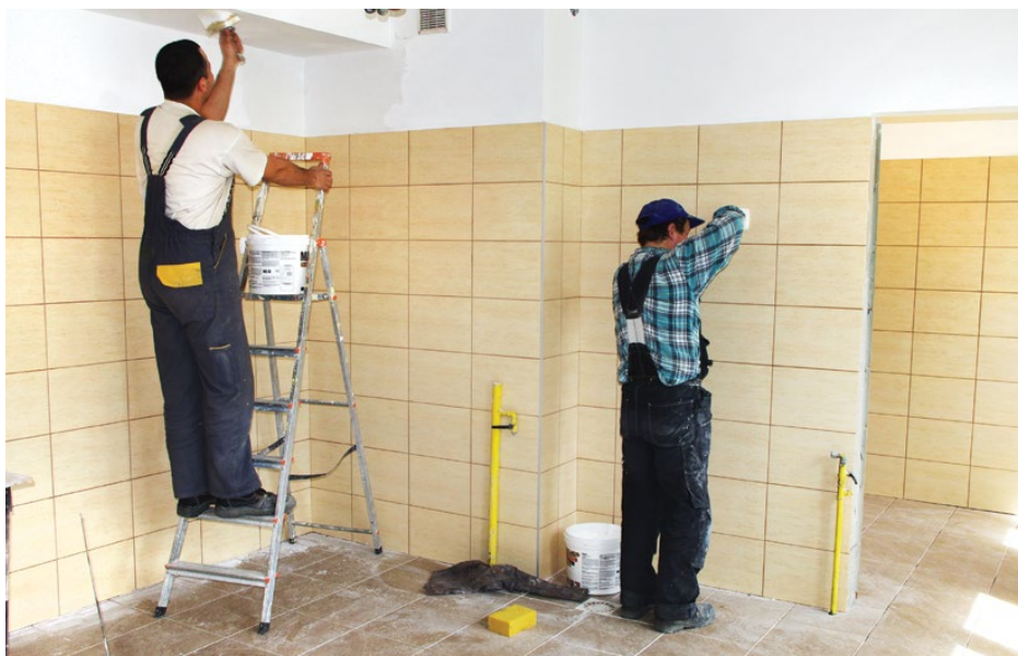
Prace wykończeniowe w kuchni w remizie OSP Dąbie
