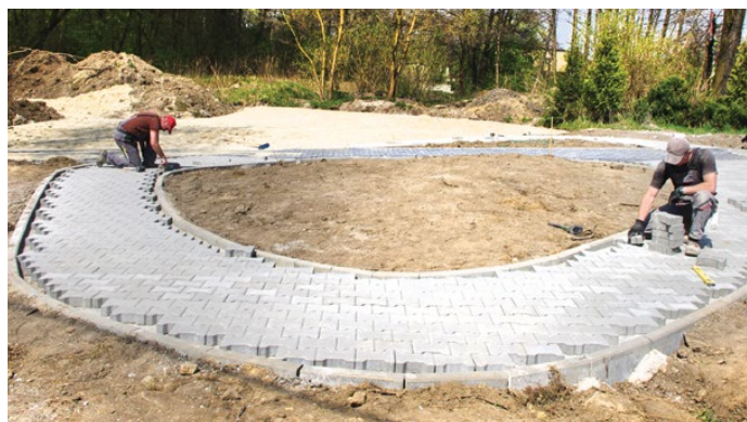
Prace na placu w Malinowicach
