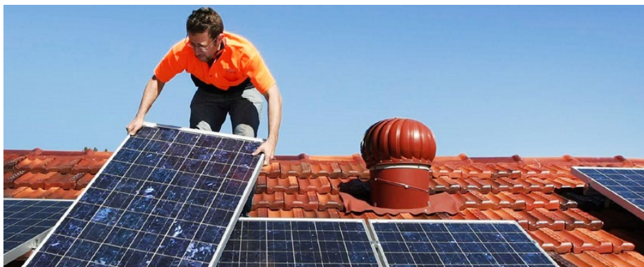
Montaż przykładowych paneli fotowoltaicznych na dachu domu
