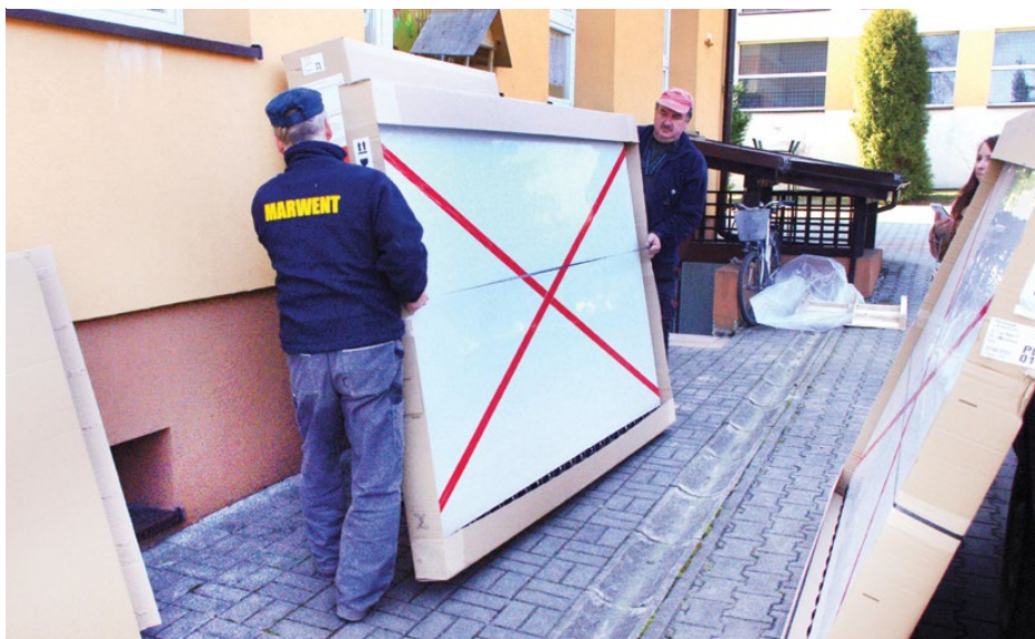
Na dachu strzyżowskiego przedszkola rozpoczęto montaż solarów
