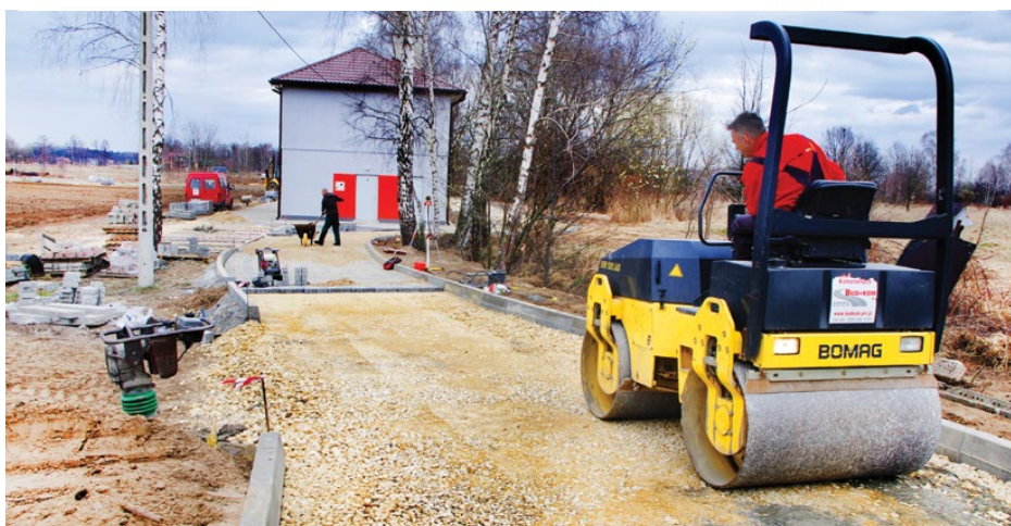
Prace nad budową drogi dojazdowej do budynku LKS Błyskawica Preczów
