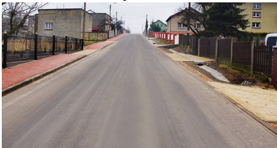
Wybudowano ul. Kościuszki w Górze Siewierskiej
