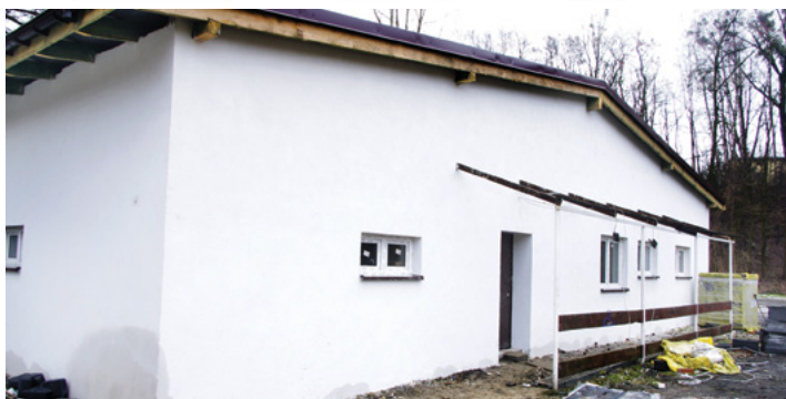
Budynek został rozbudowany i jest kompleksowo remontowany
