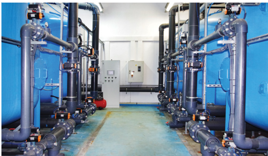
Rozbudowana stacja uzdatniania wody w Malinowicach
