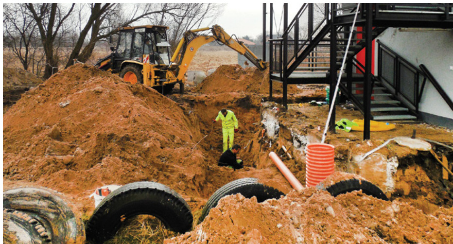
Prace budowlane na boisku Błyskawicy Preczów
