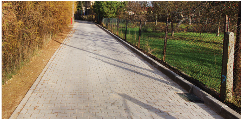
Nowa nawierzchnia z kostki betonowej na ul. Bocznej w Strzyżowicach
