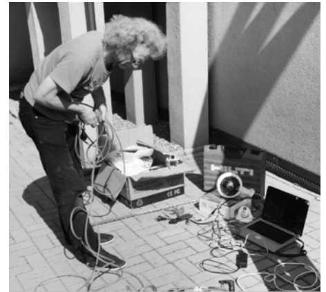
Prace przy montażu monitoringu
