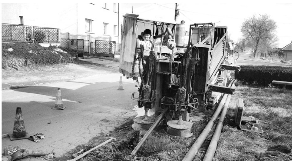
Prace przy wymianie wodociągu na ul. Belnej w Strzyżowicach
