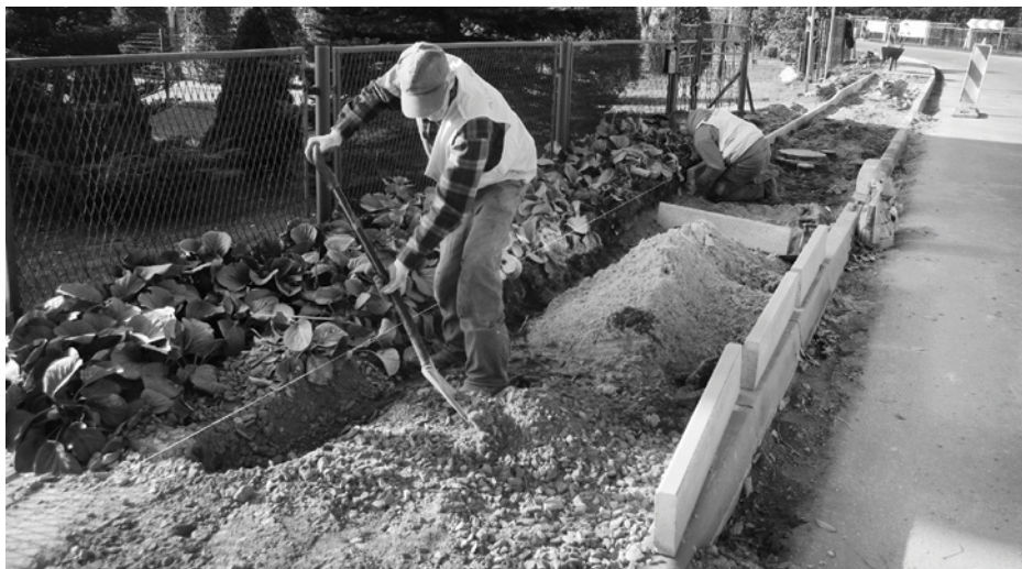
Prace nad budową chodnika w Psarach
