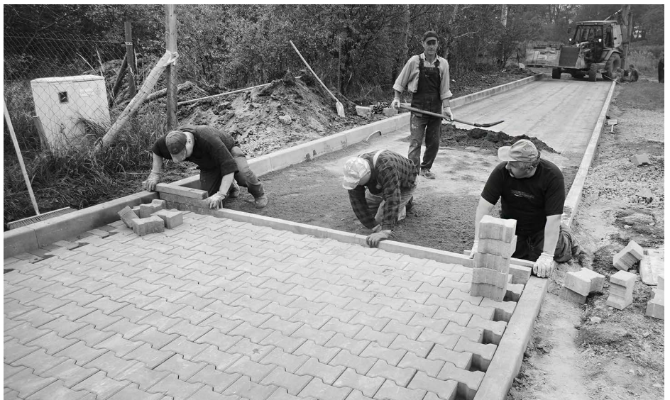
Układanie kostki na ulicy Bocznej w Strzyżowicach
