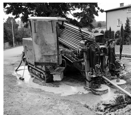
Prace na ul. Gródkowskiej w Psarach
