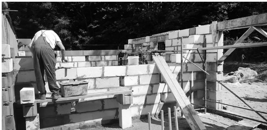
Prace podczas rozbudowy szatni w Górze Siewierskiej
