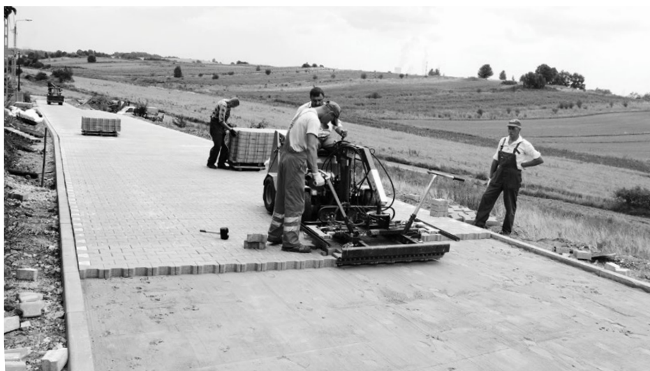
Tak wyglądały prace nad budową odcinka ul. Belnej w 2012r.
