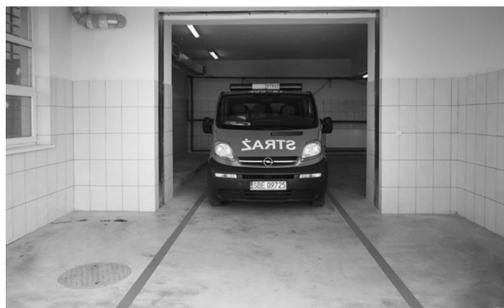
Nowa posadzka przemysłowa w garażu OSP Góra Siewierska
