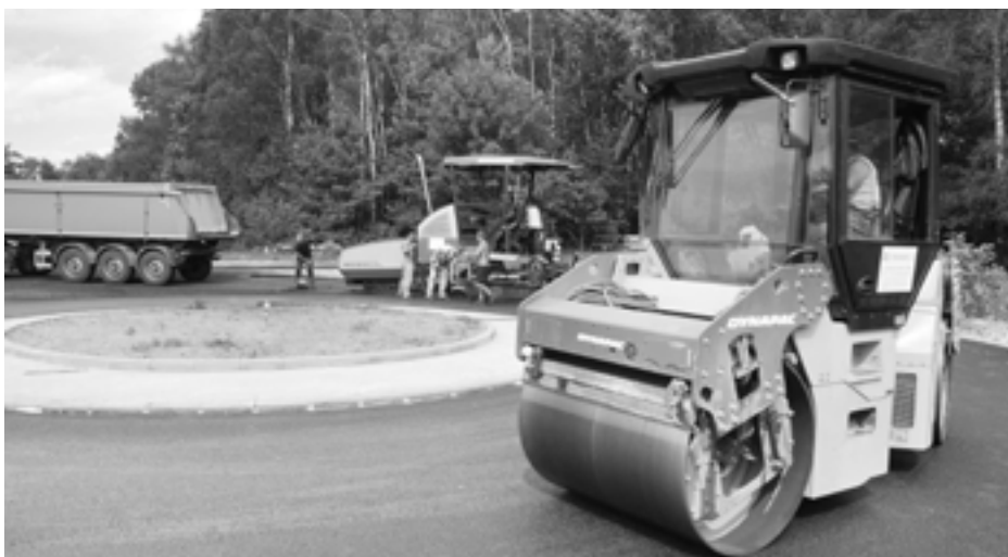
Prace nad budową pętli w Malinowicach
