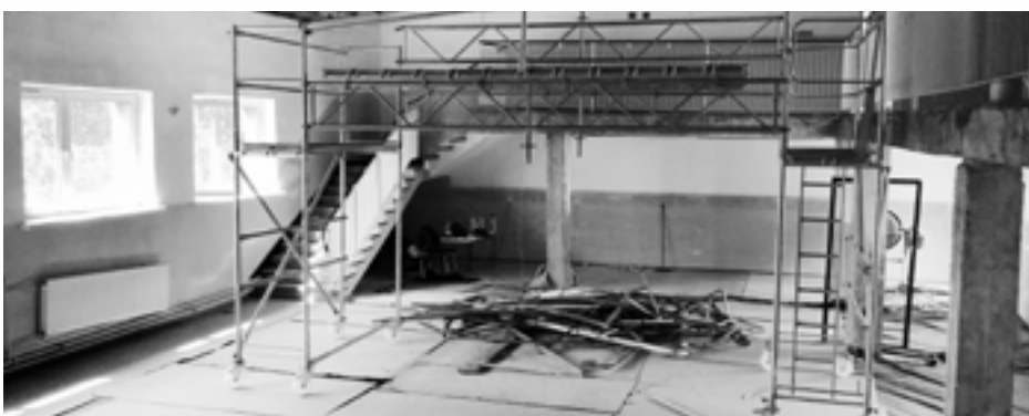
Prace remontowe na sali bankietowej w Dąbiu
