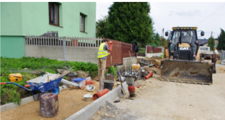
Budowa ul. Kościuszki w Górze Siewierskiej
