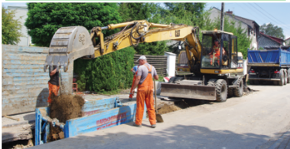
Budowa odwodnienia na ulicy Belnej w Strzyżowicach
