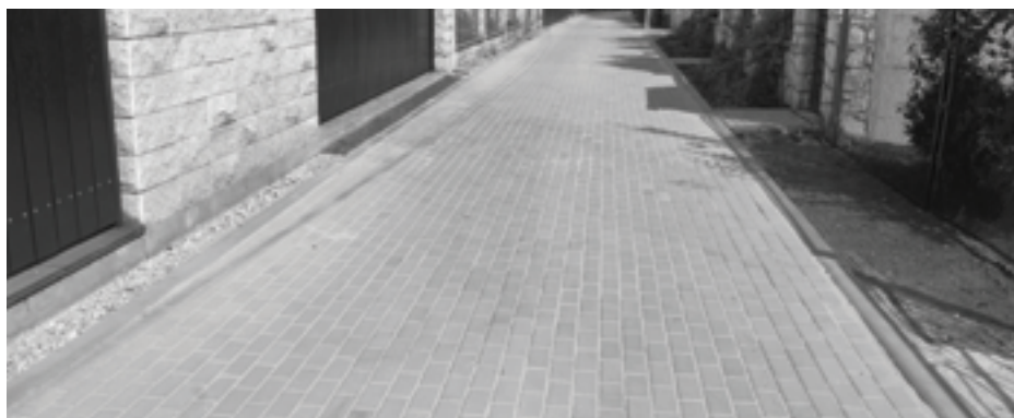
Nowa nawierzchnia z kostki brukowej na ul. Zielonej w Preczowie
