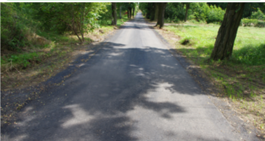
Nowo wybudowana ul. Parkowa w Sarnowie
