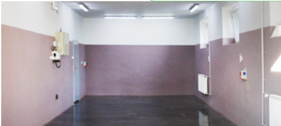
Wyremontowany garaż OSP Preczów z posadzką przemysłową
