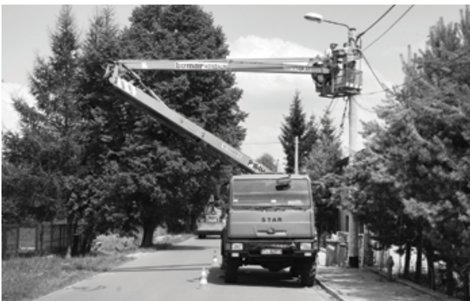
Prace przy przesunięciu słupów oświetleniowych na ul. Granicznej w Psarach
