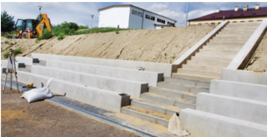
Podbudowa pod trybuny na kompleksie sportowym w Sarnowie
