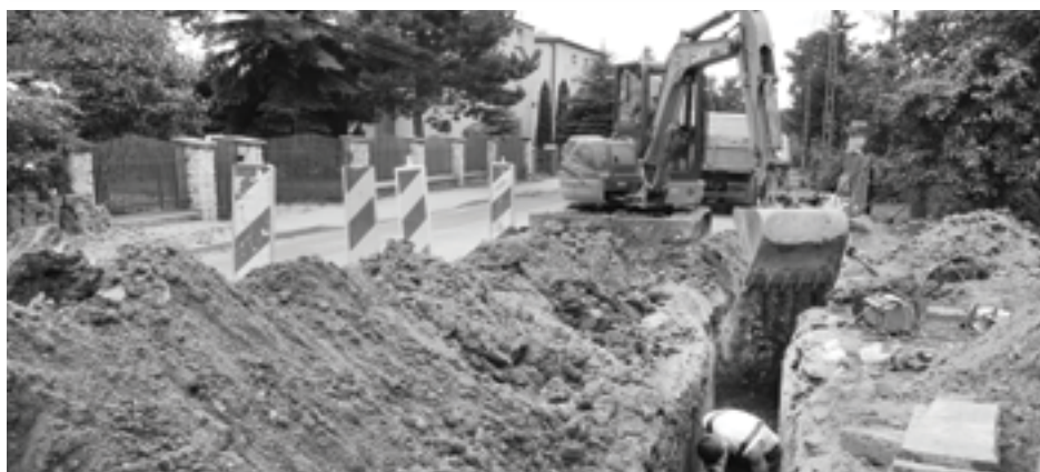
Prace przy wymianie wodociągu w Psarach
