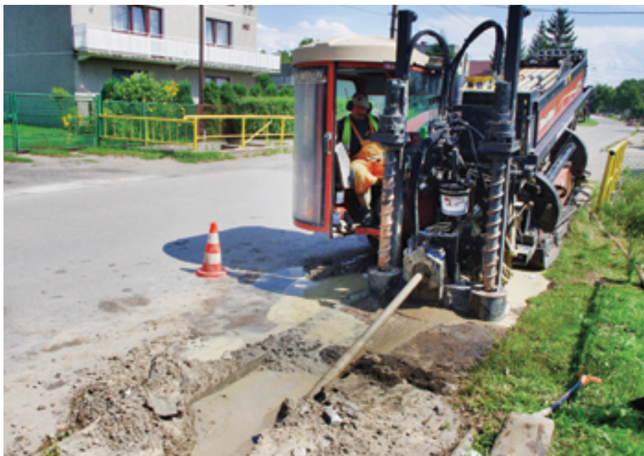
Prace przy wymianie wodociągu metodą przewiertu sterowanego w Psarach
