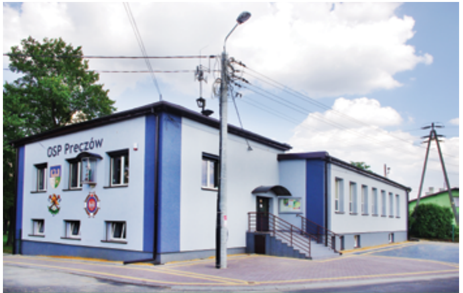
Nowy parking przed budynkiem OSP w Preczowie
