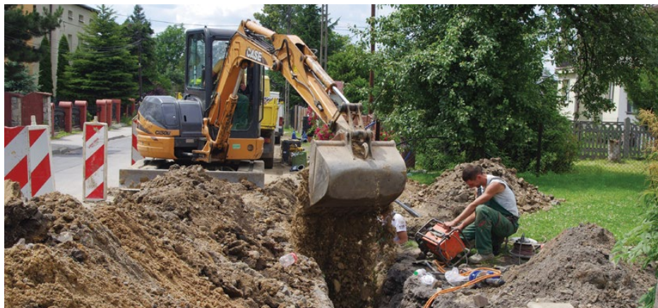
Obecnie trwa wymiana wodociągu w Psarach przy ulicy Wiejskiej i Szkolnej
