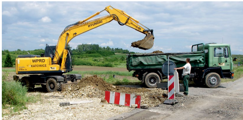
Początek robót na ul. Kościuszki w Górze Siewierskiej
