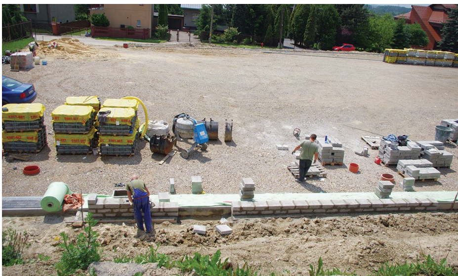
Obecnie trwają prace nad budową trybun
