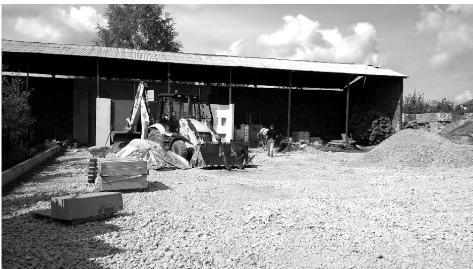
W Dąbiu trwają prace przy budowie punktu selektywnej zbiórki odpadów
