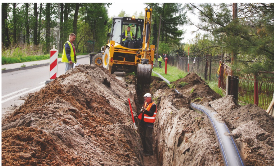
Prace nad wymianą wodociągu na ulicy Malinowickiej w Psarach.
