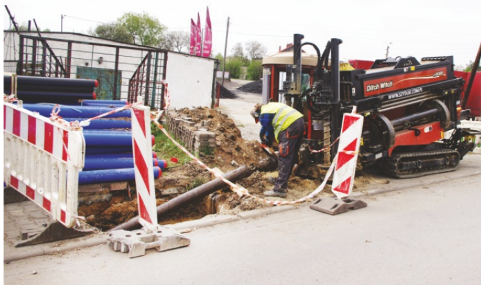
Wymiana wodociągu metodą bezwykopową w Psarach.
