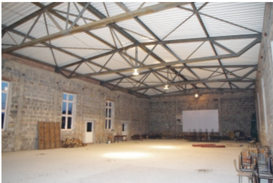
Dzięki unijnym dotacjom dokończona ma być budowa sali w Strzyżowicach, w której powstanie centrum usług społecznych
