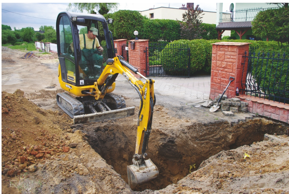
Zakład Gospodarki Komunalnej w 2013r. wybudował 3km sieci wodociągowej
