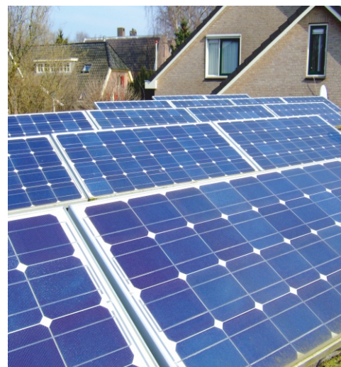
Unijna dotacja dofinansuje montaż instalacji solarnych i wymianę pieców CO
