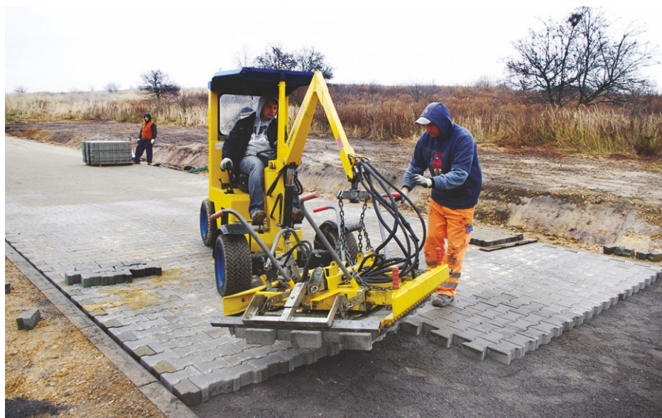
Budowa ulicy Irysów w Psarach
