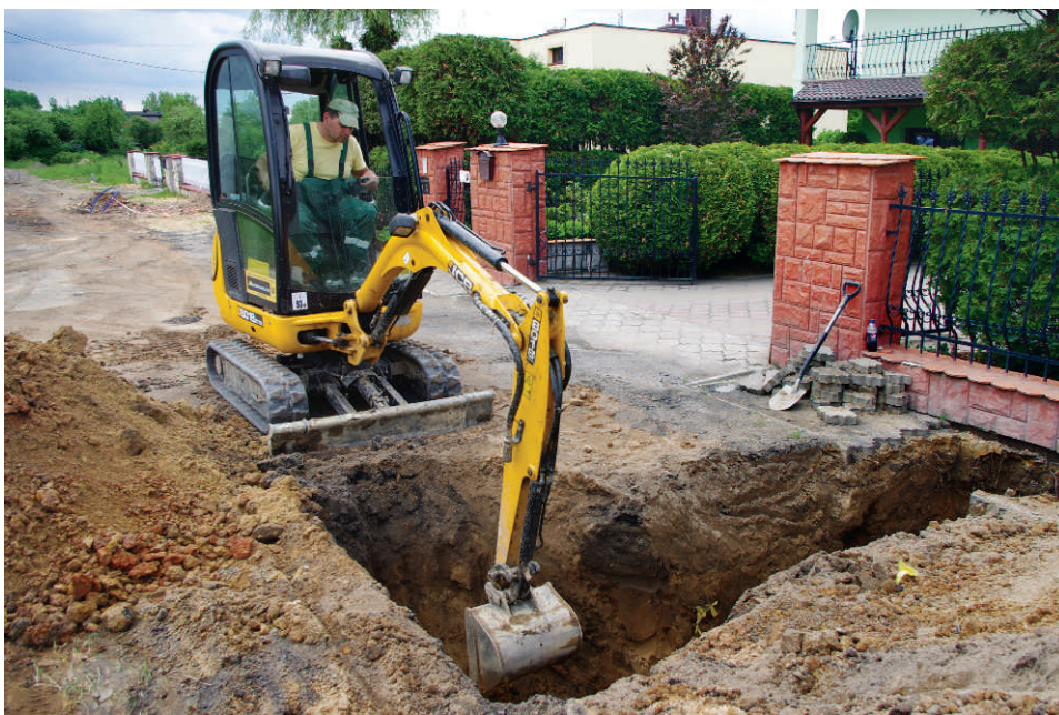
Wymiana wodociągu w Sarnowie w 2013r.
