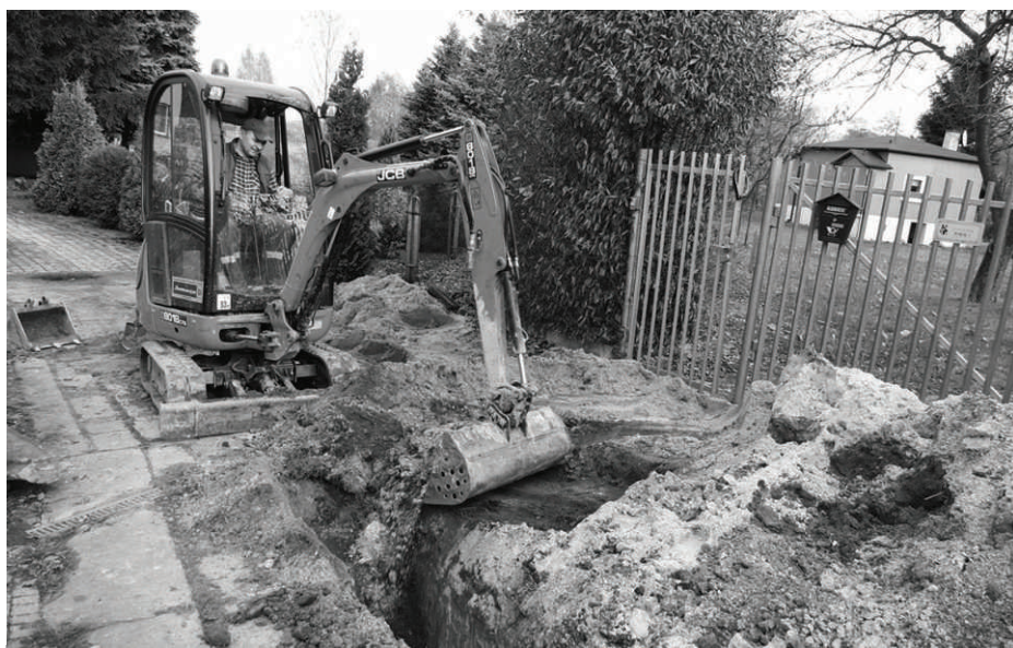
W 2014r. wymieniana będzie sieć wodociągowa w Psarach.
