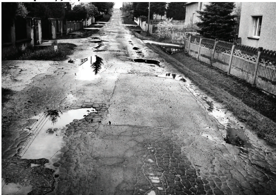
W 2014r. wyremontowana zostanie ulica Kościuszki w Górze Siewierskiej.
