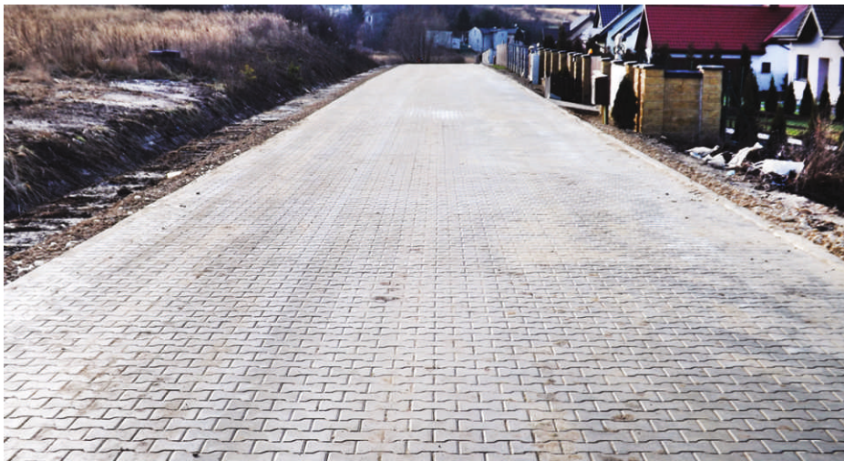
Nowa nawierzchnia z kostki brukowej na ulicy Irysów w Psarach.
