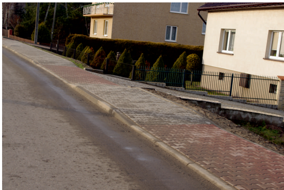
W latach ubiegłych gmina także realizowała budowę chodnika wspólnie z powiatem.
