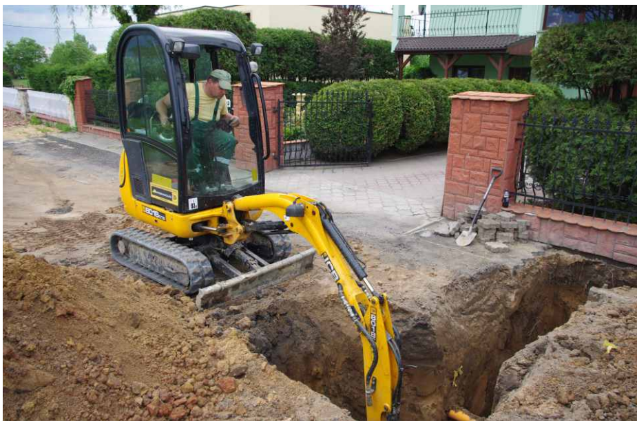
Prace przy wymianie wodociągu w Sarnowie.
