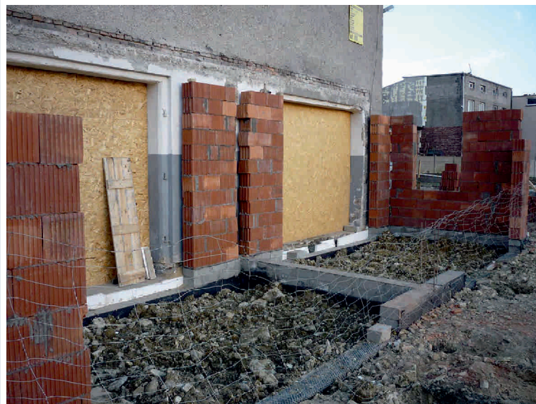
Trwają prace przy rozbudowie i modernizacji garaży.
