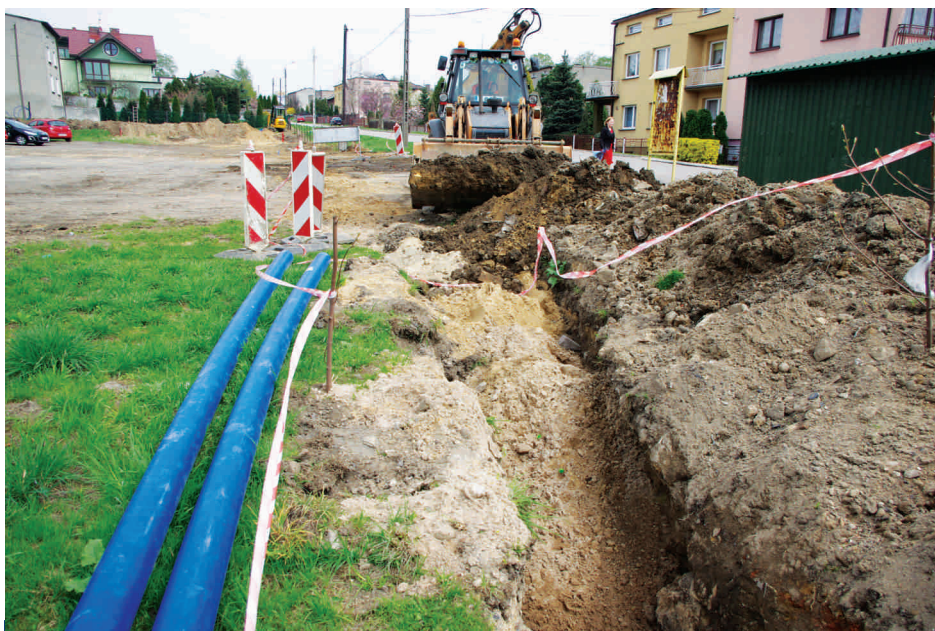
Prace przy wymianie wodociągu w Strzyżowicach przy ul. Belnej.
