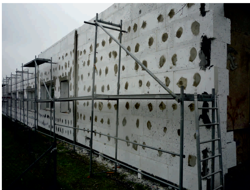
Budynek w Malinowicach podczas prac termomodernizacyjnych.
