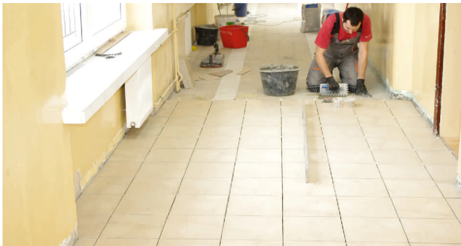
Prace przy układaniu płytek na korytarzu w Strzyżowicach.
