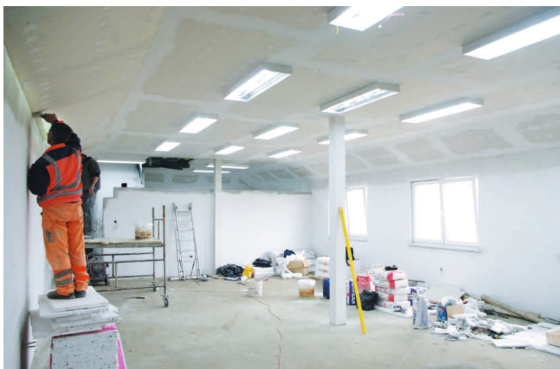
Prace budowlane na piętrze budynku „Błyskawicy Preczów”.
